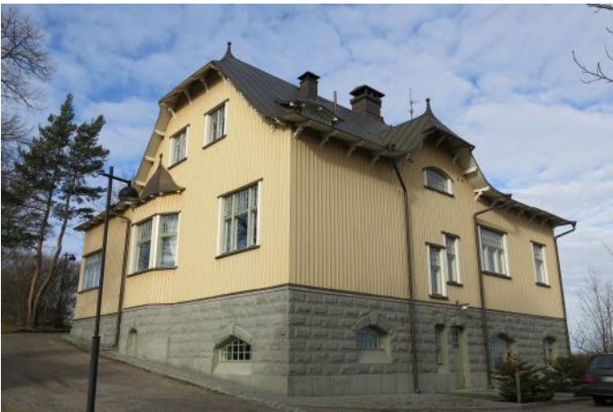
Lavoniuksen talon itäkulma 2000-luvun peruskorjauksen jälkeen. Sokkelia kiertää kiveys. Kuva: Miia Hinnerichsen, Pirkanmaan maakuntamuseo 2016.
