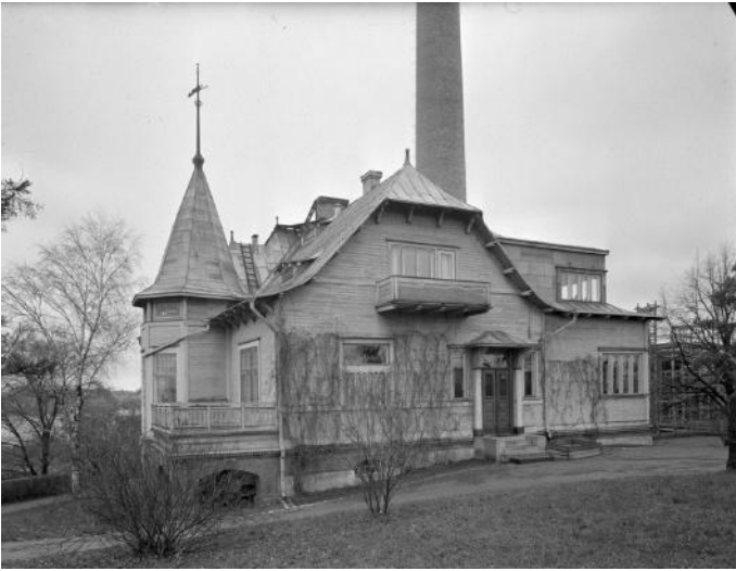
Lavoniuksen talo lännestä 1950. Länsikulmassa on kattamaton parveke ja julkisivuissa vaakalaudoitus. Kuva: E.M. Staf, Vapriikin kuva-arkisto.
