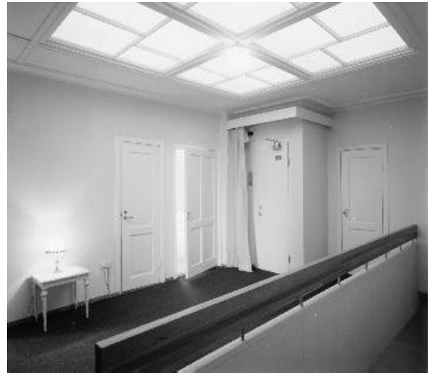
Lavoniuksen talon ullakkokerroksen aula lasikattoineen 1990. Kuva: Ilpo Peuhkuri, Vapriikin kuva-arkisto.
