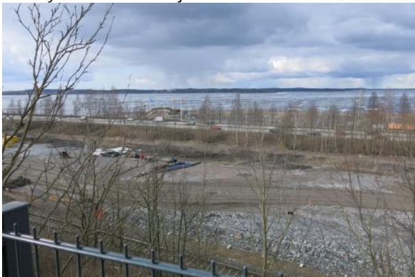
Näkymä Herrainmäeltä luoteeseen täyttömaalle rakennettavan Ranta-Tampellan alueen yli Näsijärvelle.
