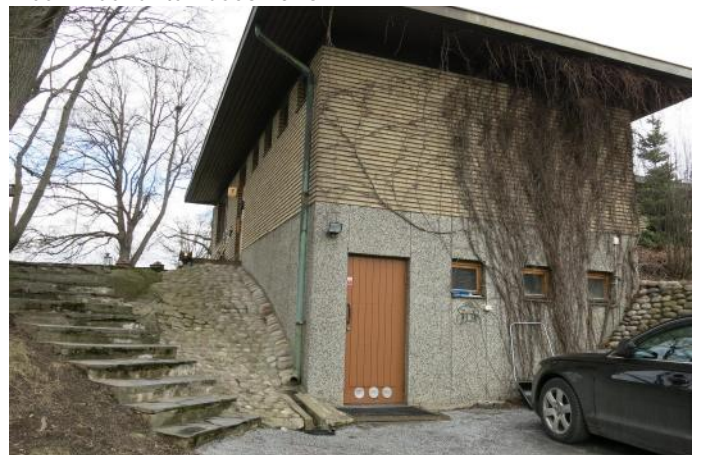
Villa Nykoppin lounaiskulmassa on ovi kellarikerroksen varastotilaan, seinustalla on nupukiveys ja keittiön sisäänkäynnille vievät liuskekivetyt portaat.
