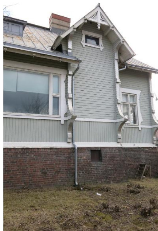
Ryselinin talon Pyhäjärven puoleista luoteissivua. Päätikoristeiden pystysakarit ovat kadonneet. Parvekkeen tilalla on suuri maisemaikkuna. Syvennys, jossa aiemmin oli parveke on otettu asuintilaksi jatkamalla katonlapetta ja tuomalla ulkoseinää ulospäin. Muutos on tehty ikkunan heloituksista päätellen 1950-luvulla.
