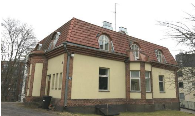
Villa Sandsund, länsisivu. Parvekkeen kaide on vaihdettu metalliseksi ja ikkunat vaihdettu todennäköisesti 1950-luvulla. Kuva: Miia Hinnerichsen, Pirkanmaan maakuntamuseo 2016.
