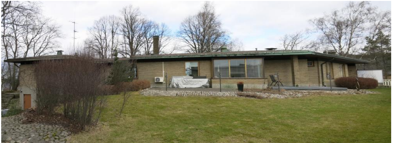
Villa Nykopp etelästä. Terasseja on laajennettu, muutoin rakennus on säilyttänyt alkuperäisen asunsa erinomaisesti.
