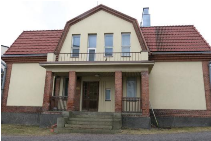
Villa Sandsund, itäsisivu. Parvekkeen kaide on vaihdettu metalliseksi ja ikkunat ja ovet vaihdettu todennäköisesti 1950-luvulla. Kuva: Miia Hinnerichsen, Pirkanmaan maakuntamuseo 2016.
