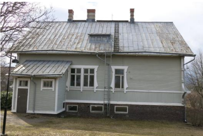
Ryselinin talon koillissivulla on pieni pulpettikattoinen keittiön sisäänkäyntikuisti, jota ei näy alkuperäisessä pohjapiirroksessa. Kuisti on saatettu lisätä rakennusvaiheessa tai viimeistään 1920-luvulla. Kuva: Miia Hinnerichsen, Pirkanmaan maakuntamuseo 2016.
