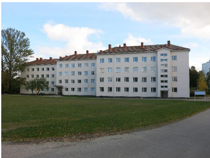
Kyy 166 : 6 Koukkuniemen Havulan luoteisjulkisivua. Mirkku Haapasaari 09.10.2015
