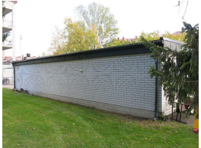
Koukkuniemen kioskirakennuksen takajulkisivu kuvattuna lännestä.
