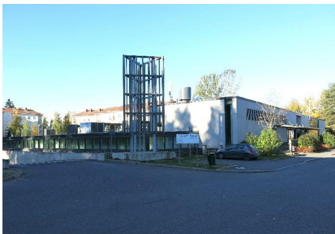
Kyy 166 : 74 Koukkuniemen ravinto- ja huoltokeskus idästä kuvattuna. Vasemmalla ajoluiska alas huoltopihalle. Mirrku Haapasaari 09.10.2015
