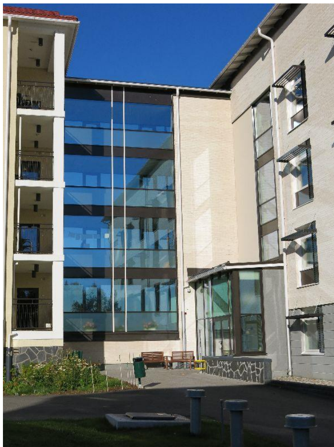
Kyy 166 : 4 Koukkuniemen Impivaaran (oikealla) ja Jukolan välinen yhdyskäytävä sisäpihan puolelta. Mirkku Haapasaari 09.10.2015
