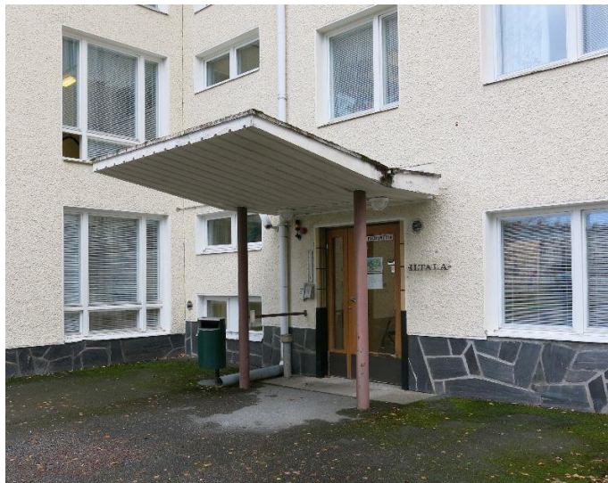
Kyy 166 : 54 Koukkuniemen Iltalan A portaan sisäänkäynti rakennuksen itäpuolella. Mirrku Haapasaari 27.10.2015
