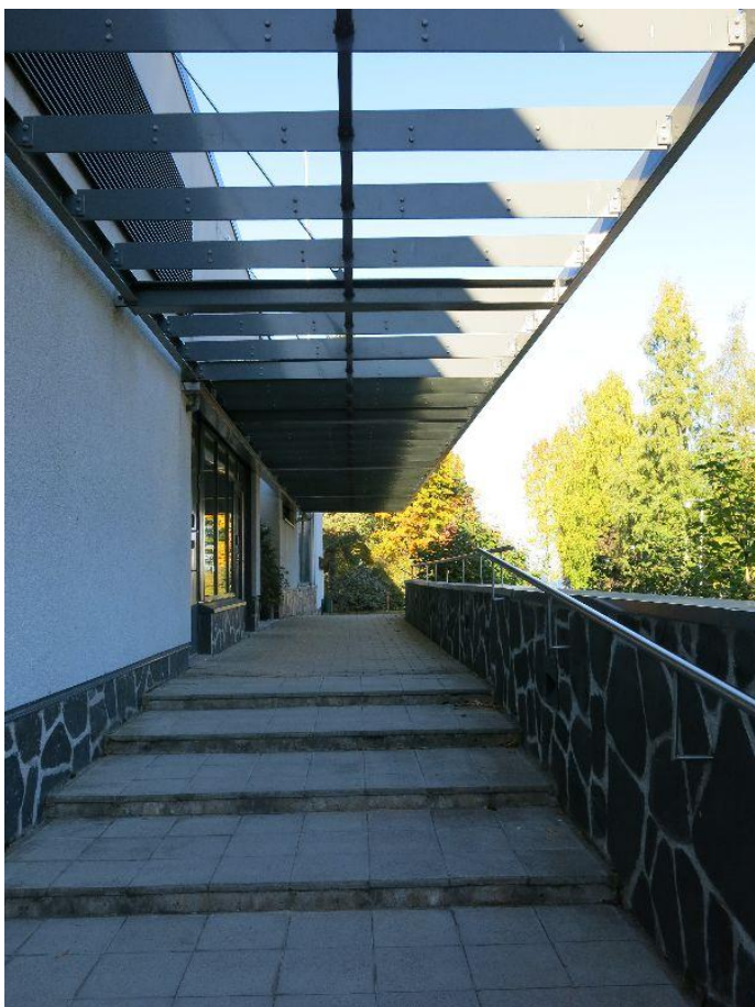
Kyy 166 : 73 Koukkuniemen ravintokeskus, pääsisäänkäynti rakennuksen koillispuolella. Mirrku Haapasaari 09.10.2015
