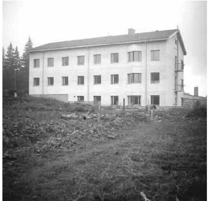
TKA Kosonen : 306:1 Koukkuniemen uusia rakennuksia: asuinrakennus Pekka Kosonen 17.09.1951
