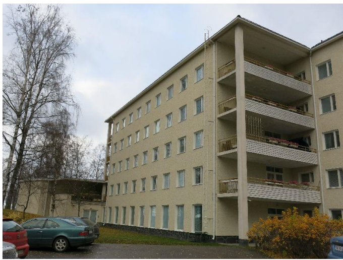
Kyy 166 : 51 Koukkuniemen Iltalan läntistä julkisivua. Rakennuksen päädyssä Juhlatalo. Mirkku Haapasaari 27.10.2015
