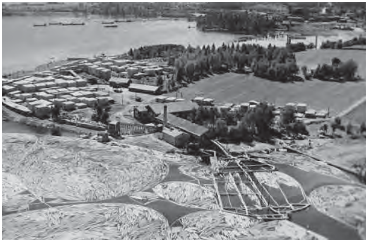
Ilmakuva Niemen sahan alueesta koillisesta kuvattuna. Kuvasajankohta tuntematon. (Kuvälähde: Kantonen, 1999–2000 → M-Realin arkisto)
