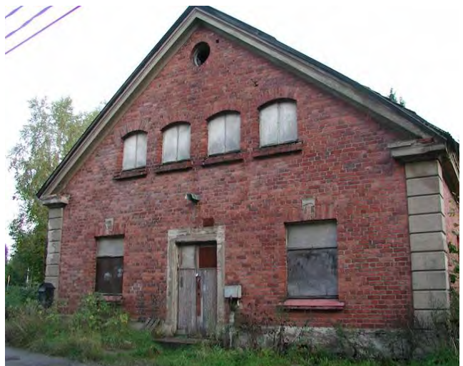
1.Saunan kaakkoissivu ja lounaispäätty, joissa ikkunoiden ja ovien koristerappaukset rapautuneet.
