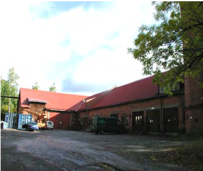
1.3.Navetan luoteissivuun tehdyt muutokset.
