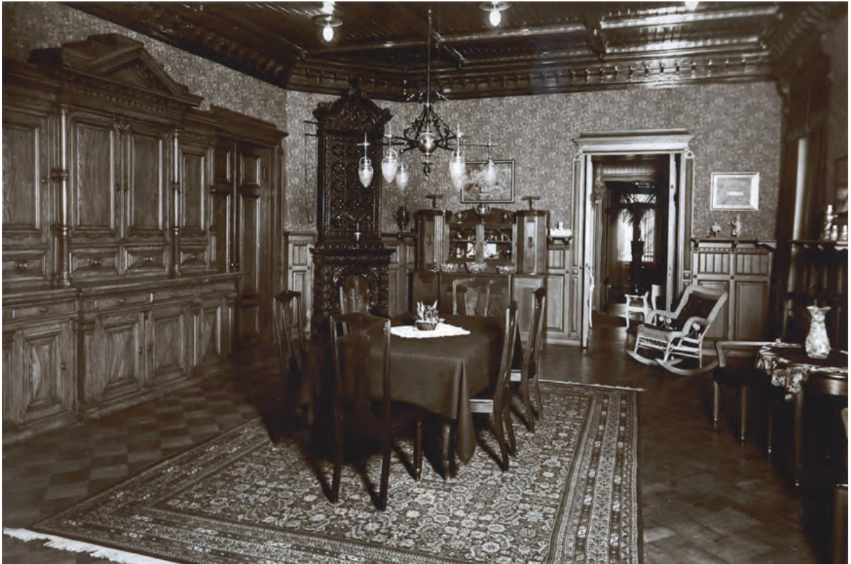
Ruokasali M.P. Lampénin isännöitsijäkaudelta (1919-1936). Sisustus on todennäköisesti alkuperäinen. Seinien alaosissa on panelointi ja oven vuorilauta on koristeellinen. Astiakaappi ja puinen kasettikatto ovat Höijerin suunnittelemia. Kuva Ritva Jaakkolan arkisto.
