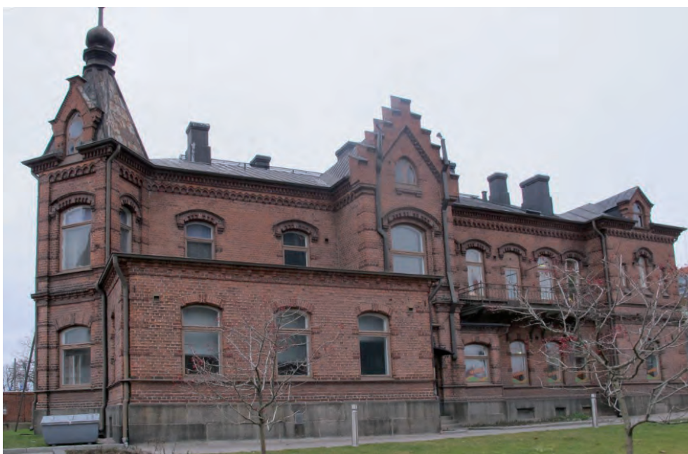
Julkisivu Hotelli Ilveksen suuntaan v. 2012.. Lounaiskulmassa on Wivi Lönnin suunnittelema laajennus vuodelta 1921.
