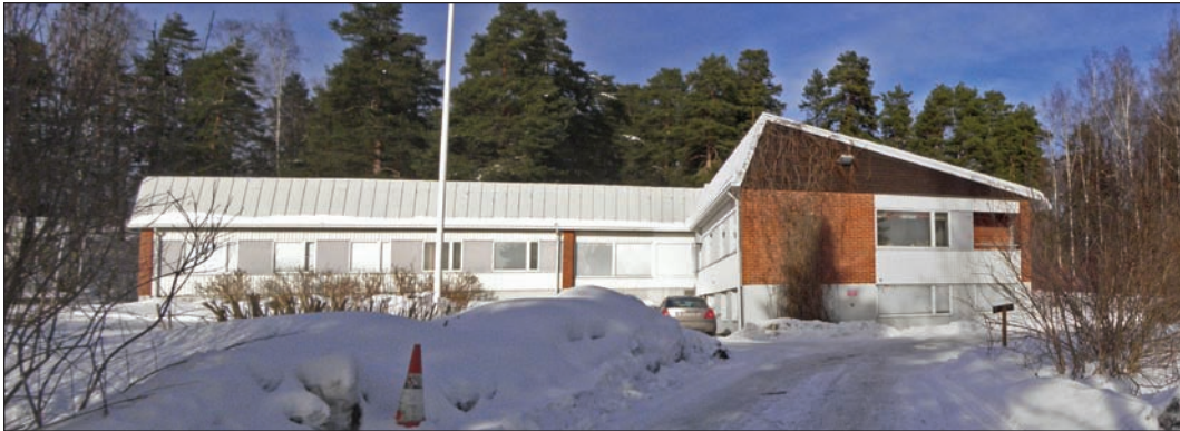
Raholan lastenkodin julkisivu etelään Voionmaankadulle.
