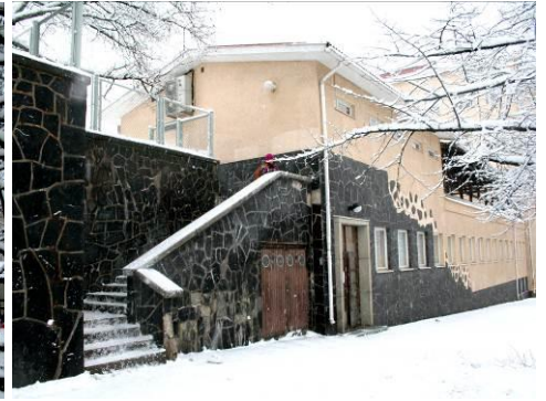
Satakunnankadun varren tukimuuri on verhoitu liuskekein, jotka muodostavat terveystilojen rakennussiiven julkisivuun kivivyöryaiheen. Porras toimii oikoreittinä Satakunnankadulta koulun pihalle.
