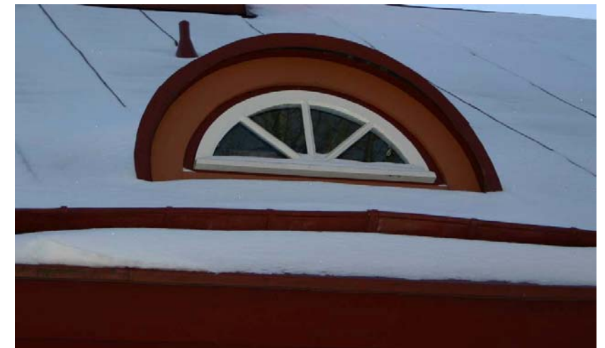
Katolla säilynyt lunetti-ikkuna
