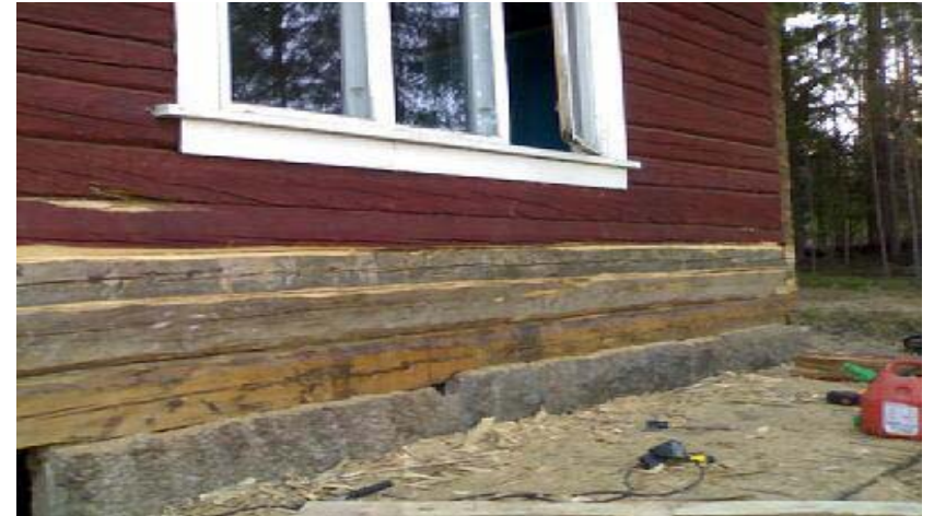
Kengitetty talon pääty. Kolme alinta hirttä on vaihdettu. Kuva: Kalle Klemola
