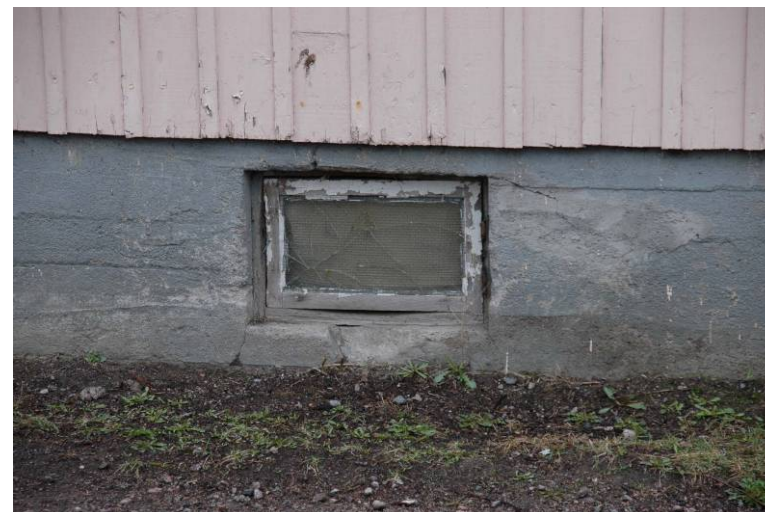
Rakennusten perustukset ovat valettu betonista. Usein kellariin haluttiin myös vähän valoa, joten perustukseen jätettiin paikka kellari-ikkunalle.
