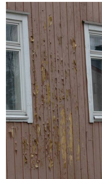
Lateksimaalilla maalattu seinä voi näyttää tältä muutaman vuoden kuluttua maalauksesta.
