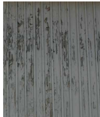
Lateksimaalilla maalattu seinä voi näyttää tältä muutaman vuoden kuluttua maalauksesta.
