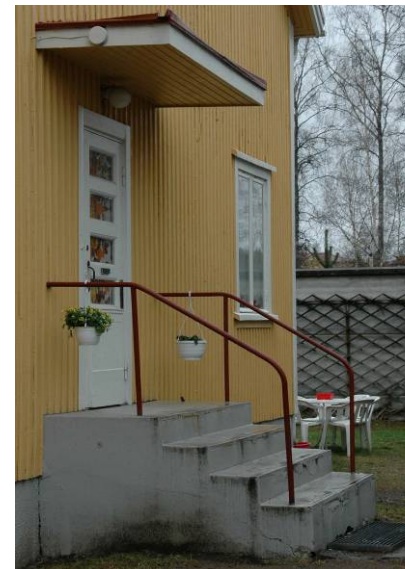
30-luvun rakennuksen tyyppinen kuisti; lippa oven päällä
