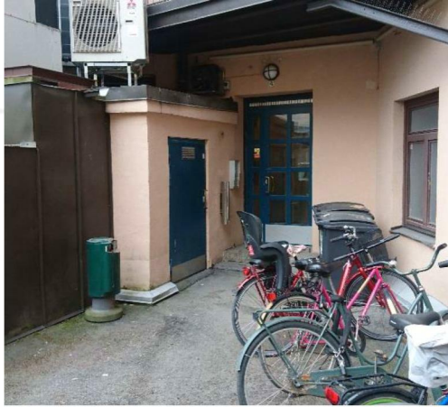
Kuva 2 Käynti Rautatienkatu 14 mittaus tilaan sisäpihalta
