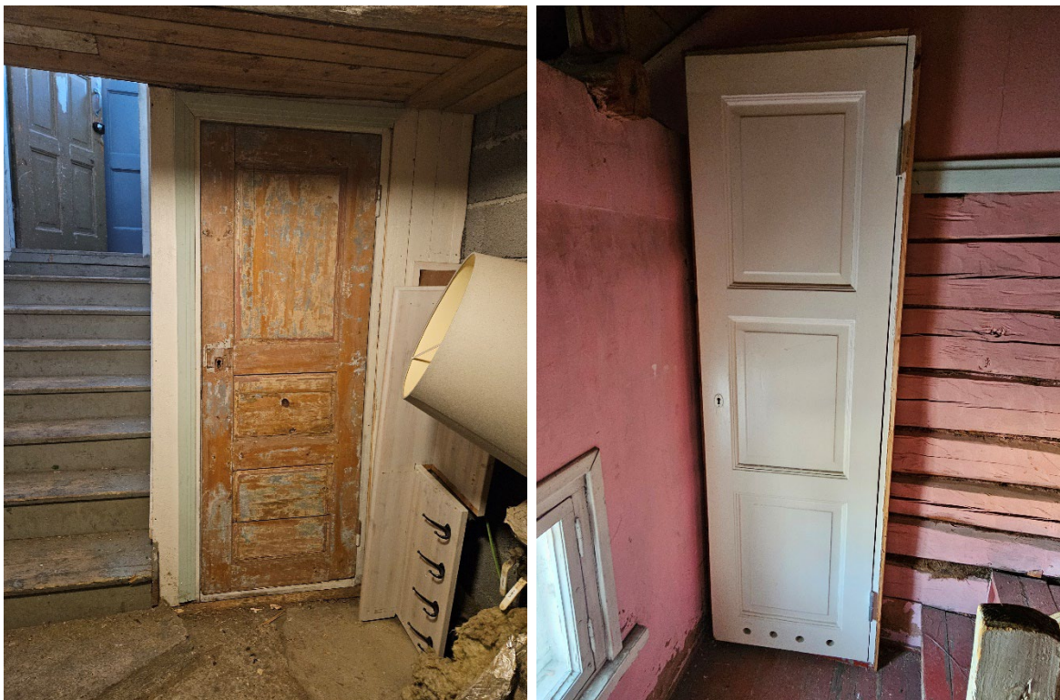
Kuva 53 Vasemmalla kellarin portaat ja komeron ovi, oikealla ullakolle vievän portaikon maalattua hirsiseinää ja irrotettu wc:n ovi.
