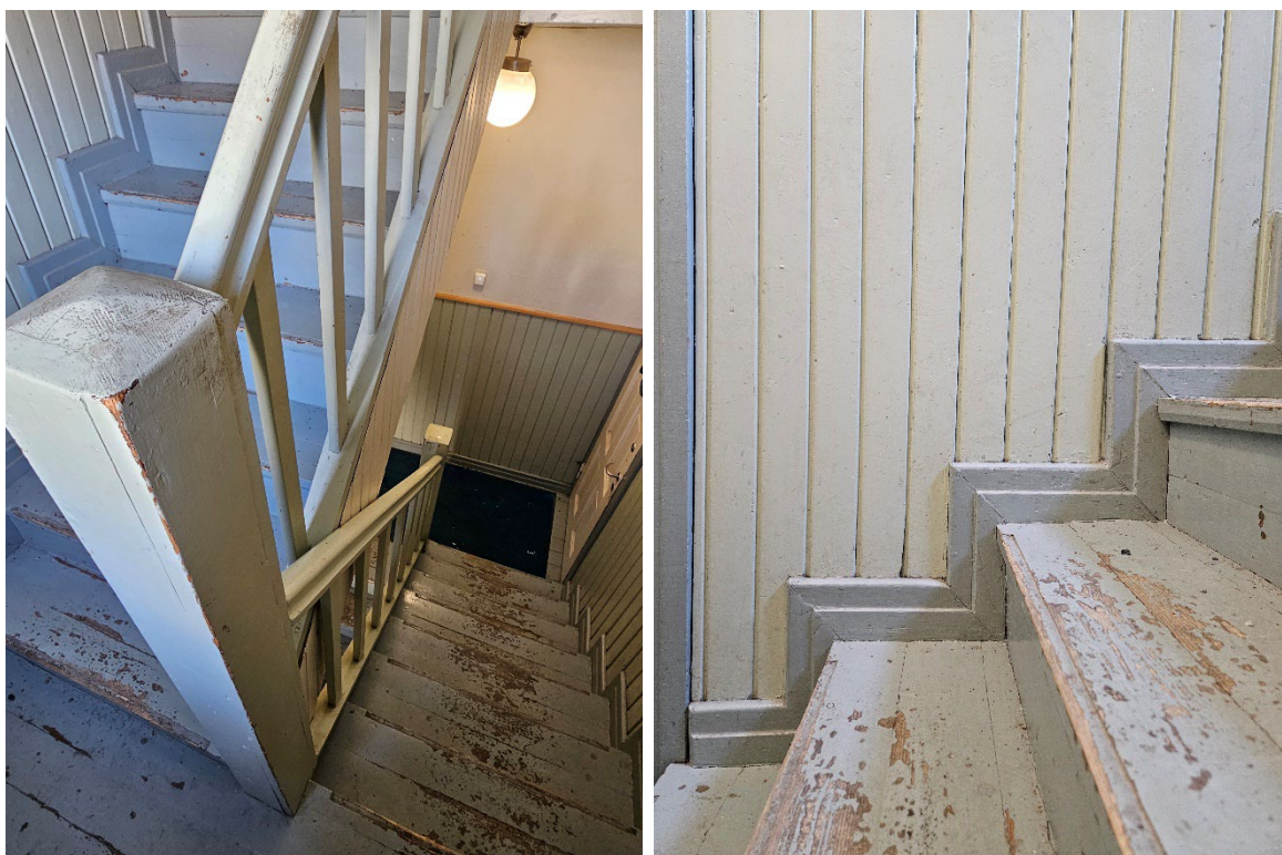
Kuva 48 A-rapun pihan puoleinen porrashuone.
