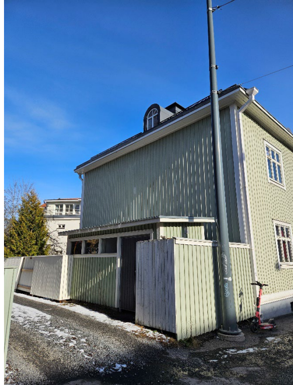
Kuva 41 Pääty Sepänskadulle (vas.) ja luoteeseen (oik.). Sepänskadun päädyllä on kellaritilaan tehty yksi ikkuna vuonna 2002, ja toinen ikkuna vuonna 2023. Ilmalämpöpumput on lisätty 2024. Luoteispäädyllä on tehty kuvassa näkyvä jätekatos vuonna 2015.
