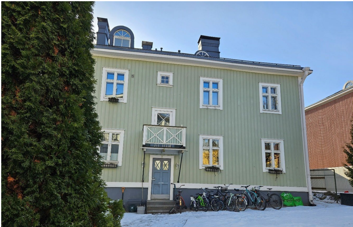
Kuva 44 Sisäpihan puoleiset sisäänkäynnit. Ulko-ovet on uusittu.
