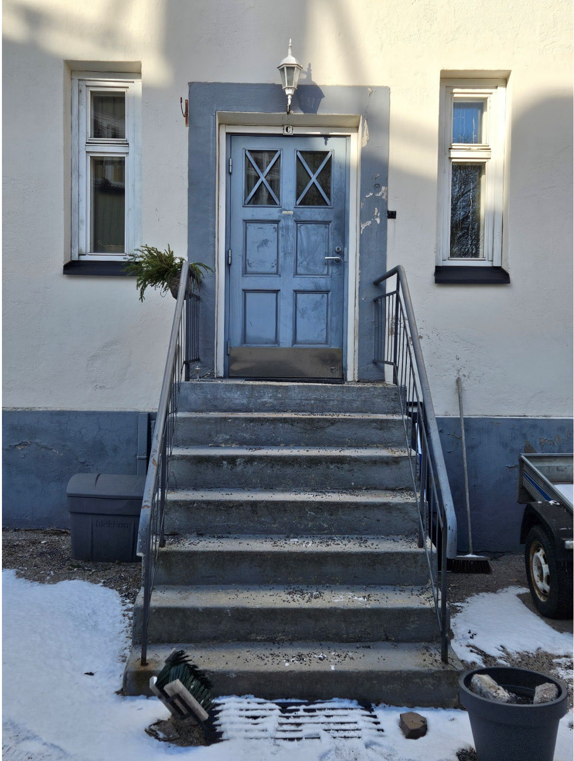
Kuva 64 Ikkunat ja ulko-ovi on uusittu.
