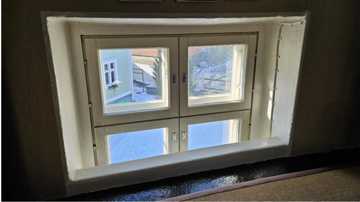
Kuva 66 Kerrosten välillä oleva ikkuna-aukko pihan puolelle.
