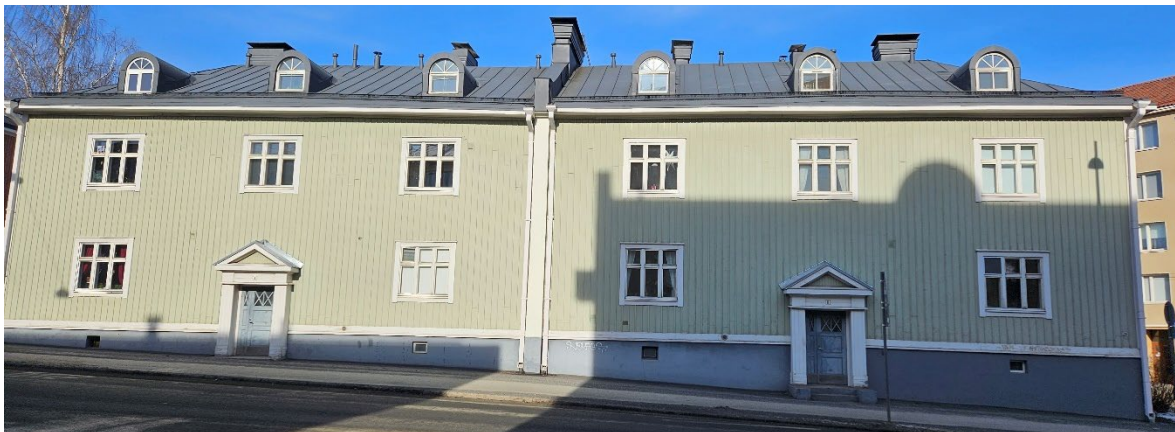
Kuva 43 Rakennuksen vesikatto on uusittu vuonna 2016. Kattolyhdyt ovat näkyvä muutostyö, joka on toteutettu 2000-luvun alussa.
