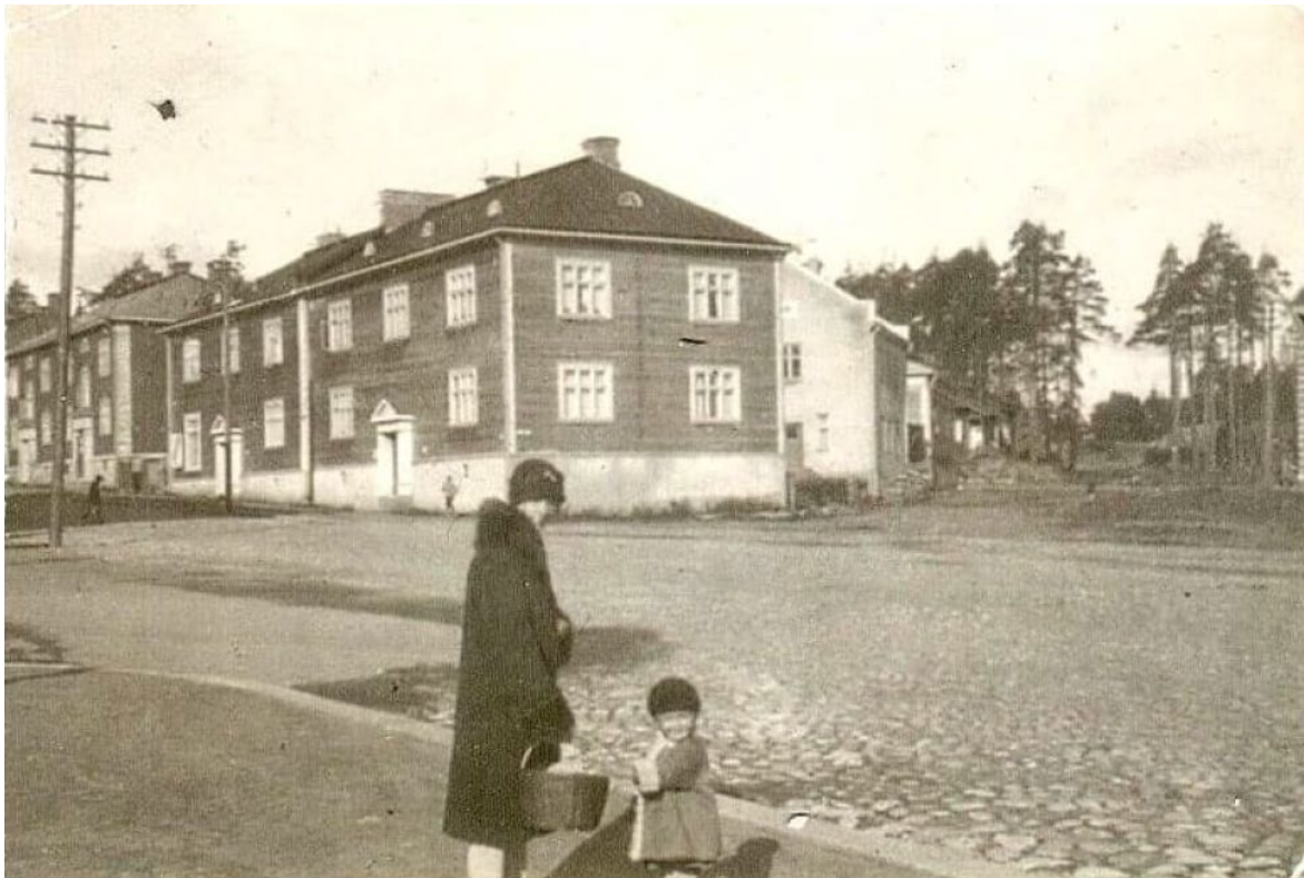
Kuva 16 Kuva vuodelta 1936. Kuvan perusteella rakennus saattoi tuolloin olla vielä laudoittamaton, eli hirsipinnalla. Kuvaaja tuntematon. Lähde: Rakennusinventointi 2024.
