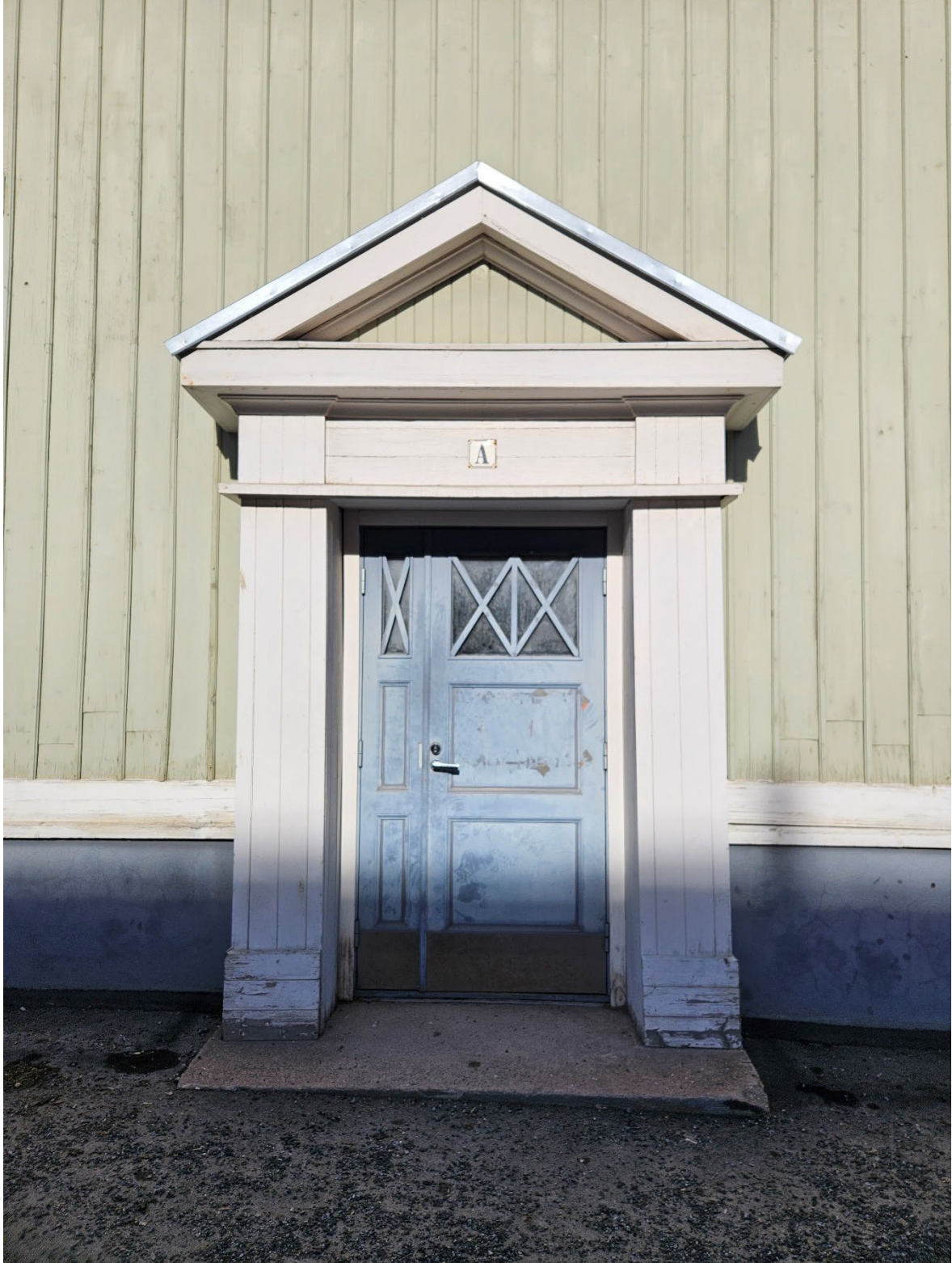
Kuva 45 A-rapun sisäänkäynti Pirkankadun puolella. Puurakenteiset detaljit ilmentävät 1920-luvun klassismia.
