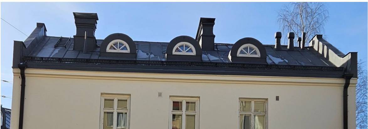
Kuva 61 Katujulkisivun puolella on vintillä alkuperäiset kaari-ikkunat. Piiput ovat kauttaaltaan pellitetyt.
