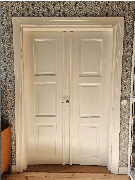
Kuva 55 Väliovissa on säilynyt alkuperäisiä painikkeita ja heloja. Asuntojen väliovia on säilynyt ja asukkaat ovat kunnostaneet niitä. Vasemmalla asunnon takaovi, oikealla asunnon pariovi.
