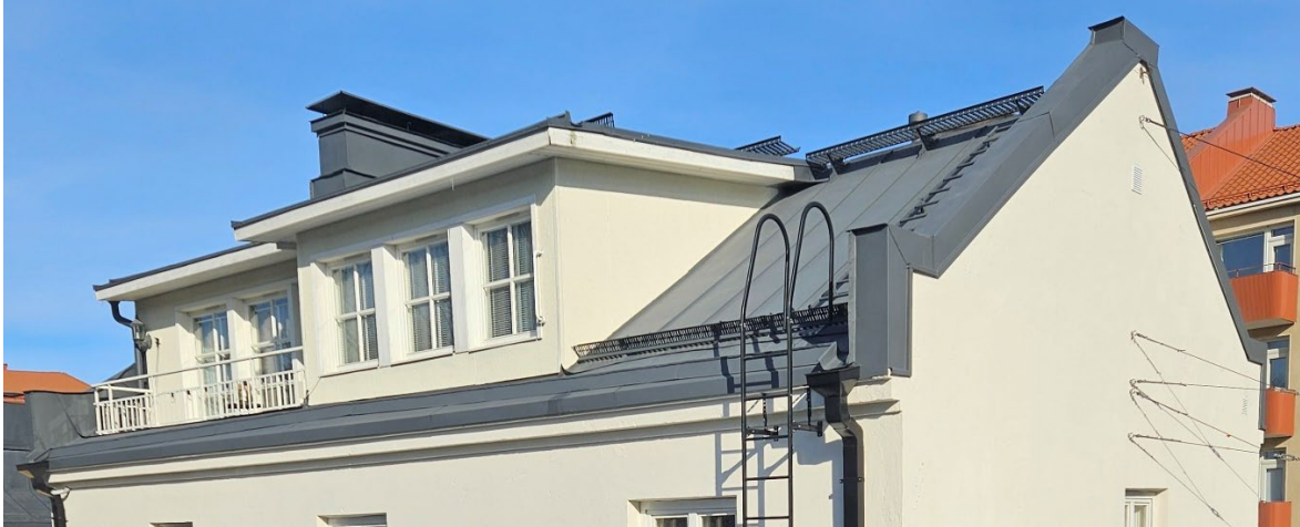
Kuva 60 Pihan eli lounaan puolella on uudisosat, joilla on myös omat vesikattorakenteensa.
