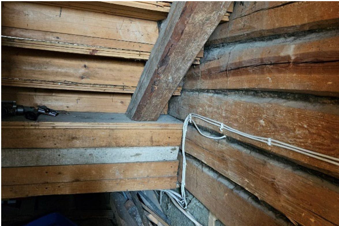
Kuva 38 Hirsiseinää Pirkankadun puoleisen porraskäytävän (B-rappu) portaiden alla olevassa kome-rossa.
