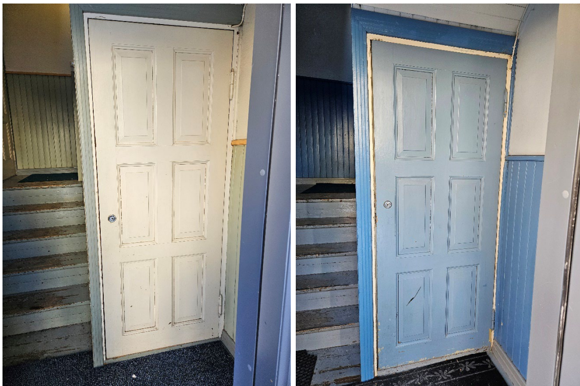
Kuva 47 Kellariin johtavat ovet A- ja B-rapun pihan puoleisissa porrashuoneissa.
