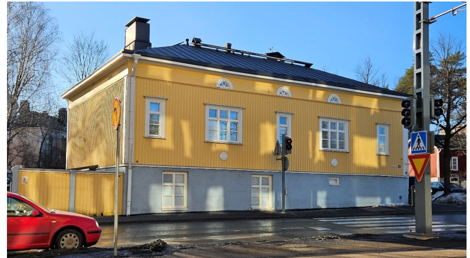
Kuva 34 Julkisivu itään (Sepänekadulle).
