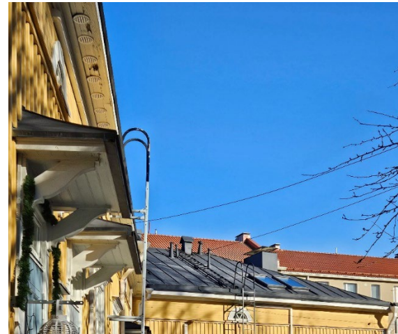
Kuva 41 Uusitulla katolla näkyy lisättyjä ilmanvaihtoputkia, kattoikkunoita sekä hoitosillat. Piiput ja hormit on suojattu peltihatuilla. Räystääslaudoituksen alaosaan on lisätty tiheään ilmanvaihtoritalöitä.
