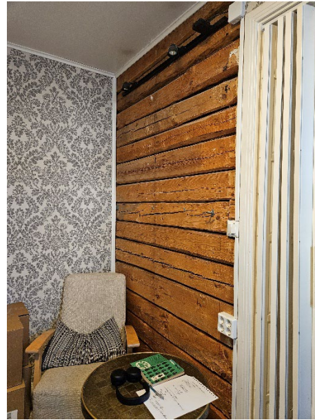
Kuva 54 Vasemmalla asunnon 3 ullakolle rakennetut sauna- ja suihkutilat. Oikealla saman asunnon 1. kerroksen hirsinen väliseinä.
