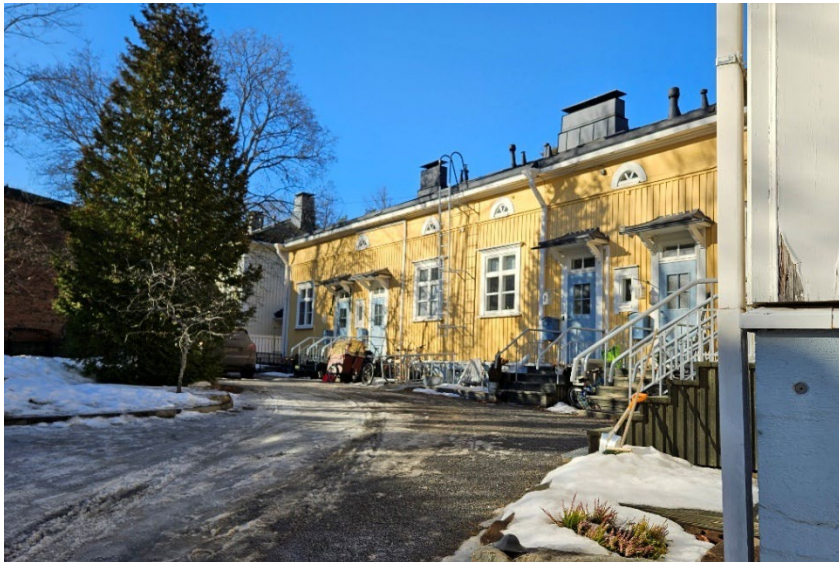
Kuva 36 Näkymä sisäpihalle eteläpäädyttä.
