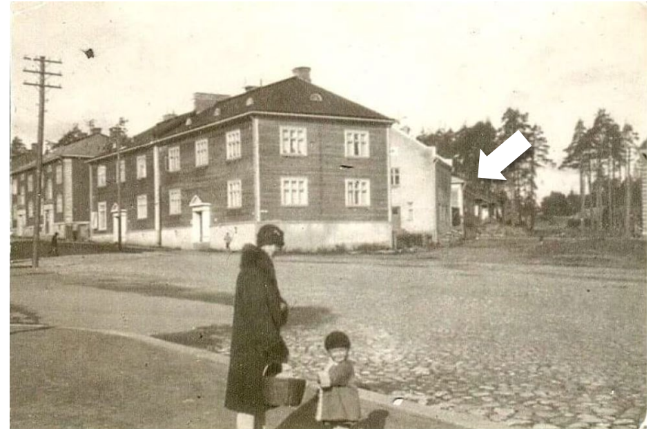
Kuva 10 Kuvassa vuodelta 1936 näkyy Kolmisopen talot, joista Sepäncatu 12 on Savilinnantien saunarakennuksesta seuraavana oikealla valkoisen nuolen osoittamassa kohdassa. Kuvaaja tuntematon. Lähde: As. Oy Pirkkapuisto rakennusinventointi 2024.
