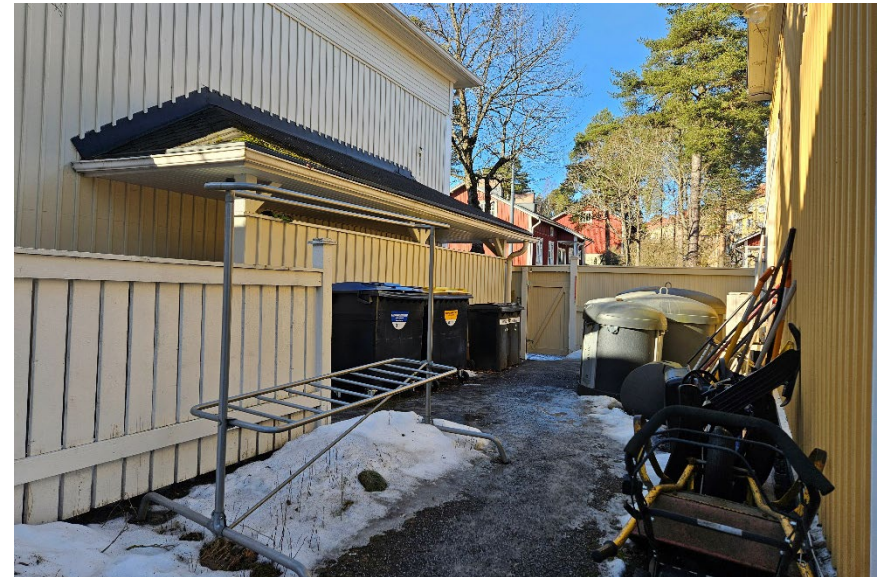
Kuva 31 Rakennusten välinen jätekatos Satakunnankadun puolella. Emilinkulma oikealla.
