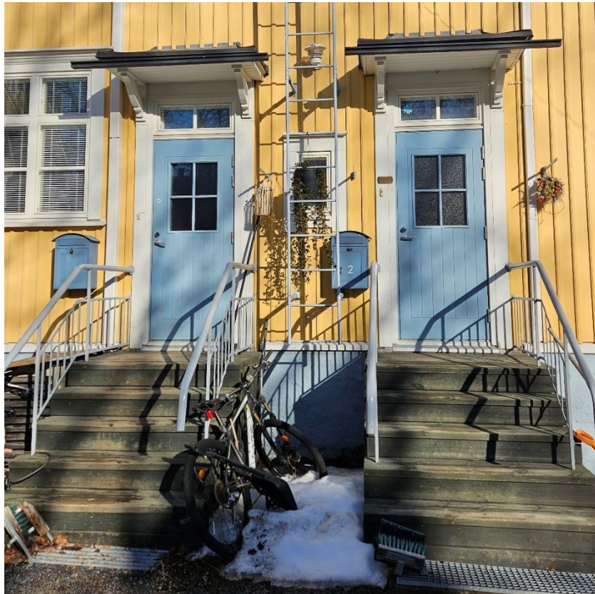
Kuva 42 Sisäänkäynnit asuntoihin 2 ja 3. Ulko-ovet ja yläikkunat on vaihdettu. Betoniset portaat on korvattu kestopuisilla. Kaiteet ja katokset on uusittu vanhaa mallia mukaillen.
