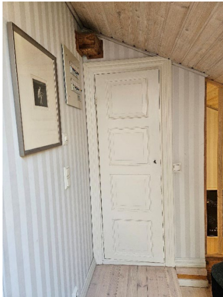
Kuva 51 Väliovia on säilynyt joka asunnossa. Niiden malli vaihtelee hieman, mutta pääsääntöisesti ne ovat peiliovia, joissa samankokoisia peilejä on neljä allekkain. Eteistilojen ovien yläosissa on lasit.
