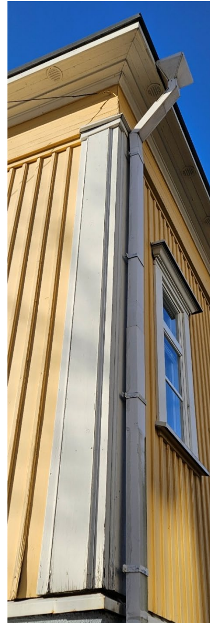
Kuva 38 (Vasemmalla) Antiikin arkkitehtuurista lainattu koristeaihe ovat nukissa olevat pilasterimaiset koteloinnit.
