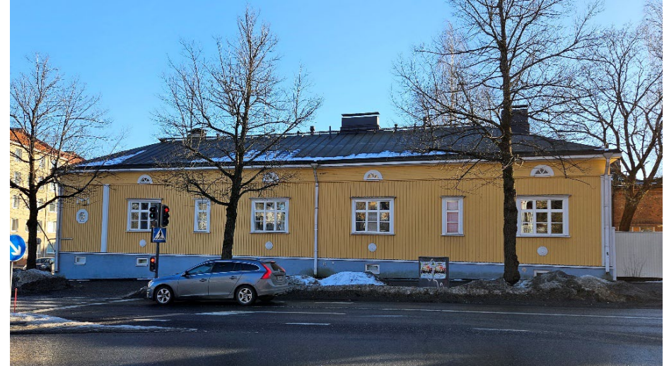
Kuva 33 Julkisivu pohjoiseen (Satakunnankadulle).
