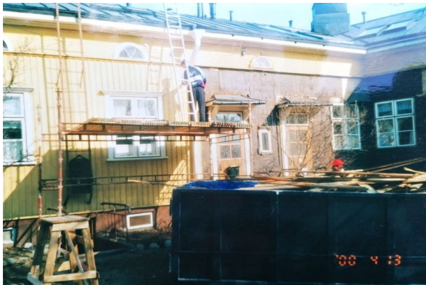
Kuva 24 Julkisivuremonttia ja salaojien kaivamista vuonna 2000. Ikkunat ovat tuolloin olleet vielä alkuperäiset, ja ulko-ovetkin mahdollisesti. Lähde: As. Oy Emilinkulma, Historiikkinen.
