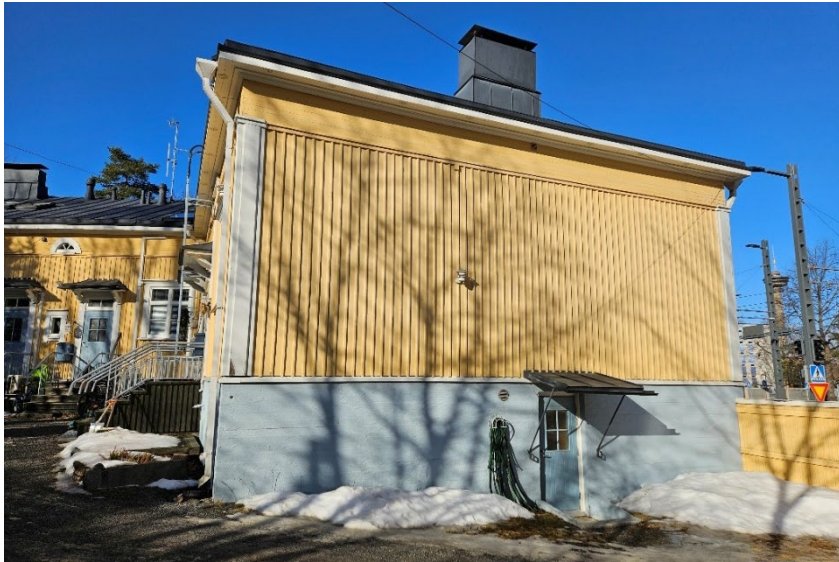
Kuva 35 Rakennuksen pääty etelän suuntaan, jolla sijaitsee sisäänkäynti entiseen talonmiehen asuntoon. Rakennuksen nurkissa on pilastereita imitoivat, klassisismia ilmentävät koristeistat.
