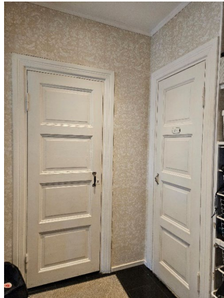
Kuva 51 Väliovia on säilynyt joka asunnossa. Niiden malli vaihtelee hieman, mutta pääsääntöisesti ne ovat peiliovia, joissa samankokoisia peilejä on neljä allekkain. Eteistilojen ovien yläosissa on lasit.
