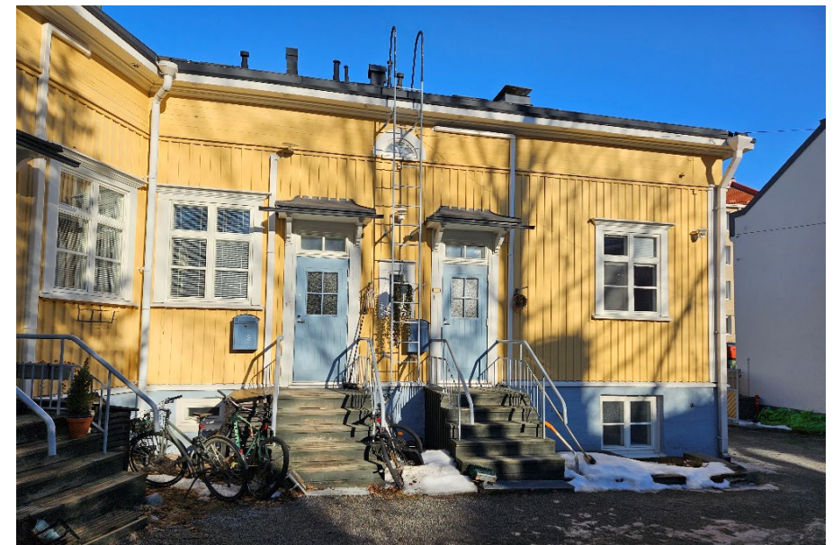
Kuva 37 Näkymä sisäpihan julkisivuista (Sepänkadun suuntaan).
