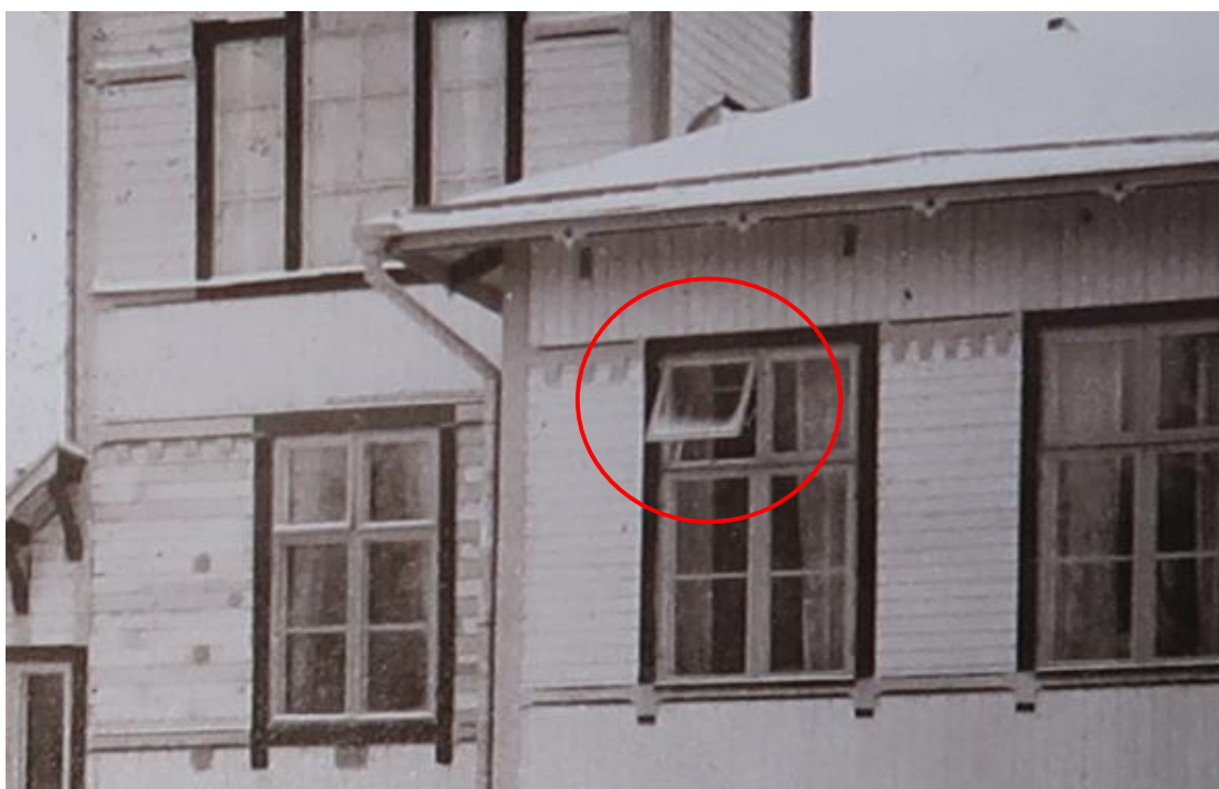
Kuva 40. Yläikkunat ovat olleet nk. terveysikkunoita, joissa ulompi lasi on saranoitu yläreunastaan ja alempi alareunastaan, jolloin ilma virtaa huoneeseen ikään kuin katon kautta. Kuva Tampereen Kaupunginarkisto (ote kuvasta).
