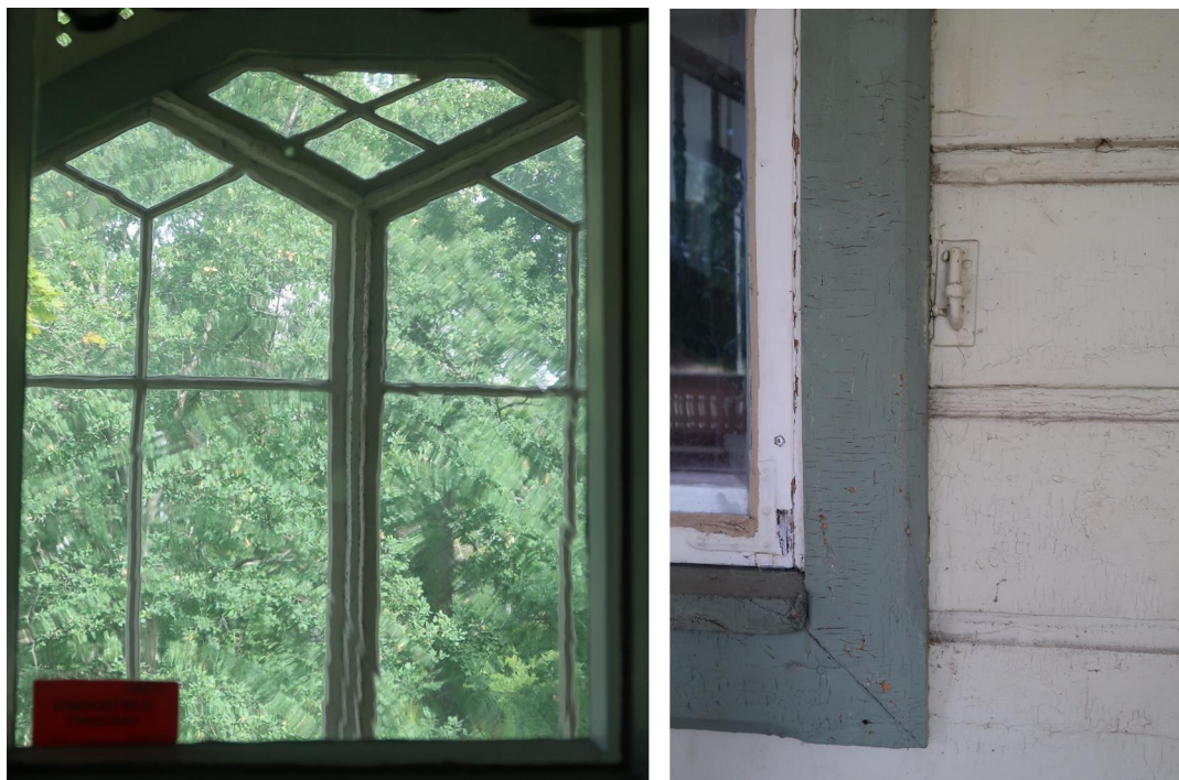
Kuva 50. Vasemmalla maisema salin ovesta olevan, puhalletun lasin (ja terassin nykyaikaisen lasin) läpi katsottuna. Oikealla ikkunaluukkua varten oleva tappi terassin ikkunassa.
