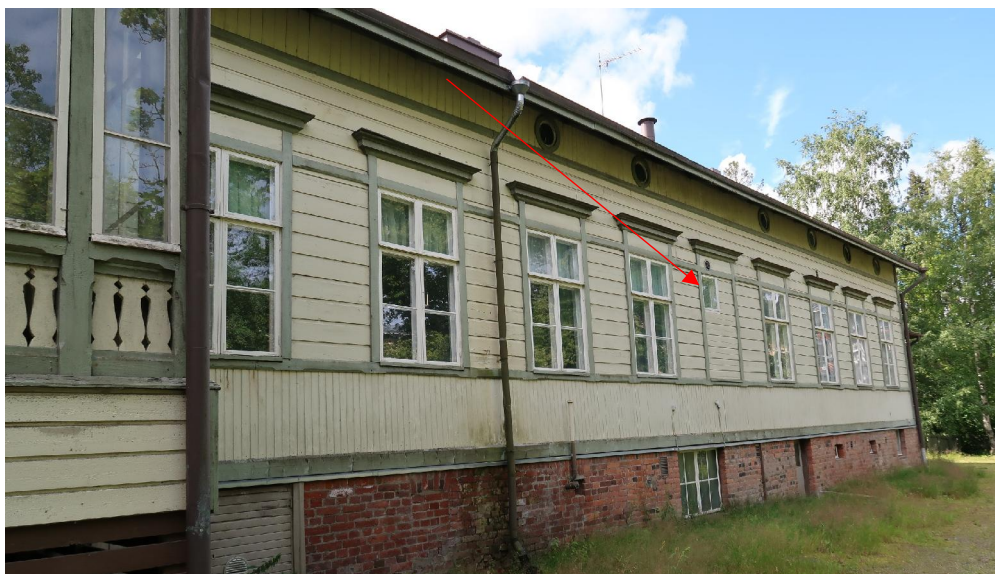
Kuva 11. Julkisivussa ikkunat ovat tasavälein, mutta yhdessä ikkunapaikassa on vain yksi ruutu. Tuossa kohdassa oli huvila-aikaan komero, joten ratkaisu on todennäköisesti alkuperäinen.
