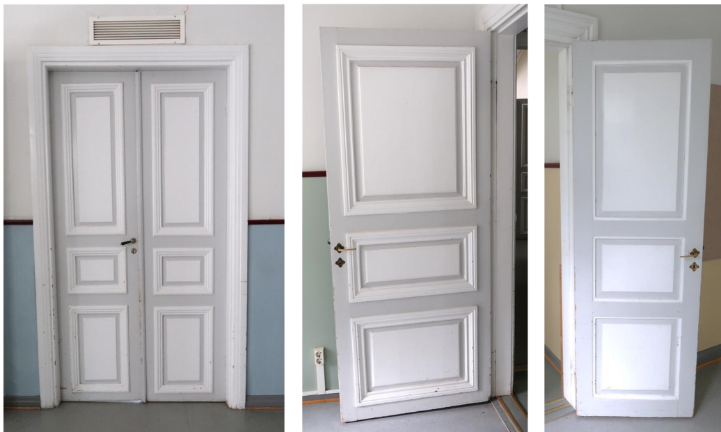
Kuva 54. Ensimmäinen ovi on huvilan alkuperäinen pariovi, joka voi olla kierrätetty. Toinen on vuoden 1926 korjauksessa todennäköisesti jostain puretusta väliseinästä johtajattaren huoneen oveksi kierrätetty ovi (tyyliltään 1800-luvun alkua, joten todennäköisesti ollut vanha jo huvilaan asennettaessa) ja viimeinen on todennäköisesti 1926 tehty peiliovi.
