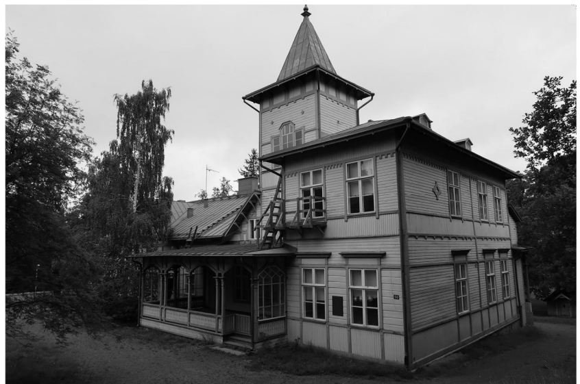
Kuva 51. Rakennuksen julkisivuväritys vuonna 1927 ja nykyisin mustavalkokuvissa, joista voidaan verrata julkisivun värien valööriä eli tummuutta. Erityisesti ikkunoiden vuorilaudat olivat 1920-luvulla tummemmat kuin nykyisin. Kuva vuodelta 1927 Vapriikin kuva-arkisto.
