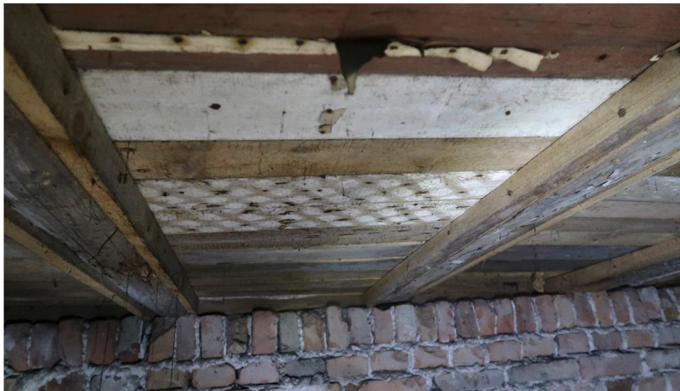
Kuva 19. Rossipohjan laudoituksessa ryömintätilaan päin jälkiä tikkurappauksesta sekä pinkopahvin reunaa.
