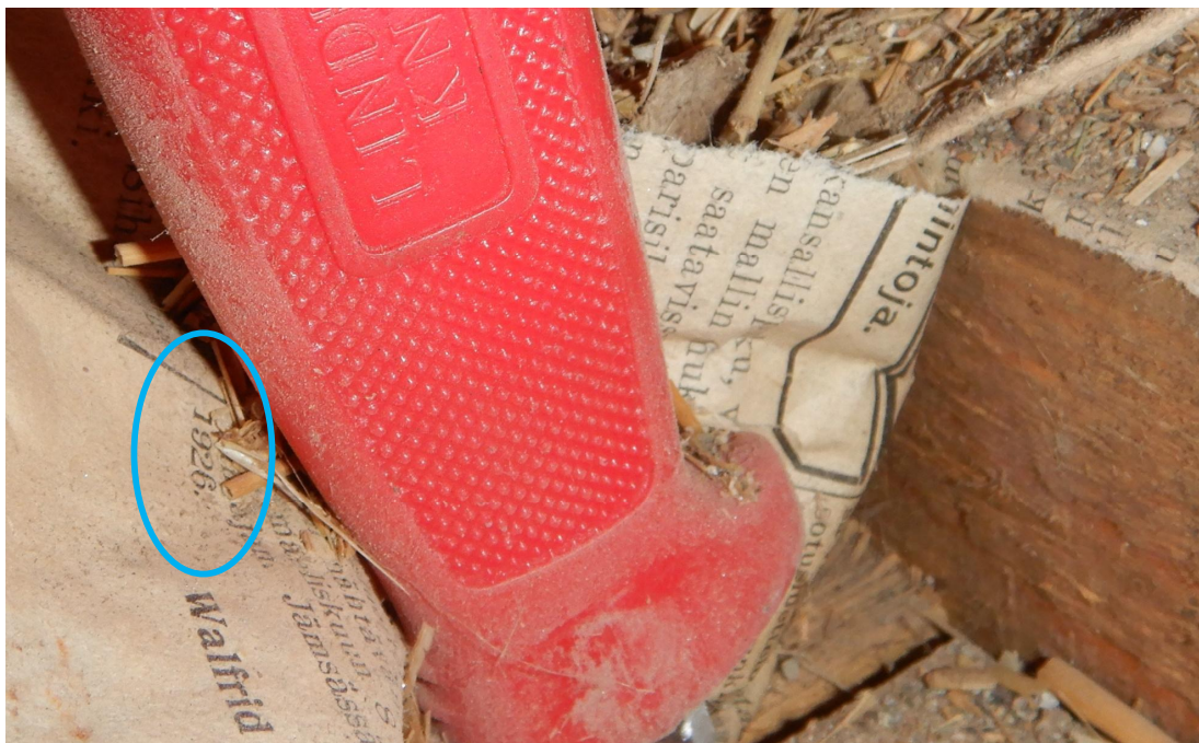
Kuva 37. Toisen kerroksen välipohjan sanomalehti, jossa artikkelin päiväyksessä on vuosiluku 1926.
