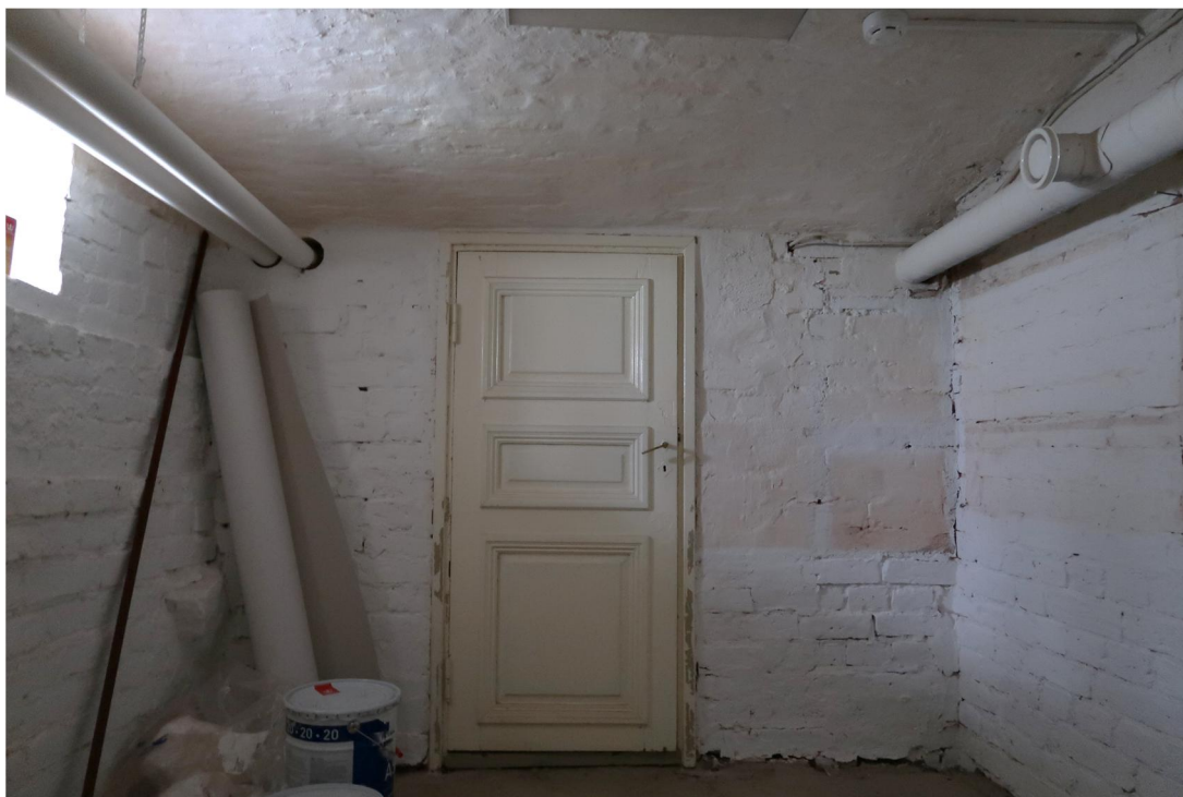
Kuva 16. Yksi kolmesta jäljellä olevasta holvatusta kellarista. Sen lattiapintana on valuasfaltti, joka saattaa olla kellareiden alkuperäinen lattiamateriaali.
