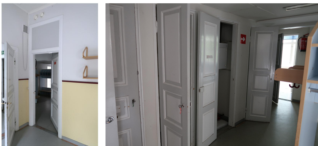
Kuva 53. Toisen kerroksen huoneiden ovien yllä on ehkä ollut ikkunat tai jokin kuva-aihe, mutta nyt aulassa oven toisella puolella on alaslaskettu katto. Aulan komerot ovineen ovat vuoden 1926 muutoksista.
