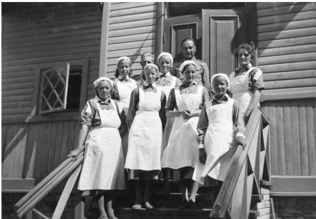
Kuva 30. Lottia Lepolan länsipäädyin kuistilla 1941. Kuisti purettiin laajennuksen alta vuonna 1957. Kuva Vapriikin kuva-arkisto.
