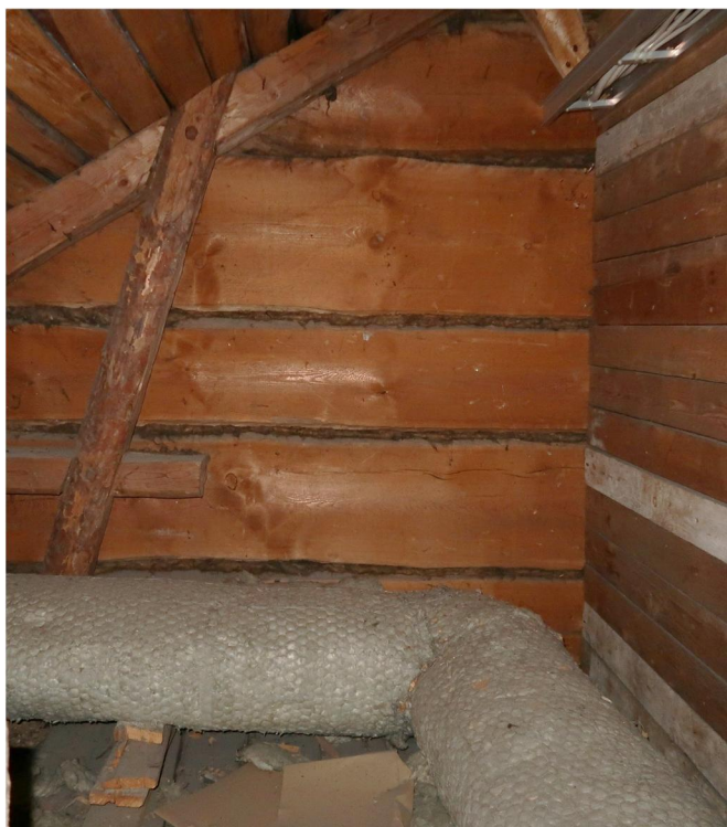
Kuva 15. Ullakolla ovat toisen kerroksen tilojen seinähirret kylmää ullakkoa vasten näkyvissä ja hirret ovat hyvin leveitä. Ullakon yhdessä komerossa on nähtävillä porrashuoneen hirsiseinän nurkka, jossa näkyy nurkkasalvoksen tyyppi, joka on lukkonurkka. Nurkkaan liittyvä lautaseinä on vuodelta 1926.
