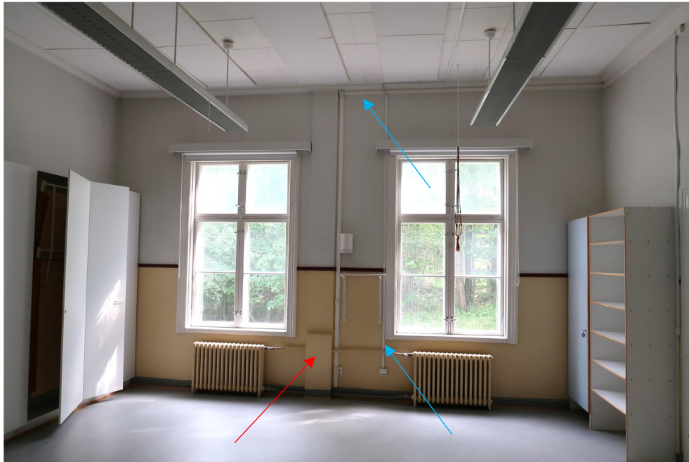
Kuva 44. Vanhat lämpöpatterit ovat edelleen käytössä, mutta lämpöjohdot on nyt sijoitettu koteloon (punainen nuoli). Sähköt on asennettu seinäpintaan, mutta piilotettu muovilistojen taakse (sininen nuoli). Valaisimet ovat laatikkomaisia, katosta ripustettuja loisteputkia.
