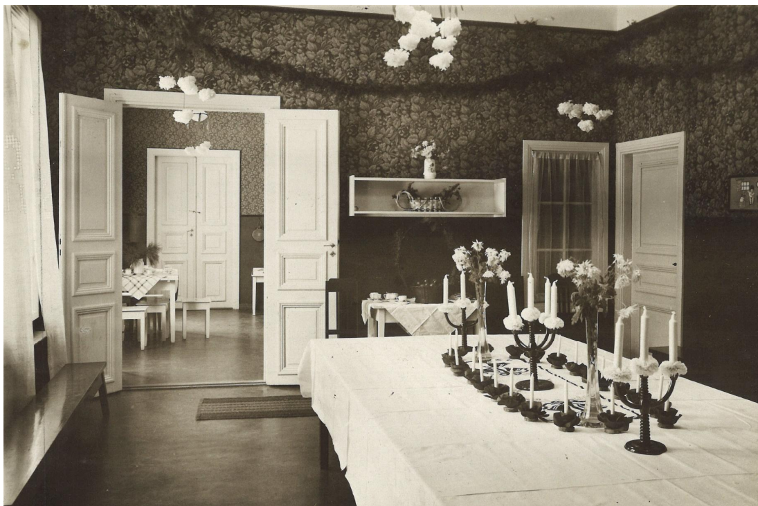
Kuva 22. Kuva Lepolan lastenkodin ruokasalista vuodelta 1928. Huoneen oikeassa takanurkassa on ikkuna kellariin vievään portaikkoon, joka rakennettiin lastenkodiksi muuttamisen yhteydessä. Lattian pinta on todennäköisesti magnesiamassaa, seinien alaosat on suojattu maalatulla vanerilla ja yläosissa on tapetit. Kuva Tampereen Kaupunginarkisto.
