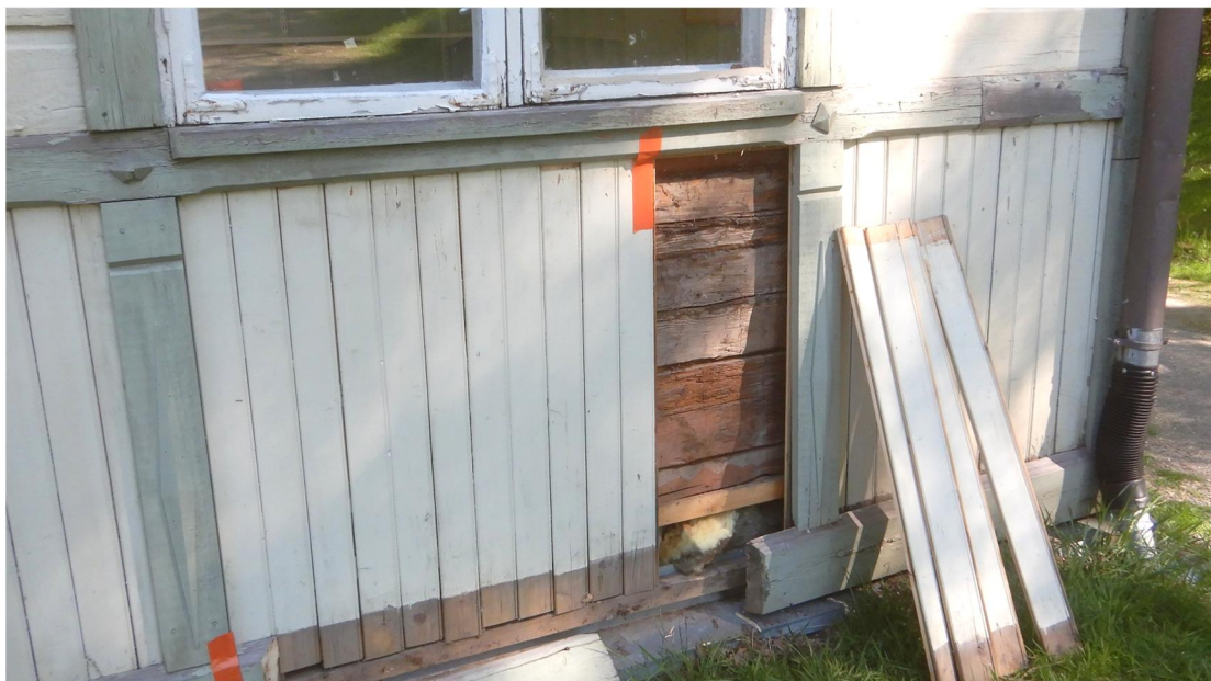
Kuva 21. Ulkoseinien hirsipinnassa on punamultaa ja hirret ovat olleet säälle alttiina. (Kuva Unto Kovanen)
