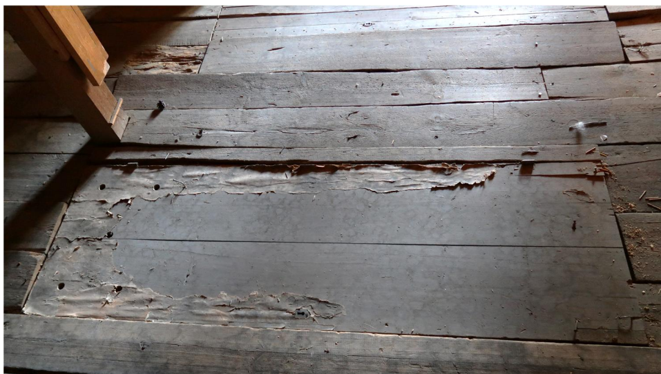
Kuva 19. Rossipohjan laudoituksessa ryömintätilaan päin jälkiä tikkurappauksesta sekä pinkopahvin reunaa.
