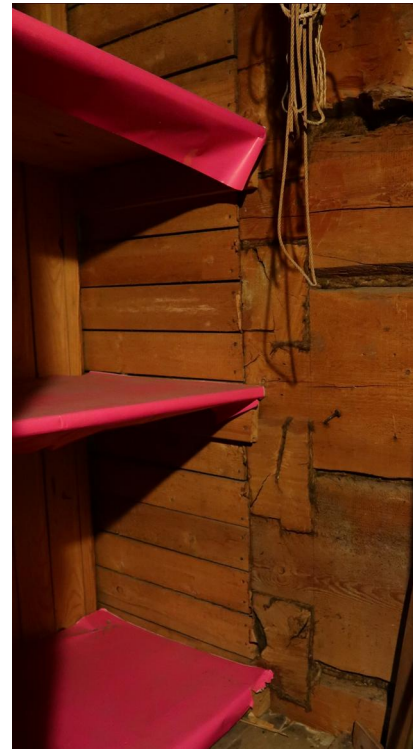
Kuva 15. Ullakolla ovat toisen kerroksen tilojen seinähirret kylmää ullakkoa vasten näkyvissä ja hirret ovat hyvin leveitä. Ullakon yhdessä komerossa on nähtävillä porrashuoneen hirsiseinän nurkka, jossa näkyy nurkkasalvoksen tyyppi, joka on lukkonurkka. Nurkkaan liittyvä lautaseinä on vuodelta 1926.
