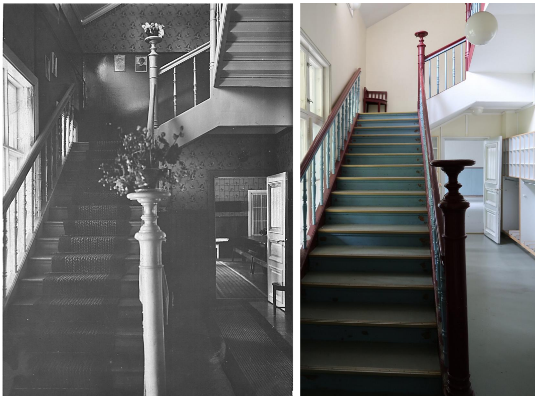
Kuva 52. Eteinen vuonna 1927 ja nykyisin. Portaikon kaiteen väritys on muuttunut ja ovea entiseen ruokahuoneeseen on siirretty hieman kauemmas nurkasta vuoden 1957 korjaus- ja muutostöiden yhteydessä, jotta on saatu tilaa kaapeille eteiseen. Kuva 1927 Tampereen Kaupunginarkisto.
