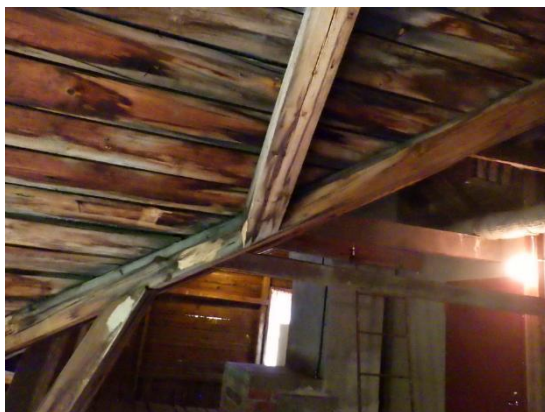
Kuvat 95 a ja b. Vesikaton aluslaudoituksessa on vanhoja vuotojälkiä rakennuksen lounaispäädyn jiirin kohdalla (kuva a). Vuotokohta on paikattu bitumoimalla vesikatteen jiirikohta yläpuolelta. Vuotojälkiä havaittiin myös yläpohjan lattiapinnan laudoituksessa (kuva b).
