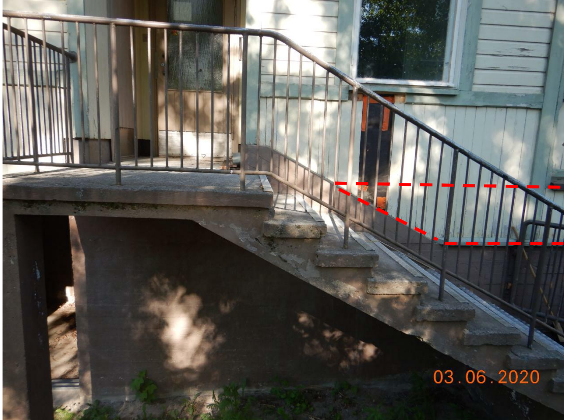
Kuva 60. Rakenneavaus RAUS4 tehtiin rakennuksen länsiseinustalle tilan 104 ulkoseinään. Katoksen 130 osalla esiintyvä korkkilevyeristys jatkuu havaintojen perusteella paneloinnin alaosassa (punainen katkoviiva).
