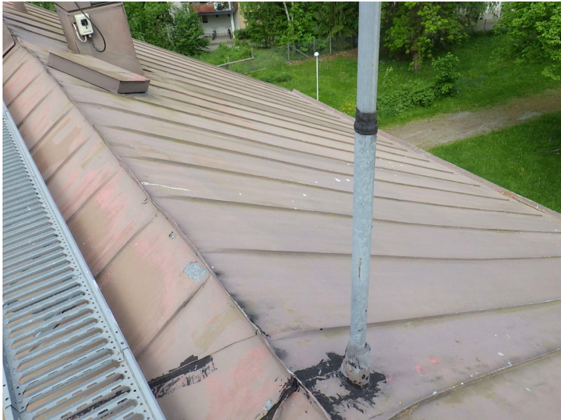
Kuva 89. Jiirin saumakohtia ja läpivientikohtia on tiivistetty bitumilla.
