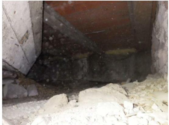
Kuvat 22 a ja b. Ryömintätilassa on putkia, jotka on sijoitettu puurakenteisiin koteloihin. Sisäänkäyntikatoksen läheisyydessä ryömintätilassa on sortuneita putkikotelointeja. Kaakkoiskulmalla sijaitsevan terassin ryömintätilaan ei ollut pääsyä.
