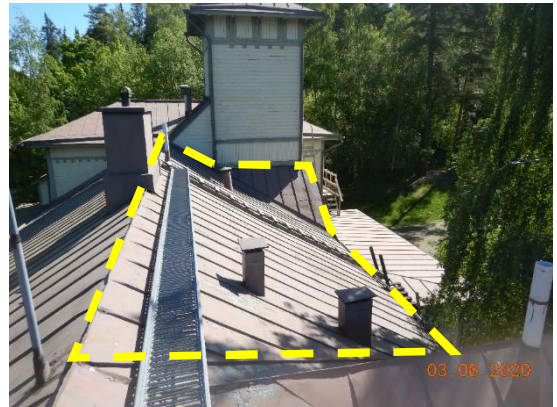
Kuvat 81 a ja b. Yleiskuvia vesikatolta. Vuotanutta katon jiirikohtaa on korjattu bitumoi-malla (punainen merkintä). Eteläisellä puoliskolla keltaisella rajatulla alueella vesikate on palapeltiä. Muilla katon osilla vesikatteena on täysipitkää rivipeltikate. Kattoluukulta kulkusillalle ei ole turvallista reittiä (sininen merkintä).
