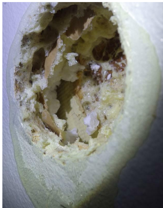
Kuva 71. a. RAUS8 kaappien yläpuolella ja vanha rakenneavaus RAUS8b ikkunan vieressä tilassa. b. Rakenneavauksessa RAUS8b havaittiin hirren pinnassa sama Ensopahvi kuin RAUS8:ssä. Sen päällä oli ohut polystyreenilevy ("styrox"), jonka päällä oli rakennuspapereita ja lastulevy. Reikä oli laitettu umpeen liimaamalla irrotettu lastulevykappale PU-vaahdolla takaisin.
