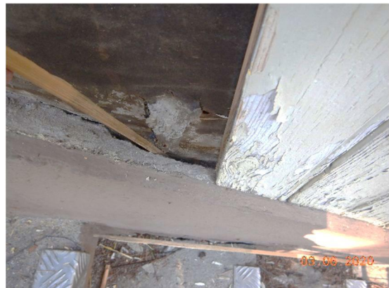
Kuva 61. Panelointi on päätetty portaiden kohdalla betonisokkelia vasten. Vedenohjauksessa on puutteita. Sadevedet ohjautuvat osittain paneloinnin alaosaan ja seinärakenteen sisään. Paneloinnin alaosat ovat halkeilleet.
