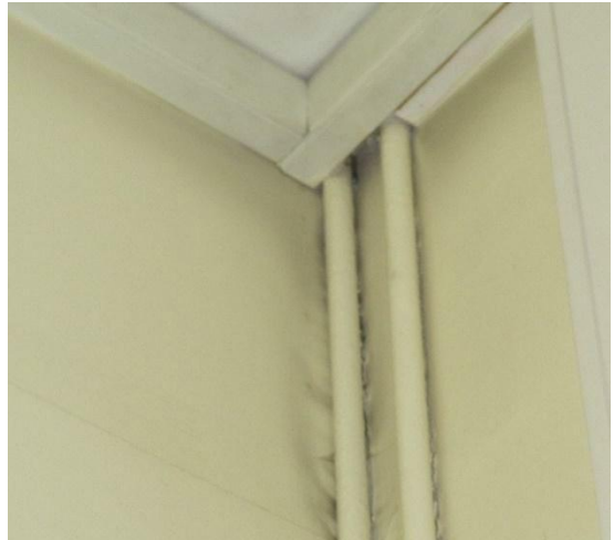
Kuvat 48 a...b Betonirakenteisessa (a) ja puurakenteisessa välipohjassa (b) havaittiin ilmavuotojälkiä ja epätiivait läpiviivitejä.
