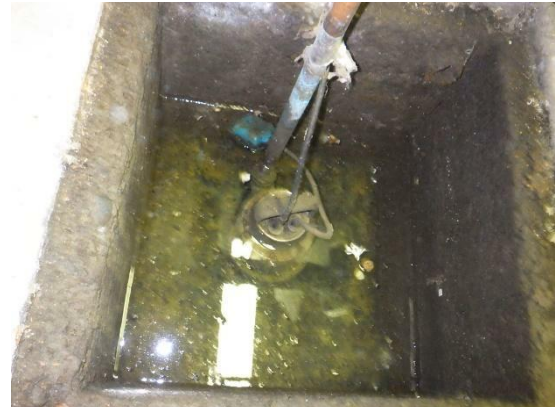
Kuva 18. Lämmönjakohuoneen lattiapinnoilla ja seinien alaosissa havaittiin kosteusjälkiä ja kosteusvaurioita. Tilassa on pumpullinen toiminnassa oleva perusvesikaivo, jonka pohjalla oli tarkastelun aikana n. 15 cm vettä. Kokeen perusteella pumppu oli toimintakuntoinen. Lämmönjakohuoneessa on maaperästä, perusvesikaivosta ja ryömintätilasta peräisin olevia sisäilman epäpuhtauslähteitä.
