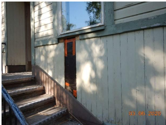
Kuva 61. Panelointi on päätetty portaiden kohdalla betonisokkelia vasten. Vedenohjauksessa on puutteita. Sadevedet ohjautuvat osittain paneloinnin alaosaan ja seinärakenteen sisään. Paneloinnin alaosat ovat halkeilleet.
