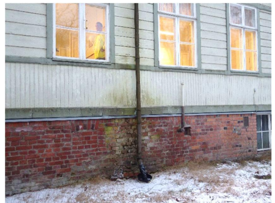
Kuva 7. a. Betoni- ja tiilisokkelin liittymä rakennuksen pohjoispuolelta. Betonisokkelirakenteissa ei havaittu kosteuden aiheuttamia jälkiä tai muita viitteitä vaurioista. Betonisokkelin osalla ei ole pellityksiä paneloinnin alaosassa. Alaosassa on viistetty tippalauta. b. Tiilisokkelissa havaittiin syöksytörven vuodosta kosteusvaurioitunut kohta pohjoisseinustalla.
