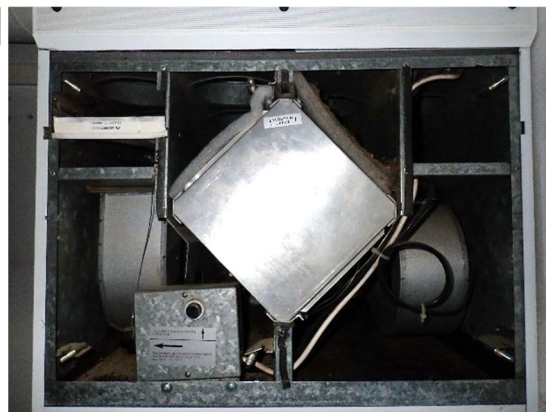
Kuva 98 a ja b. Yleiskuvia MUH-Ilmava malli: B 3461 ilmanvaihtokoneesta. IV-koneet ovat 4-portaisia muuntajateho-ohjattuja. Säästöyksiköt sijaitsevat iv-koneiden läheisyydessä.
