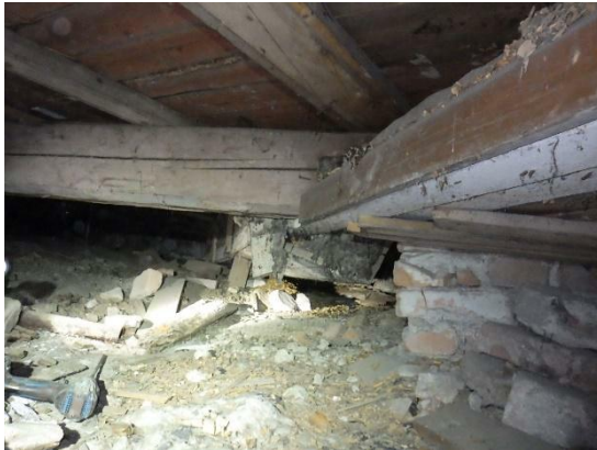
Kuvat 22 a ja b. Ryömintätilassa on putkia, jotka on sijoitettu puurakenteisiin koteloihin. Sisäänkäyntikatoksen läheisyydessä ryömintätilassa on sortuneita putkikotelointeja. Kaakkoiskulmalla sijaitsevan terassin ryömintätilaan ei ollut pääsyä.
