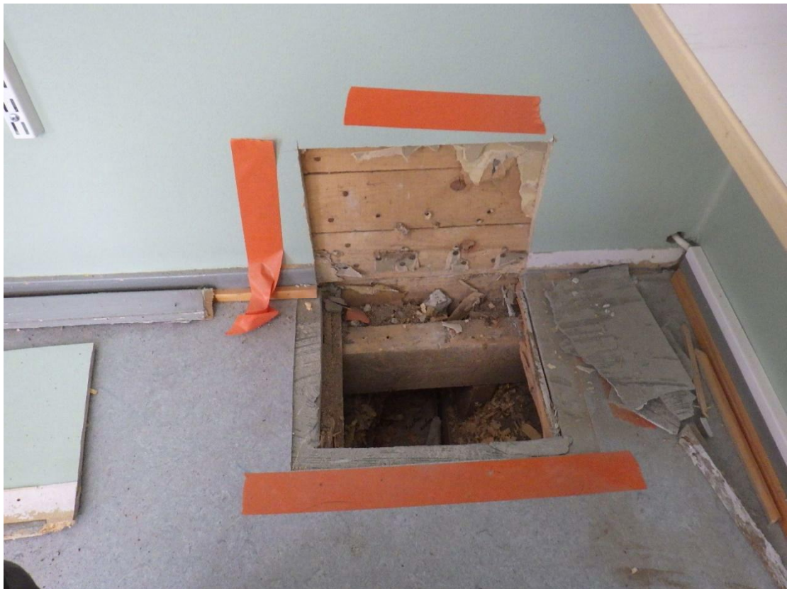
Kuva 34. Rakenneavaus RAAP3 tehtiin tilaan 125 väliseinän ja alapohjan liittymään. Rakenteissa ei havaittu silmämääräisesti viitteitä vaurioista eikä epätavanomaista hajua todettu. Rakenneavauksen pohjalta otetussa eristetäytön materiaalinäytteessä ei havaittu mikrobikasvua materiaalissa (MAT2).
