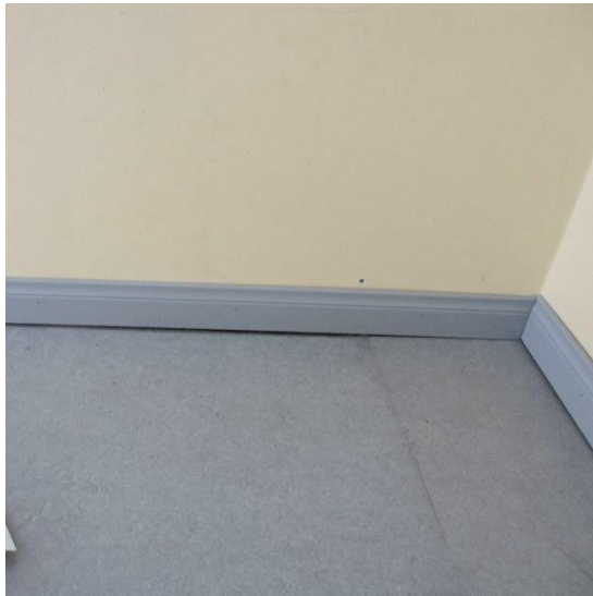
Kuvat 47 a...b 2. Kerroksen hirsirakenteisissa välipohjissa havaittiin paikallista painumaa.
