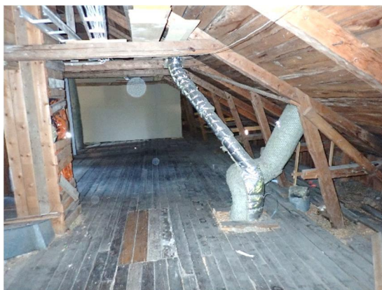
Kuva 104 a...d. Yleiskuvia ullakolla sijaitsevista ilmanvaihtokanavista. Ullakolla havaittiin avonaisia putkenpäitä ja epätiivittä liitoksia. Kanavien eristykset ovat myös osin puutteellisia.
