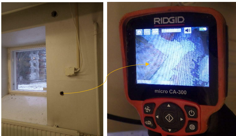
Kuvat 66 a. Rakenneavaus RAUS5b tehtiin RAUS5:n alapuolelle ja ulkoseinän todettiin olevan massiivitiiltä, jossa oli kapea ilmarako noin yhden tiilen syvyydellä. b. Ilmarakossa havaittiin endoskoopilla bitumisivelyä.
