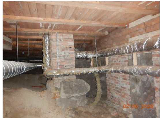
Kuvat 24 a ja b. Ryömintätilassa on paikoin poistettu maata. Maata on poistettu myös luonnonkiviperusteisten perusteisten pilarien vierustoilta (kuva b). Tilassa havaittiin huteran oloisia palkkien tuentoja (kuva a).
