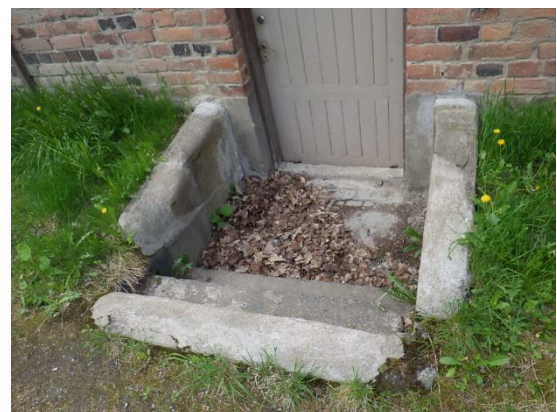
Kuvat 8 a ja b. Kellarikerroksen sisäänkäynnit sijaitsevat maanpinnan tason alapuolella. Sisäänkäynnin betonirakenteet ohjaavat sadevedet rakennusta kohti. Pintakosteuden osoittimen lukemat olivat lattialla koholla tuulikaapissa ja aulassa 008 ja 002.
