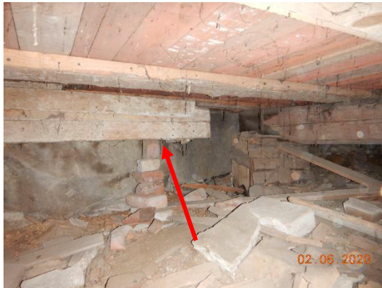
Kuvat 24 a ja b. Ryömintätilassa on paikoin poistettu maata. Maata on poistettu myös luonnonkiviperusteisten perusteisten pilarien vierustoilta (kuva b). Tilassa havaittiin huteran oloisia palkkien tuentoja (kuva a).
