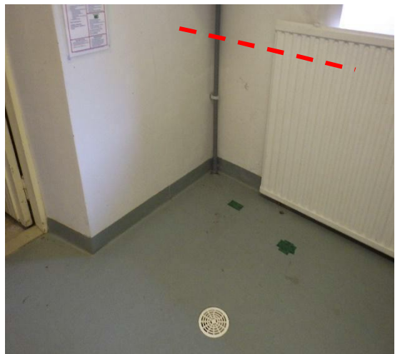
Kuvat 12 a ja b. Kellarin muovimattopäällysteisissä tiloissa havaittiin vaurioita muovimaton liimakerroksessa ja ylösnostot ovat paikoin irti alustastaan. Tilojen 004 ja 003 lattiapäällysteet vaikuttavat muita tiloja uudemmilta. Maanpinnan taso tilan ulkopuolella on kuvattu punaisella katkoviivalla.
