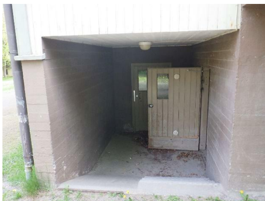
Kuvat 8 a ja b. Kellarikerroksen sisäänkäynnit sijaitsevat maanpinnan tason alapuolella. Sisäänkäynnin betonirakenteet ohjaavat sadevedet rakennusta kohti. Pintakosteuden osoittimen lukemat olivat lattialla koholla tuulikaapissa ja aulassa 008 ja 002.
