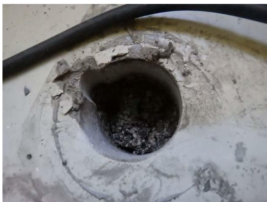
Kuvat 29 a...c. Rakenneavaus RAAP4 tehtiin tilaan 102. Avauksen perusteella rakenne on kevytsorabetonieristeinen kaksoislaatta.
