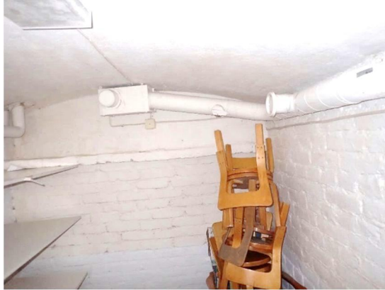
Kuva 105. Kellaritiloissa on poistoilmakanavisto. Erillisiä korvausilmaventtiileitä tai -aukkoja ei havaittu.
