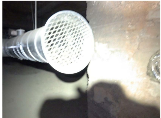
Kuva 106 a ja b. Kellarin ryömintätilassa on imukartioilla varustettu poistoilmakanavisto.
