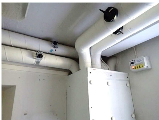
Kuva 103. MUH-Ilmava merkkisten ilmanvaihtokoneiden ilmanvaihtokanavat ovat kokoa 125 mm ja 100 mm. Kanavistossa ei havaittu olevan äänenvaimentimia.
