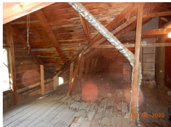
Kuvat 95 a ja b. Vesikaton aluslaudoituksessa on vanhoja vuotojälkiä rakennuksen lounaispäädyn jiirin kohdalla (kuva a). Vuotokohta on paikattu bitumoimalla vesikatteen jiirikohta yläpuolelta. Vuotojälkiä havaittiin myös yläpohjan lattiapinnan laudoituksessa (kuva b).
