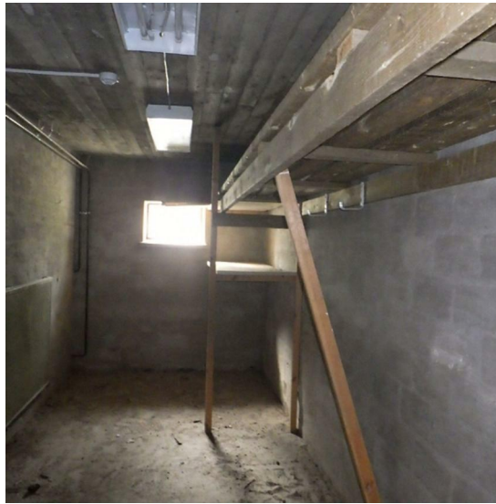
Kuvat 10 a ja b. Betonirakenteisen sokkelin osalla on sisäpuolinen sementtilastulevyeristys ja verhomuuraus ja sokkelibetonin pinnassa on bitumisively. Rakenne tarkastettiin varaston ulkoseinään tehdystä rakenneavauksesta RAMVS1 (kuva b).
