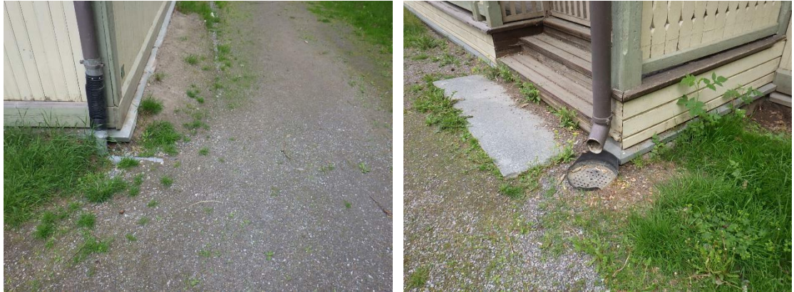
Kuva 2. Rakennuksen kaakkoisnurkalla maanpinta on alimpien hirsien tasossa. Osa syöksytorvista on viemäroity kiinni sadevesijärjestelmään. Osassa syöksytorvista on muoviset loiskekupit (kuva b).
