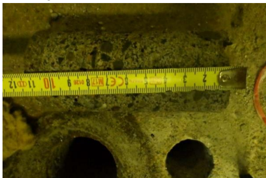
Kuva 27. Rakenneavaus (50 mm) RAAP5 tehtiin lämmönjakohuoneen lattiaan. Rakenneavauksesta ei havaittu eristettä alapohjassa tai vedeneristekerrosta valussa. Alapuolinen maa-aines on hienoa soraa.
