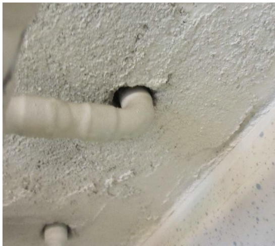
Kuvat 48 a...b Betonirakenteisessa (a) ja puurakenteisessa välipohjassa (b) havaittiin ilmavuotojälkiä ja epätiivait läpiviivitejä.
