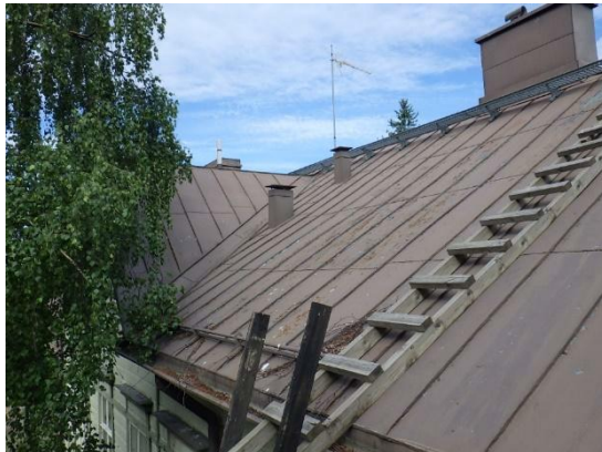
Kuvat 80 a ja b. Yleiskuvia vesikatolta. Maalipinta irtailee laaja-alaisesti etenkin vesikatkon harjan eteläpuolella.
