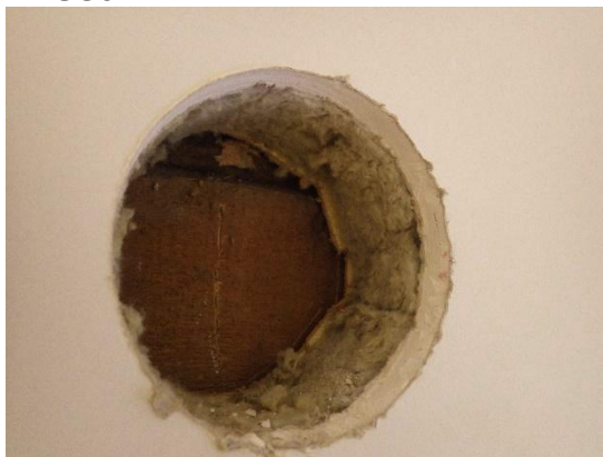
Kuva 70. a. RAUS8 tehtiin vuoden 1990 suunnitelmissa lisälämmöneristettynä esitettyyn ulkoseinään tilassa 128. Seinän sisäpinnassa oli lisälämmöneristeenä 50 mm mineraalivillaa. b. Hirren ja mineraalivillan välissä oli vanha maalattu Enso-pahvi.
