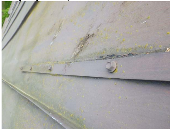
Kuvat 87 a ja b. Puiet kattotikkaat ovat huterat ja ikääntyneet. Tikkaiden alempi osa on pehmenyt ja ruuviliitos tikkaiden ylemmän osaan on löystynyt. Tikkaat on kiinnitetty ruuveilla katon harjan toiselta puolelta peltikatteen läpi.
