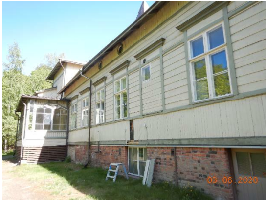
Kuvat 6 a ja b. Yleiskuvat rakennuksen pohjoiselta (kuva a) ja eteläiseltä (kuva b) puolelta. Maanvastainen seinä kellarikerroksessa punaisella merkityllä laajennusosalla on sementtilastuvillalevyeristeinen kuorimuurattu betoniseinä. Muilla osilla kellarin maanvastaiset seinät ovat massiivitiilirakenteisia.
