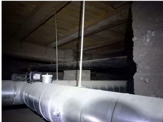
Kuva 106 a ja b. Kellarin ryömintätilassa on imukartioilla varustettu poistoilmakanavisto.
