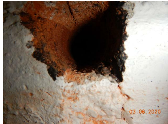
Kuva 17. Tilan 012 maanvastaiseen tiiliseinään tehtiin poraus RAMV1 (Ø 32mm, syvyys n. 35 cm). Seinän sisäpinnassa havaittiin bitumijäämiä, mutta ei yhtenäistä siveilyä. Seinä on todennäköisesti massiivitiilirakenteinen, sillä ulkopinta on myös tiiltä.
