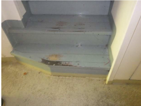
Kuvat 13 a ja b. Porrastilassa 010 puurakenteiset portaat nousevat kostean betonilaa- tan päällä. Portaiden alapuolisessa komerossa havaittiin lattiassa kosteudesta johtu- vaa pinnoitteiden vaurioitumista. Komeron maanvastaisten seinien sively sisältää kor- keita pitoisuuksia PAH-yhdisteitä (AHA-kartoitus, Vahinko Werker Oy 2015).
