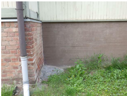
Kuva 7. a. Betoni- ja tiilisokkelin liittymä rakennuksen pohjoispuolelta. Betonisokkelirakenteissa ei havaittu kosteuden aiheuttamia jälkiä tai muita viitteitä vaurioista. Betonisokkelin osalla ei ole pellityksiä paneloinnin alaosassa. Alaosassa on viistetty tippalauta. b. Tiilisokkelissa havaittiin syöksytörven vuodosta kosteusvaurioitunut kohta pohjoisseinustalla.
