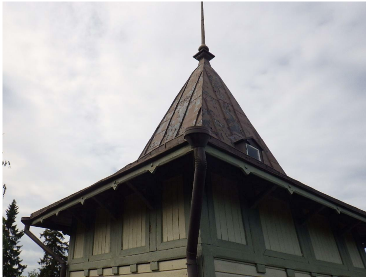
Kuva 82. Myös torniosalla vesikate palapeltiä. Torniosan vesikate on muita katto-osia heikommassa kunnossa.
