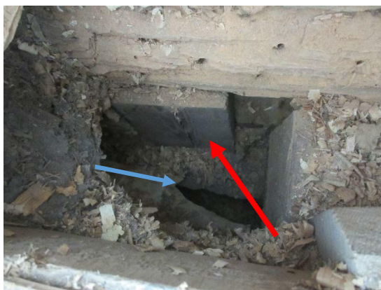
Kuvat 32 a ja b. Alapohjan tasossa hirsien pinnoilla havaittiin laho- ja hyönteisvaurioita muutamien senttimetrien syvyydelle. Poralla koestaen syvemmällä oli kovaa puuta. Rakennuksen alimmat hirsilinjat on kertaalleen uusittu ulkoa käsin. Alin hirsi on poistettu ja korvattu puisilla korotustolpilla (punainen nuoli). Puutolppien välissä on eristevillakaista poistetun hirren paikalla. Alapohjan täyttömateriaalina on hiekkaa ja puulasua. Alapohjan täyttöeristeestä otetussa materiaalinäytteessä ei havaittu mikrobikasvua materiaalissa (MAT1). Kivisokkelin reuna on merkitty sinisellä nuolella. Ulkoseinä-alapohjaliittymästä on 5...10 cm leveä ilmavuoretti alustatilaan.
