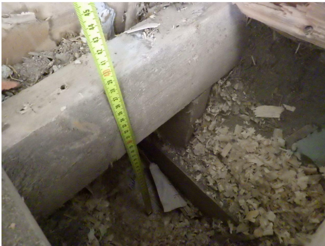
Kuva 35. Alapohjan eristemateriaalina on puulastua ja hiekkaa. 50*100 mm koolaus on asennettu puisten korokepalojen päälle. Lastu- ja hiekkatäytön alla aluslaudoituksen päällä on sanomalehtiä. Puurakenteissa ei todettu viitteitä kosteusvaurioista.
