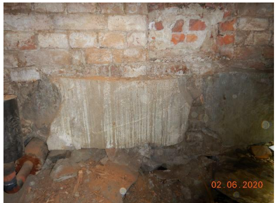
Kuvat 23 a ja b. Rakennuksen perustuksena on ulkoseinillä luonnonkivilatomus, jonka päällä on sokkelitiilimuuraus. Rakennuksen keskiosalla on betonianturoita. Betonianturoiden muottilautoitus on jätetty paikalleen. Muottilautoituksessa on kosteus- ja mikrobivaurioita.
