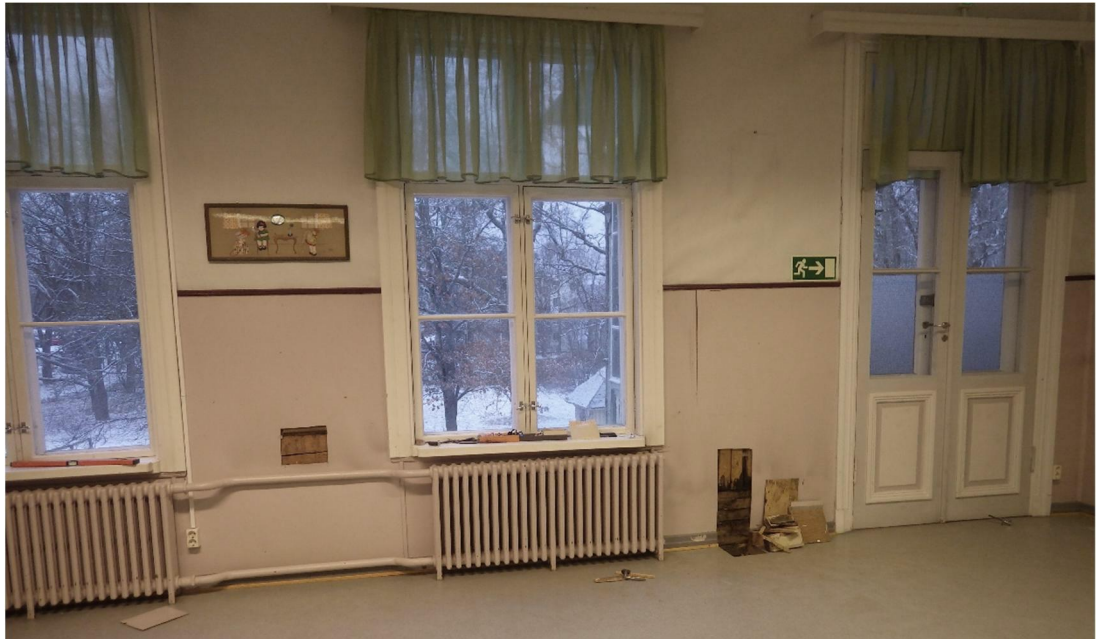
Kuva 69. Oikealla rakenneavaus RAUS7 ja vasemmalla vaneripinnan avaus, josta tarkastettiin, että RAUS7:ssä havaittu pystyhirsirakenne on vain paikallinen korjaus.
