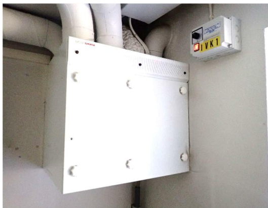
Kuva 98 a ja b. Yleiskuvia MUH-Ilmava malli: B 3461 ilmanvaihtokoneesta. IV-koneet ovat 4-portaisia muuntajateho-ohjattuja. Säästöyksiköt sijaitsevat iv-koneiden läheisyydessä.
