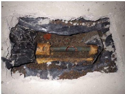
Kuva 28. Rakenneavaus RAAP6 tehtiin kellarikäytävän 008 lattiaan. Rakenneavauksesta havaittiin alapohjan eristeenä kevytsoraa kahden muovikalvon välissä ja tämän alla hiekkaa, jossa oli vesijohtoja. Syvyydellä ~400 mm lattiapinnasta todettiin kova pinta, joka on todennäköisesti vuoden 1926 betonialapohja.
