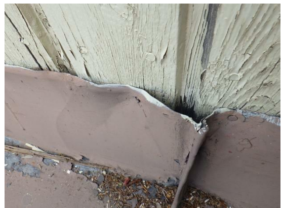
Kuvat 83 a...c. Pellitysten ylösnostojen vesitiiveydessä on puutteita. Sisäänkäynnin kohdalla olevan pulpettikaton vesikatteen ylösnoston liittymä ulkoseinäverhoukseen ei ole tiivis ja kohdalla on päässyt vettä rakenteisiin (kuva a). Vaurioita on myös seinärakenteen sisäpuolella, jossa tapetin alla havaittiin selvä mikrobikasvu. (Ks. Kuvat 53.) Ylösnostoissa on vesitiiveyspuutteita myös tornin kohdalla (kuvat b ja c).
