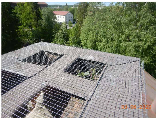
Kuvat 90 a ja b. Piipuissa ei ole sääsuojaa / piipunhattua. Piippujen sisällä havaittiin irrallaan olevia ja lohjonneita tiiliä. Piipun yläpää on suojattu pieneläinverkolla.
