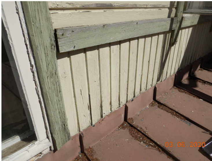
Kuva 82. Myös torniosalla vesikate palapeltiä. Torniosan vesikate on muita katto-osia heikommassa kunnossa.
