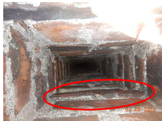
Kuvat 90 a ja b. Piipuissa ei ole sääsuojaa / piipunhattua. Piippujen sisällä havaittiin irrallaan olevia ja lohjonneita tiiliä. Piipun yläpää on suojattu pieneläinverkolla.
