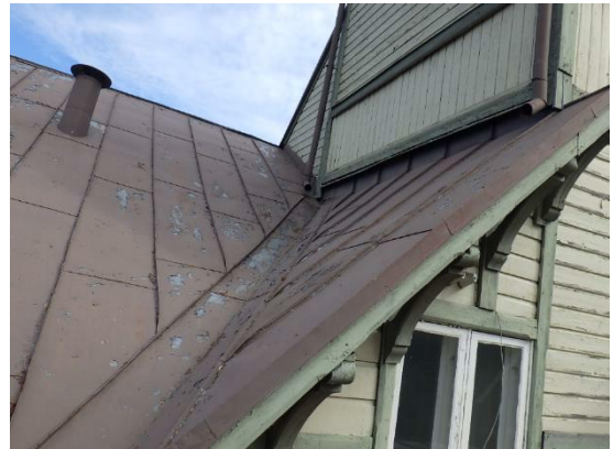
Kuvat 80 a ja b. Yleiskuvia vesikatolta. Maalipinta irtailee laaja-alaisesti etenkin vesikatkon harjan eteläpuolella.
