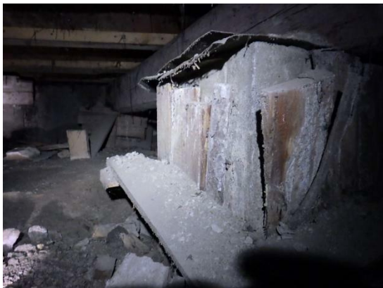
Kuvat 23 a ja b. Rakennuksen perustuksena on ulkoseinillä luonnonkivilatomus, jonka päällä on sokkelitiilimuuraus. Rakennuksen keskiosalla on betonianturoita. Betonianturoiden muottilautoitus on jätetty paikalleen. Muottilautoituksessa on kosteus- ja mikrobivaurioita.
