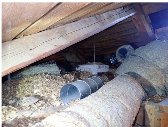
Kuva 103. MUH-Ilmava merkkisten ilmanvaihtokoneiden ilmanvaihtokanavat ovat kokoa 125 mm ja 100 mm. Kanavistossa ei havaittu olevan äänenvaimentimia.
