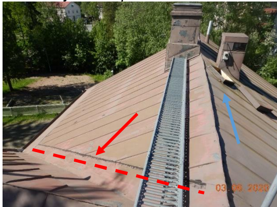
Kuvat 81 a ja b. Yleiskuvia vesikatolta. Vuotanutta katon jiirikohtaa on korjattu bitumoi-malla (punainen merkintä). Eteläisellä puoliskolla keltaisella rajatulla alueella vesikate on palapeltiä. Muilla katon osilla vesikatteena on täysipitkää rivipeltikate. Kattoluukulta kulkusillalle ei ole turvallista reittiä (sininen merkintä).
