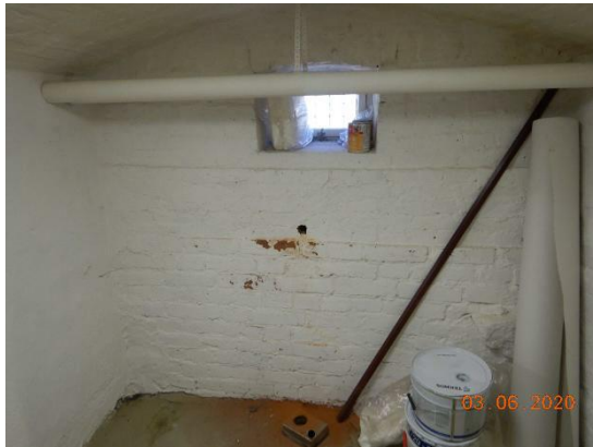
Kuva 17. Tilan 012 maanvastaiseen tiiliseinään tehtiin poraus RAMV1 (Ø 32mm, syvyys n. 35 cm). Seinän sisäpinnassa havaittiin bitumijäämiä, mutta ei yhtenäistä siveilyä. Seinä on todennäköisesti massiivitiilirakenteinen, sillä ulkopinta on myös tiiltä.
