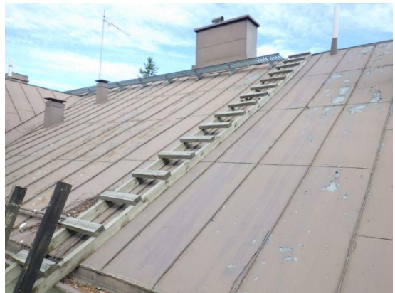
Kuvat 87 a ja b. Puiet kattotikkaat ovat huterat ja ikääntyneet. Tikkaiden alempi osa on pehmenyt ja ruuviliitos tikkaiden ylemmän osaan on löystynyt. Tikkaat on kiinnitetty ruuveilla katon harjan toiselta puolelta peltikatteen läpi.
