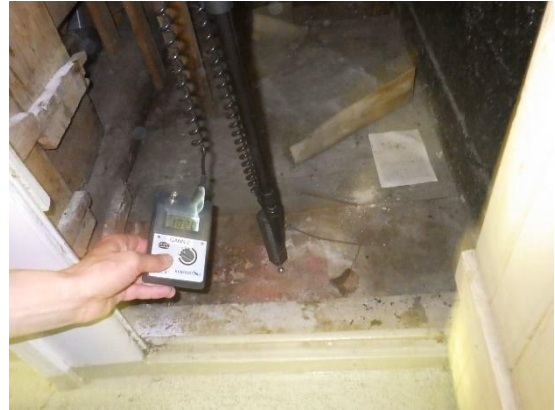
Kuvat 13 a ja b. Porrastilassa 010 puurakenteiset portaat nousevat kostean betonilaa- tan päällä. Portaiden alapuolisessa komerossa havaittiin lattiassa kosteudesta johtu- vaa pinnoitteiden vaurioitumista. Komeron maanvastaisten seinien sively sisältää kor- keita pitoisuuksia PAH-yhdisteitä (AHA-kartoitus, Vahinko Werker Oy 2015).
