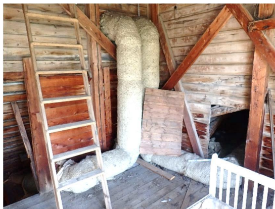
Kuva 103. MUH-Ilmava merkkisten ilmanvaihtokoneiden ilmanvaihtokanavat ovat kokoa 125 mm ja 100 mm. Kanavistossa ei havaittu olevan äänenvaimentimia.
