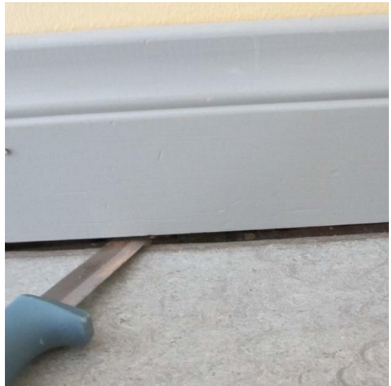
Kuvat 47 a...b 2. Kerroksen hirsirakenteisissa välipohjissa havaittiin paikallista painumaa.
