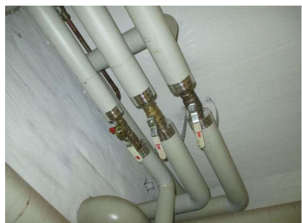
Vesijohdot ovat kuparia
