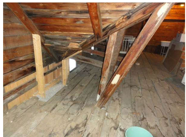
Korjattua rakennetta yläpohjatilassa.
