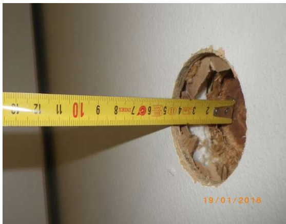
Rakenteen avaus ensimmäisen kerroksen ulkoseinään.
