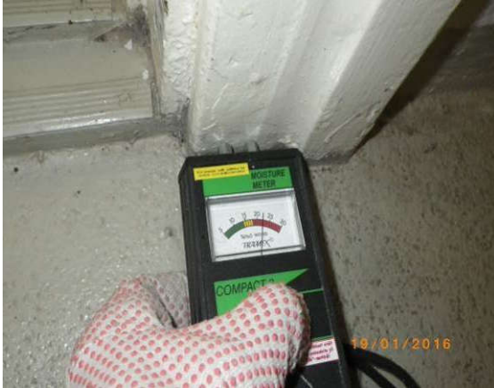
Kosteusmittausta kellarikerroksen oven listoituksesta puunkosteusmittarilla.
