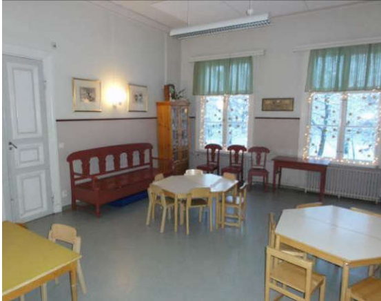
Sisätilojen kunto on yleisesti ottaen vähintään tyydyttävä.
