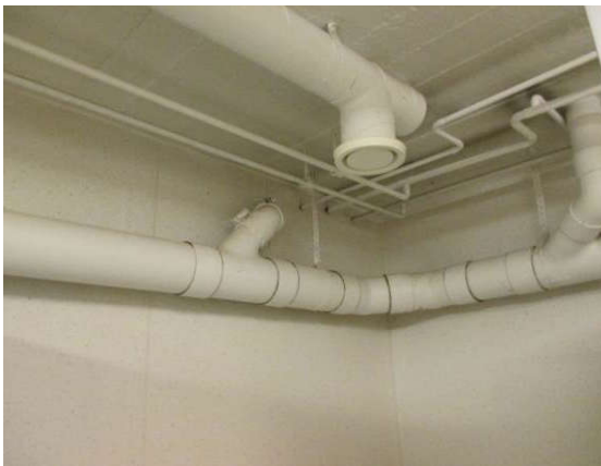
Kellarissa on hieman valurautaviemärointiä
