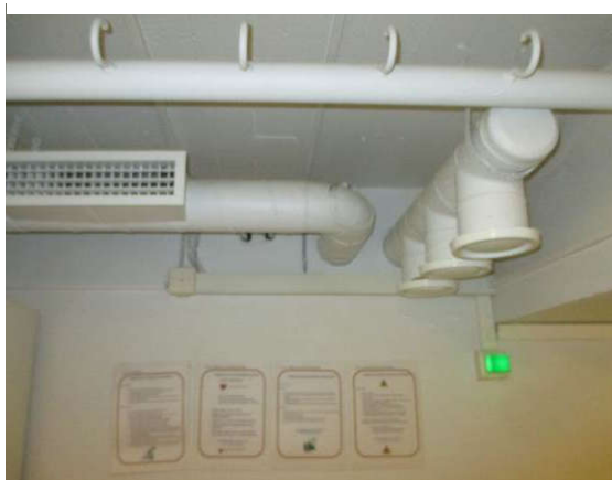
Ilmanvaihtokanavissa tai kanavavarusteissa ei havaittu puutteita
