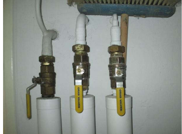
Vesijohdot venttiileineen ovat 1990-lun alkupuolen aikaisia asennuksia
