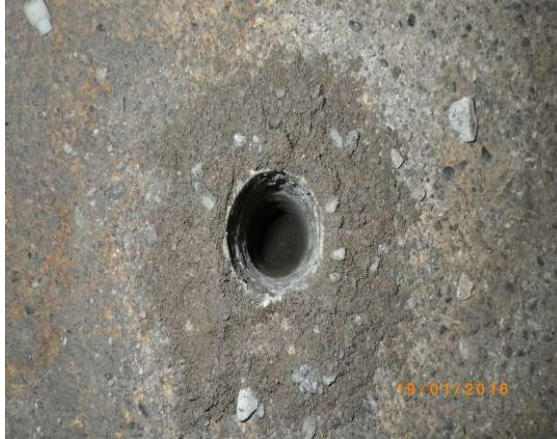
Poraus lämmönjakohuoneen lattiaan.
