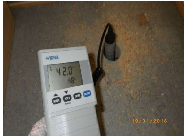
Kosteusmittausta kantavasta ryömintätilallisesta alapohjarakenteesta.
