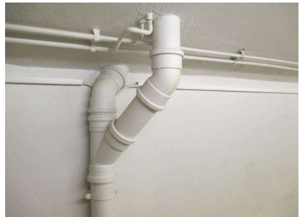
Pääosin viemärit ovat kuitenkin muovia
