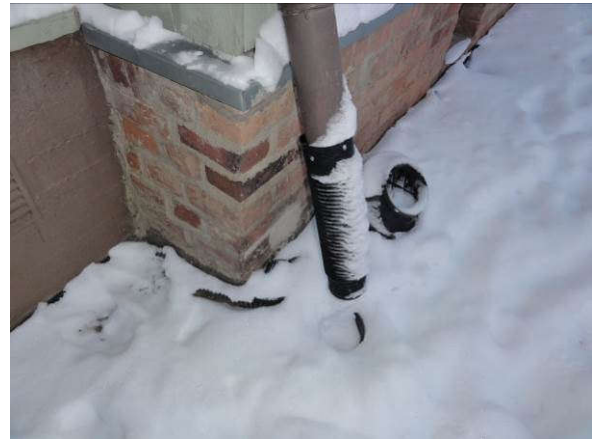
Kattovesien johtuminen kaupungin järjestelmään tulee varmistaa.
