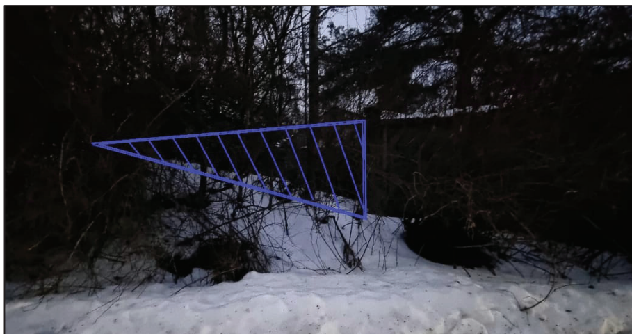
Kuva 4. Hallilantie meluseinän ja meluvallin väliin jää nykyisin aukko. Meluseinää ehdotetaan jatkettavaksi kuvassa esitetyllä tavalla. Seinän jatkon myötä kohteen piha-alueen eteläosassa eivät melun ohjearvot enää ylittyisi.
