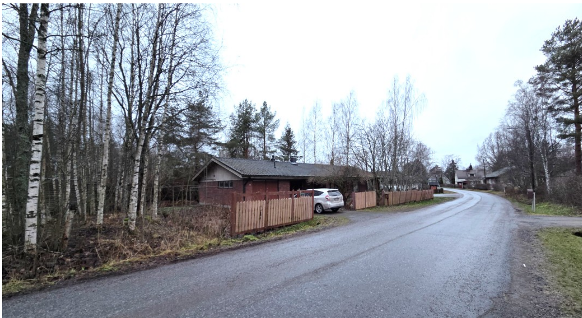
Kuva 3. Tontin asuinrakennus joulukuussa 2025. Rakennus ja aita on purettu keväällä 2026. Kuva: Saija Kouko, ©Tampereen kaupunki 2026.
