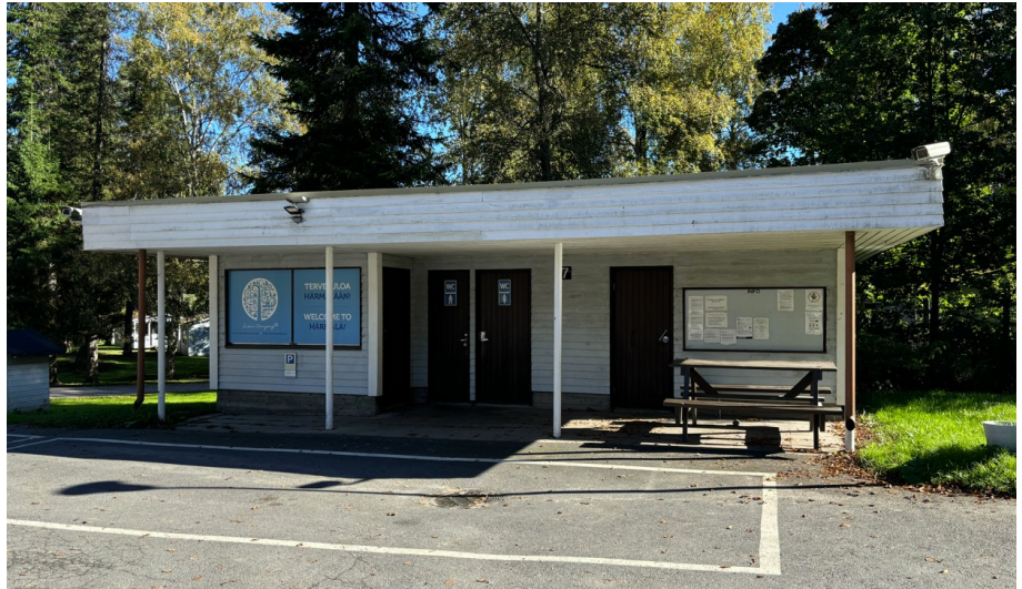
Kuva 22. Vastaanottorakennukset ovat kesäkäytössä ja melko kuluneita
