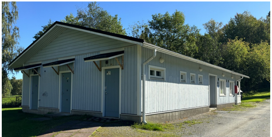
Kuva 28. Uudemmat huoltorakennukset ovat melko hyvässä käyttökunnossa
