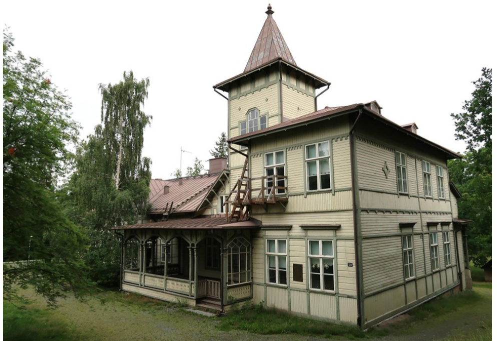
Kuva 16. Lepolan huvilan julkisivu eteläpuolelle. Kuva Rakennushistoriaselvitys, Vahanen 2020.
