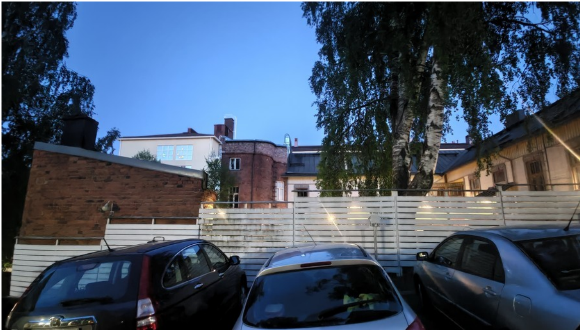
Kuva 4. Selvitysalueen potentiaalisimmaksi lepakoiden päiväpiiloksi arvioitu rakennus on puinen ja siinä on tiilinen päätyosa.
