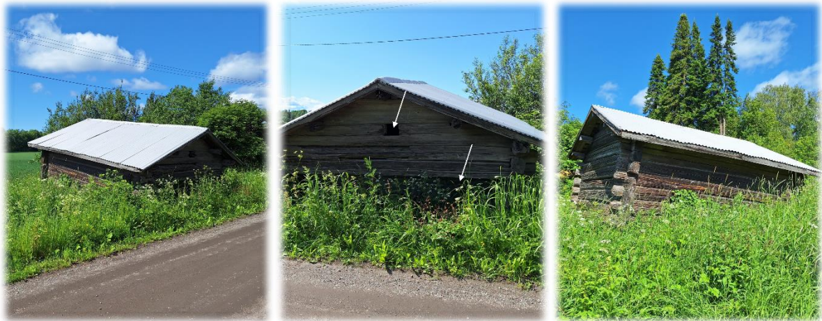
Kuva 8. Vasemalla näkymä tieltä, keskellä tien puoleinen sivu, nuolet osoittavat sisäänkäynnin rakennukseen, oikealla rakennuksen takapuoli.
