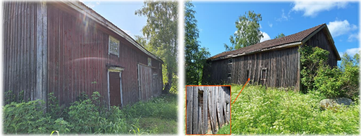
Kuva 4. Vanha maatilan vaja, vasemmalla rakennuksen pohjoinen puoli, oikealla rakennuksen eteläinen puoli, ja huomiokohdassa löysät laudat.
