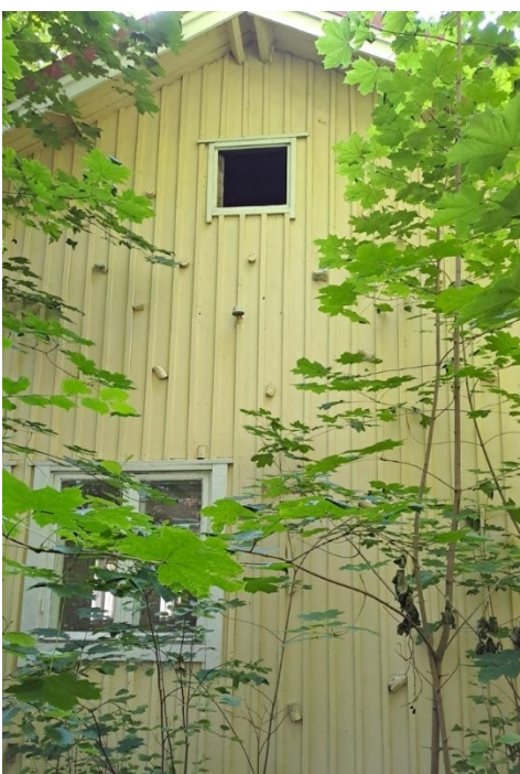
Kuva 2-7. Varastorakennuksen avoin ikkuna vinttitilaan.
