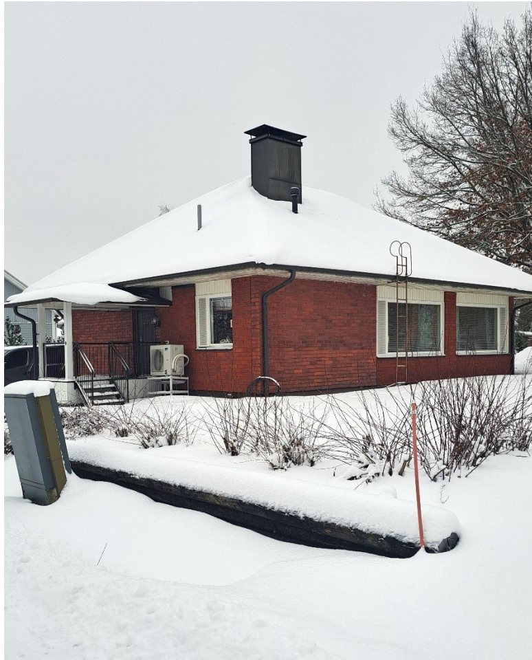
Kuva 2. Tontilla sijaitseva asuinrakennus Viholankadulta kuvattuna. © Tampereen kaupunki 2026.
