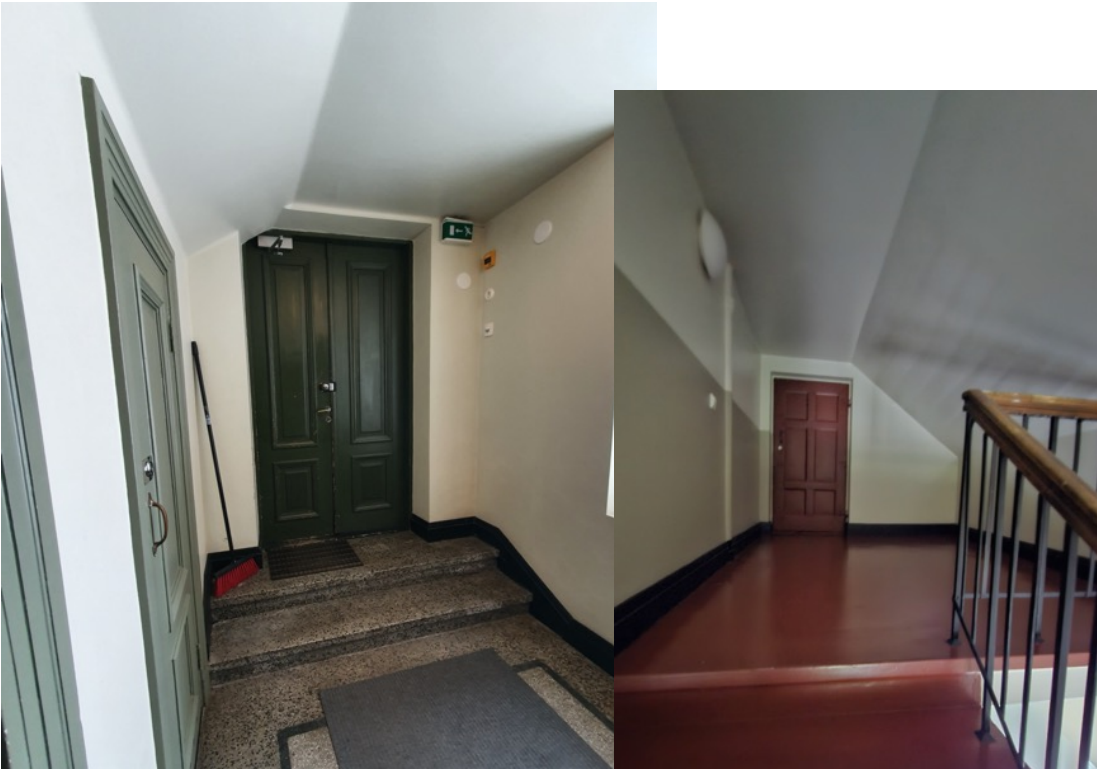
1.krs pääporrashuoneen sisäpihan uloskäynti ja läntisen porrashuoneen ullakon sisäänkäynti. Mari Granberg
