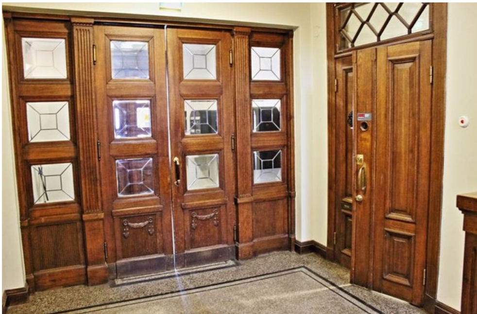
Pääsisäänkäynnin tuulikaapin ovi porrashuoneeseen ja toimistohuoneiston porrastaso-ovi, Kirsi Hyrkkönen
