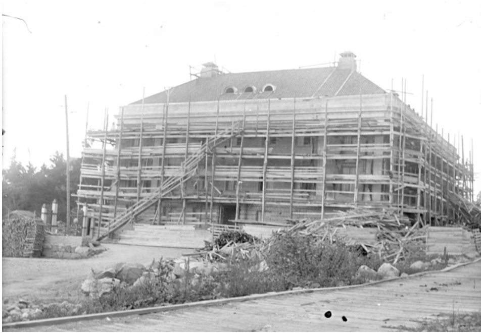
Konttorirakennus rakenteilla 1924 Valokuvaamo N. Rasmusen, Vapriikin kuva-arkisto
