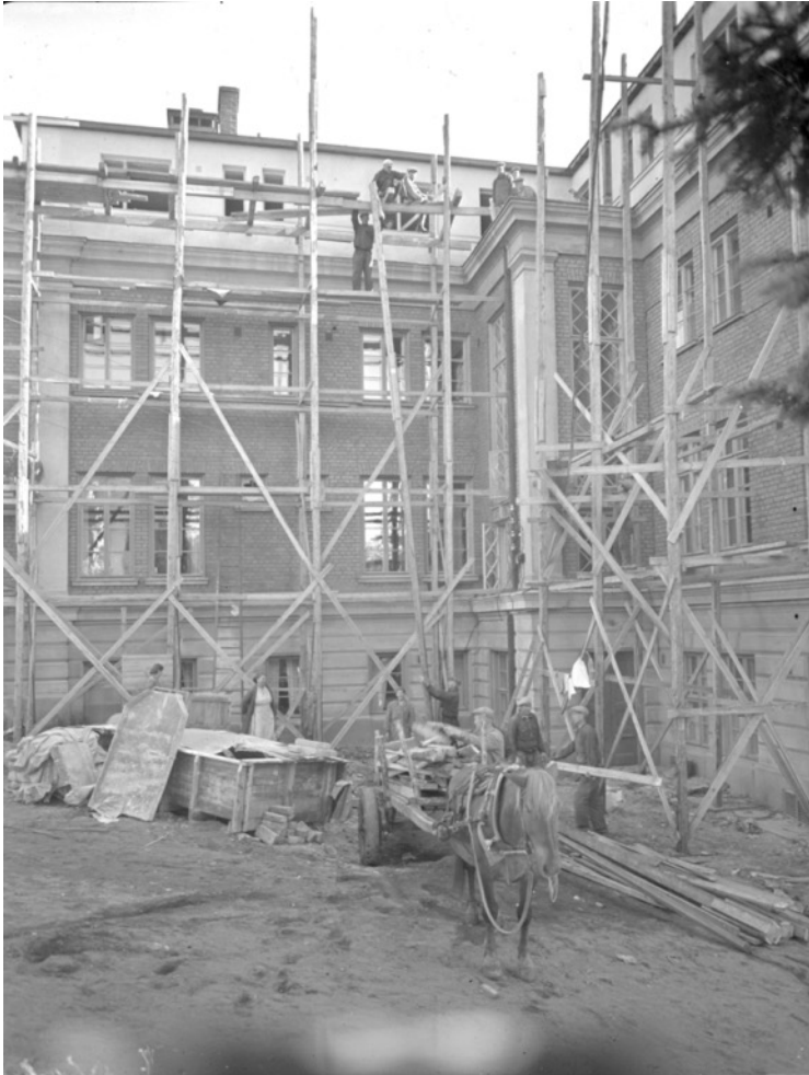
Konttorirakennuksen yläosan rakennustyöt arviolta 1945. Vapriikin kuva-arkisto.
