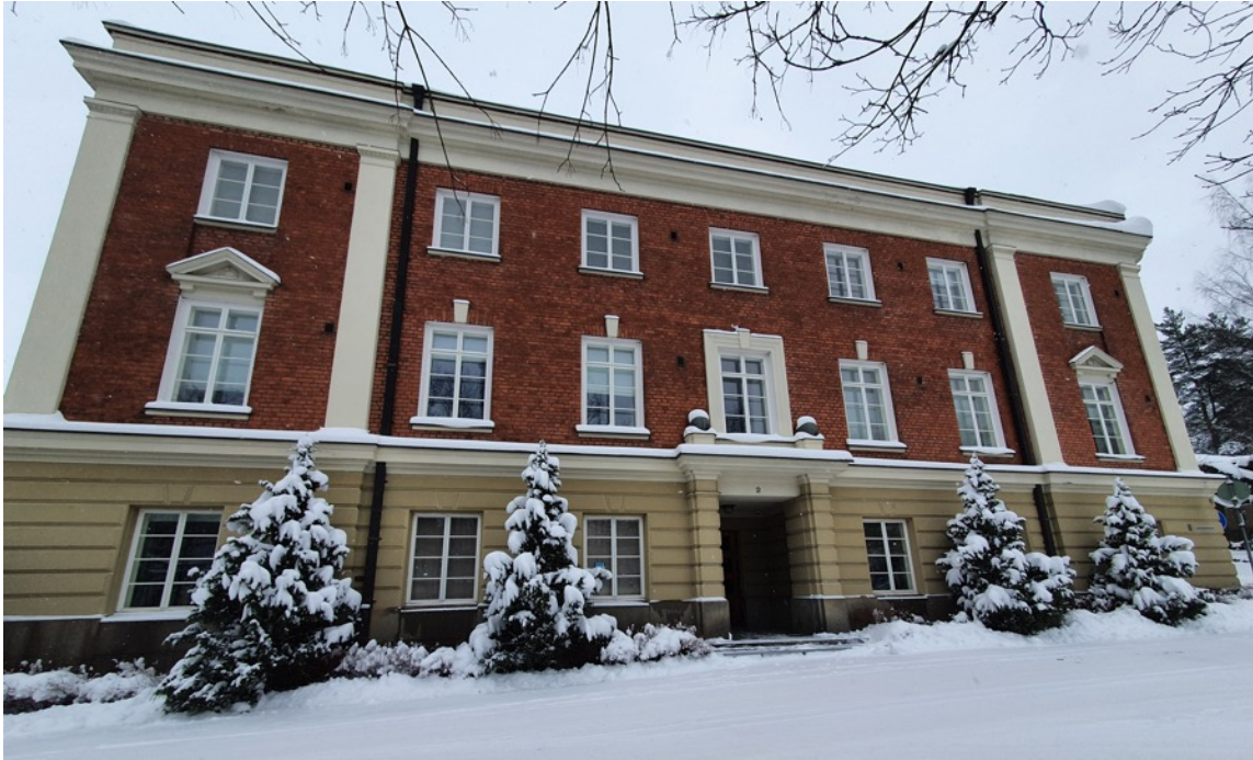
Julkisivu etelään Lapinniemenrannan suuntaan. Mari Granberg.
