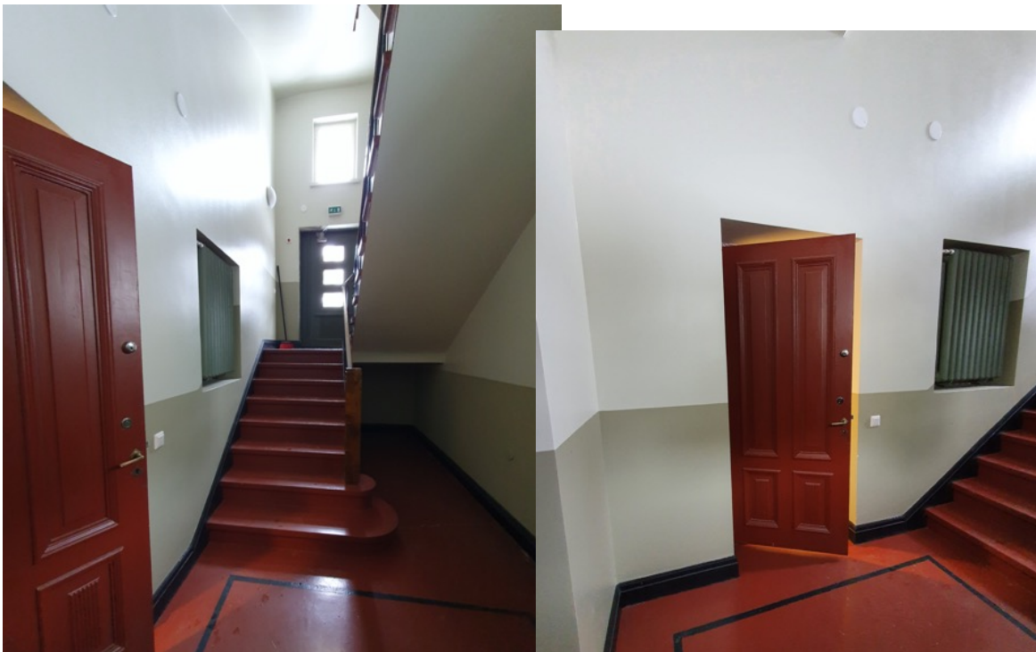
Pohjoisen porrashuoneen 1.krs uloskäynti ja toimistohuoneiston sisäänkäynti. Mari Granberg.
