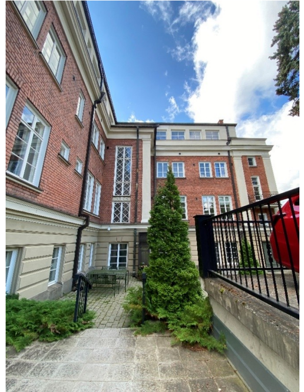
Kuva 5. Valokuva takapihalta, ullakkokerroksen nykyiset ikkunat oikealla ylhäällä.
