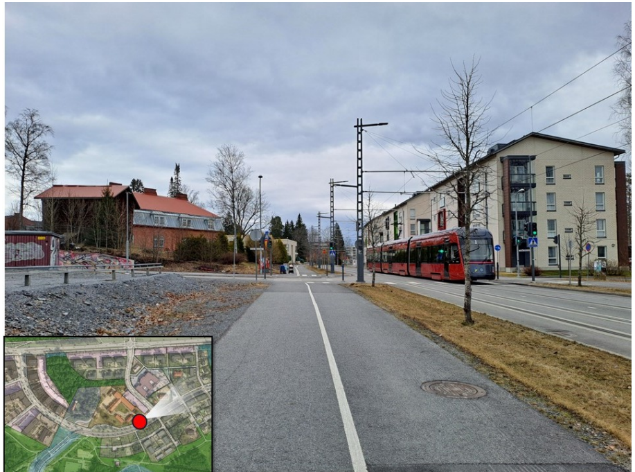
Kuva 10 Valokuva Matilda Niemen kadun ja Federleynekadun risteyksestä kohti itää. Kuvan vasemmalla laidalla näkyvät kaava-alueen ulkopuolelle jäävät Niemen kartanon alueen tiilinen virkamiesasunto ja aitta. Federleynekadun oikealla puolella on nelikerroksinen 2010-luvun lopulla valmistunut nelikerroksinen kerrostalo. Kartta esittää valokuvan ottopaikan ja suunnan.
