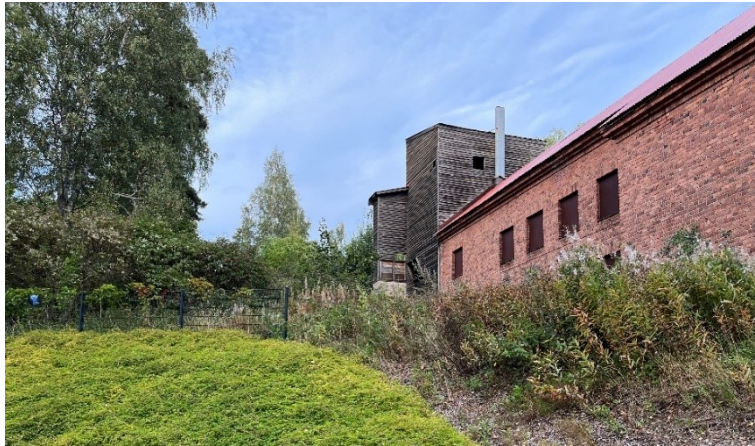
Kuva 6 Niemen mylly ja sen puurakenteinen laajennusosa kuvattuna etelän suunnasta kuvattuna kesällä 2024.
