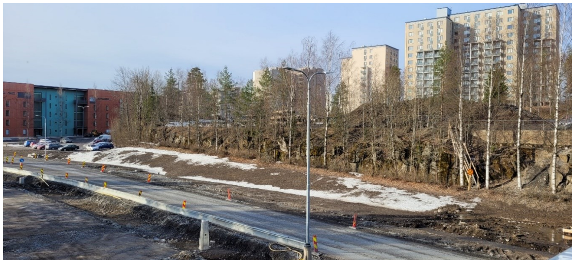
Kuva 2 Hervannan valtavyölyän länsipuolella on jonkin verran puustoa kalliioleikkauksen edustalla.
