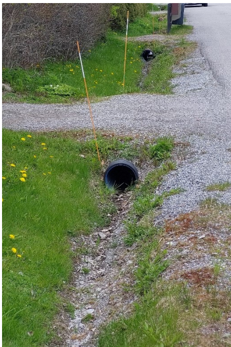
Kuva 2. Vasemmalla katuoja, jossa kiinteistön tonttiliittymä ja liittymän allittava ojarumpu. Oikealla sadevesikouru.
