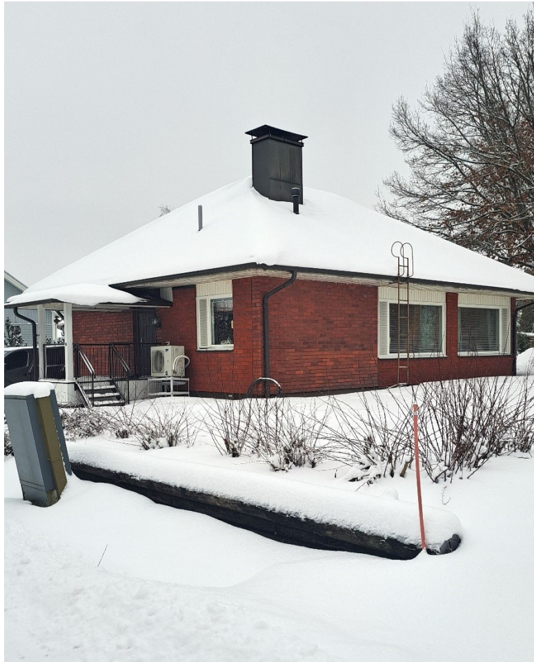
Kuva 2. Tontilla sijaitseva asuinrakennus Viholankadulta kuvattuna. © Tampereen kaupunki 2026.
