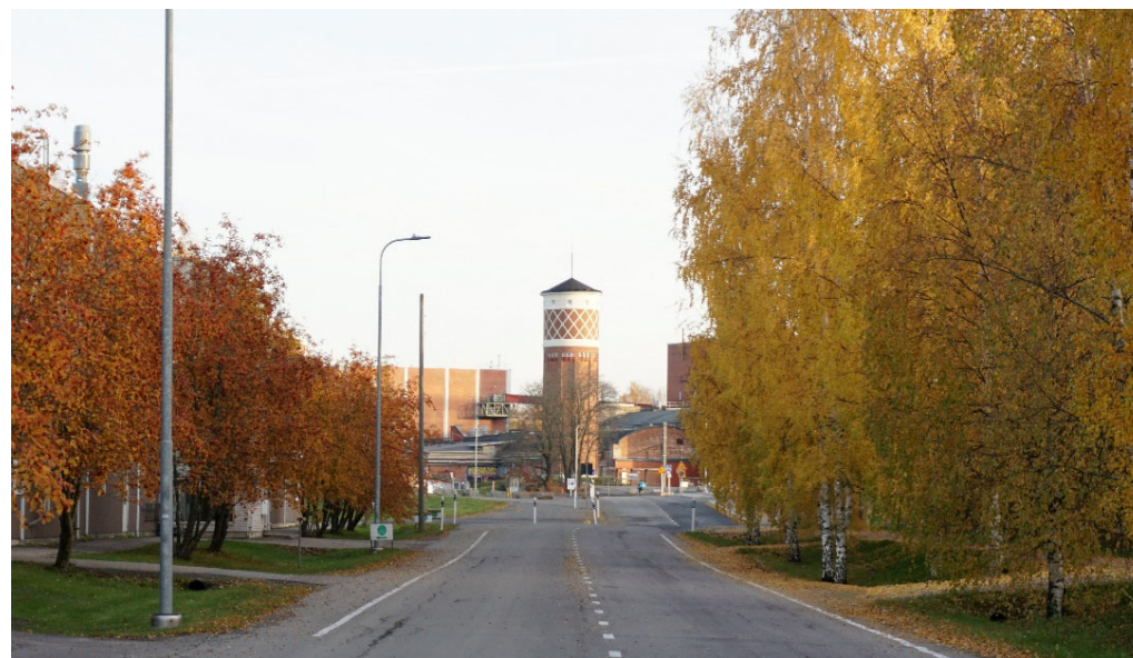
Näkymä Tehdaskartanonkatua kaakkoon. Päättänä tehtaan vesitorni.
