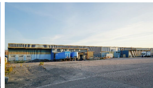
Teollisuuskiinteistö alueen eteläpuolella
