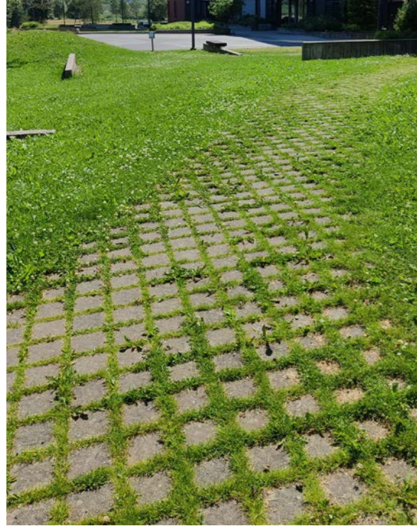
Osittain hulevesiä läpäisevä nurmikivi sopii pihan toissijaisille reiteille ja vähemmän käytetyille pinnoille.
