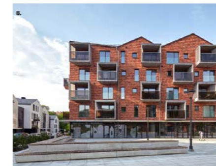
Kaupunkimainen arkkitehtuuri vaihtelevilla kattomuodoilla
