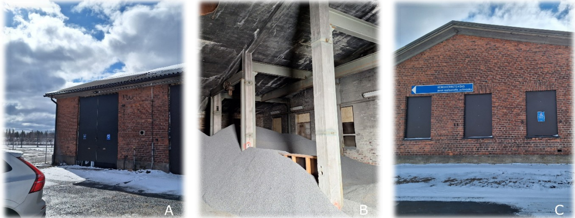
Kuva 4-6. Ronttila: A) kuva rakennuksen pohjoissivusta, B) kuva varastorakennuksen sisätiloista, C) kuva rakennuksen itäisivusta.
