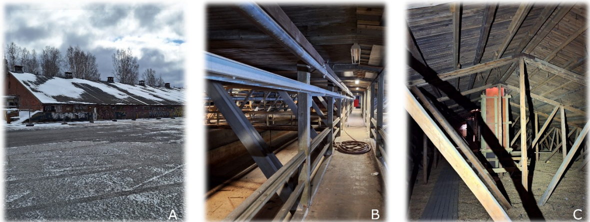
Kuva 4-5. Vesilaitoksen pohjoisosa: A) kuva rakennuksen ulkopuolelta, B) pohjakerros; vasemmalla vanhat vesisäiliöt, C) kuva kattorakenteen alta.
