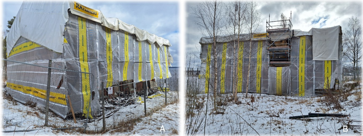
Kuva 4-8. Pumpaamo: A) kuva rakennuksen eteläsivusta ja telineistä, B) näkymä pohjoissivulta.
