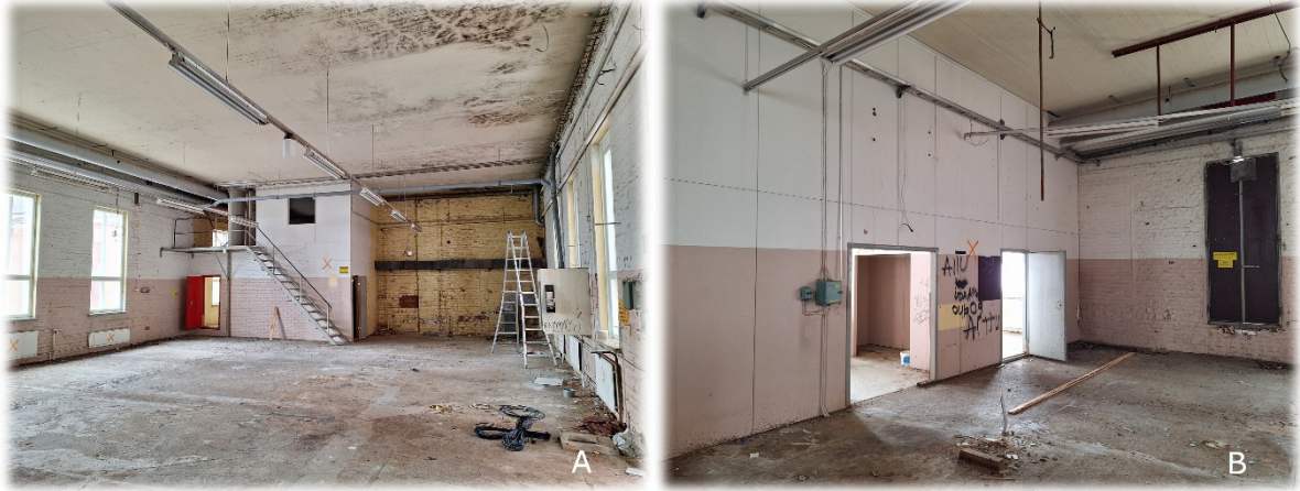
Kuva 4-4. Verstaas, 2. kerros — kuvat A ja B havainnollistavat rakennuksen sisätiloja.
