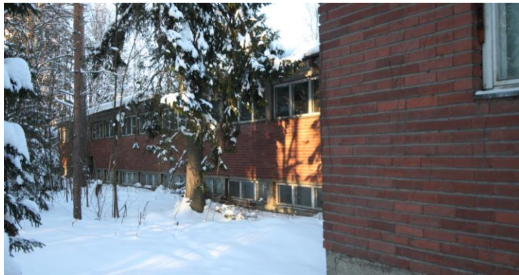
Kuva 44. Autohallin eteläjulkisivu. Kuvan vasemmassa reunassa näkyy nauhaikkunoiden jäsentämä autohallin eteläjulkisivu. Kuvan oikeassa reunassa näkyy asuntosiipeä.
