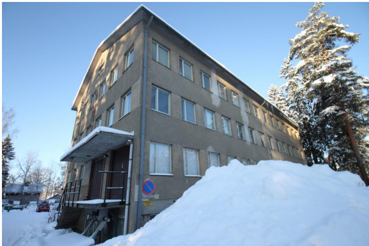
Kuva 36. Pienteollisuustalo sijaitsee n. 8 metrin etäisyydeltä Ali-Huikkaantien jalkakäytävän reunasta. Lumisena talvena kadun ja talon väliin on aurattu korkea kinos lunta. Lumettomaan aikaan pienteollisuustalo rajaa voimakkaammin katunäkymää. Kuvan vasemmassa reunassa näkyy taustalla jälleenrakennuskauden asuintalo pienteollisuustalon pihan yli Ali-Huikkaantielle. Kasvukaudella lehtipuut luultavasti peittävät näkymät asuinalueelle. Kuvan oikeassa reunassa näkyy pienteollisuustalon tontin koilliskulmassa katulinjassa kiinni kasvavat kookkaat havupuut, joiden takia pienteollisuustalo ei näy pohjoispuoleltaan Ali-Huikkaantielle.
