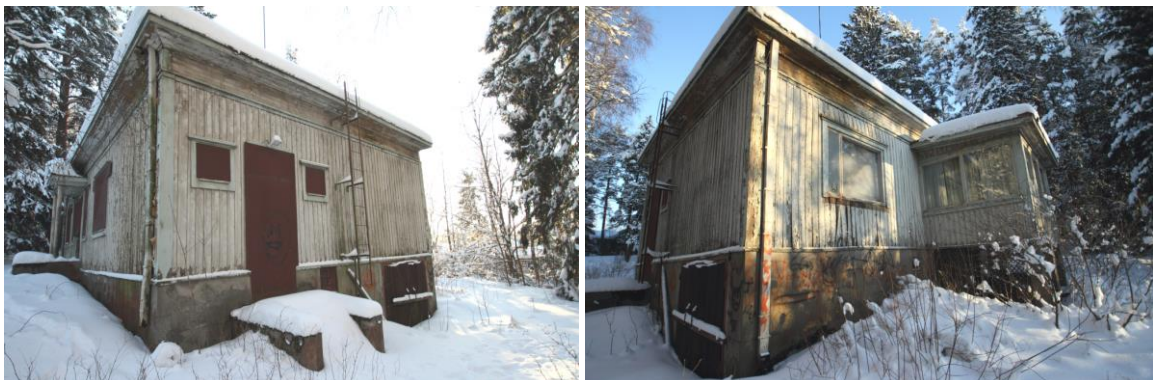
Kuva 59 vasemmalla. Asuinrakennuksen länsijulkisivu. Kuvassa näkyy sivusisäänkäynnin rakennuslevyllä peitetty ulko-ovi ja sen molemmiin puolin olevat pienet ikkunat. Betoniportaikko jää lähes lumen alle. Rinteeseen sijoittuvan rakennuksen kivijalka on länsijulkisivulla korkeampi kuin pohjoisjulkisivulla. Kuvassa näkyy myös kellariin tehdyn autotallin ovi.
