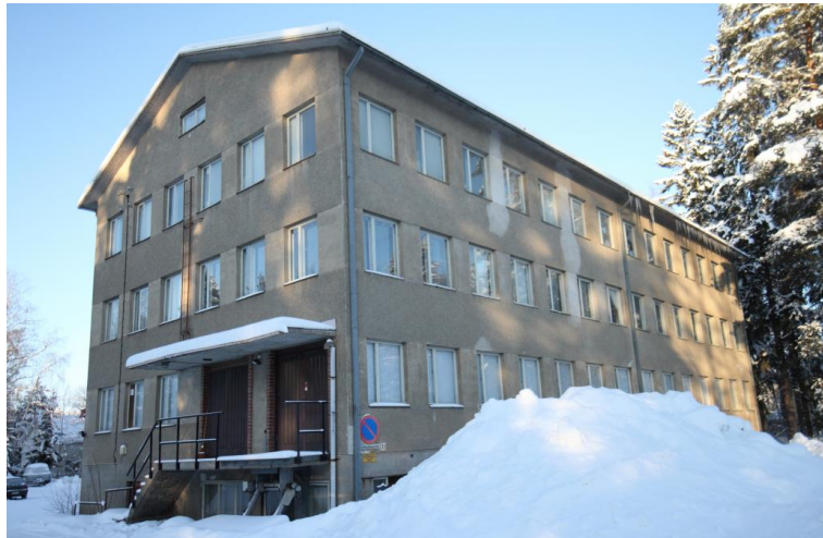
Kuva 30. Pienteollisuustalon etelä- ja itäjulkisivu. Rakennuksen ulkonäköä on kuvattu edellä tekstissä.
