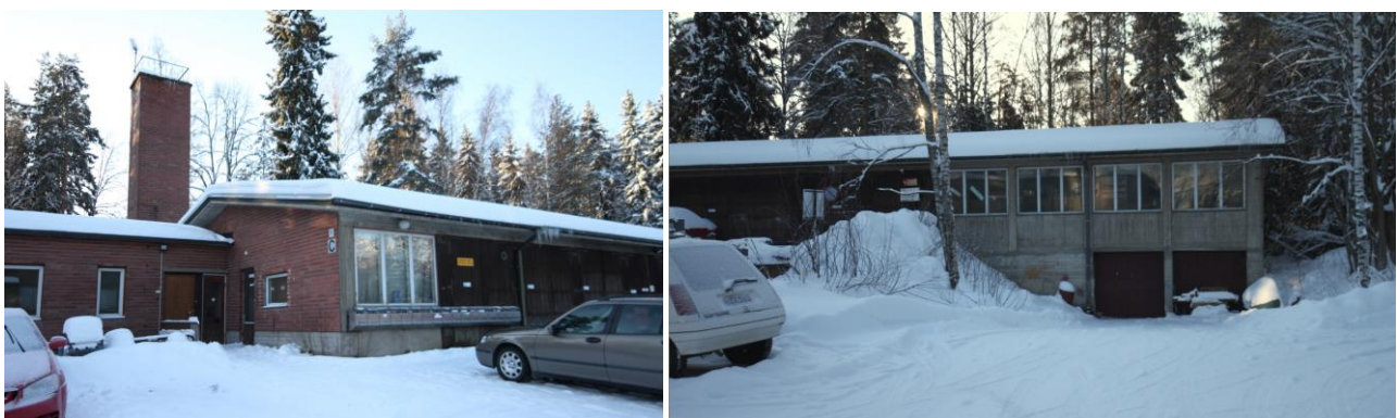
Kuva 45. (vasemmalla). Autohallin eteläjulkisivu. Kuvan vasemmassa reunassa näkyy asuntosiipeä ja oikeassa reunassa autohallia. Autohallin julkisivu koostuu halliin johtavista suurista pariovista. Asuntosiiven ja autohallin välissä on korkea savupiippu.
