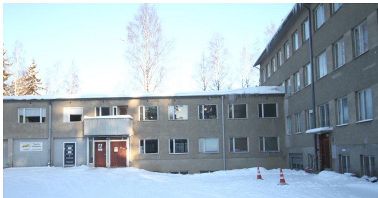
Kuva 31. Pienteollisuustalon pihajulkisivut. Kuvan vasemmassa reunassa näkyy kaksikerroksinen lisäsiipi ja oikeassa reunassa alkuperäisen rakennusosan pihanpuoleinen julkisivu. Kumpaankin osaan on sisäänkäynnit pihan puolelta.
