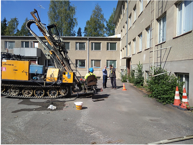
Kuvat 7-8. Kuvissa tutkimuspiste TP 32, joka oli vinokairauspiste. Ensin kairattiin 57 ° kulmalla 3,5 m syvyyteen asti ja sitten 45 ° kulmalla syvyyteen 4,0-5,5 metriä.
