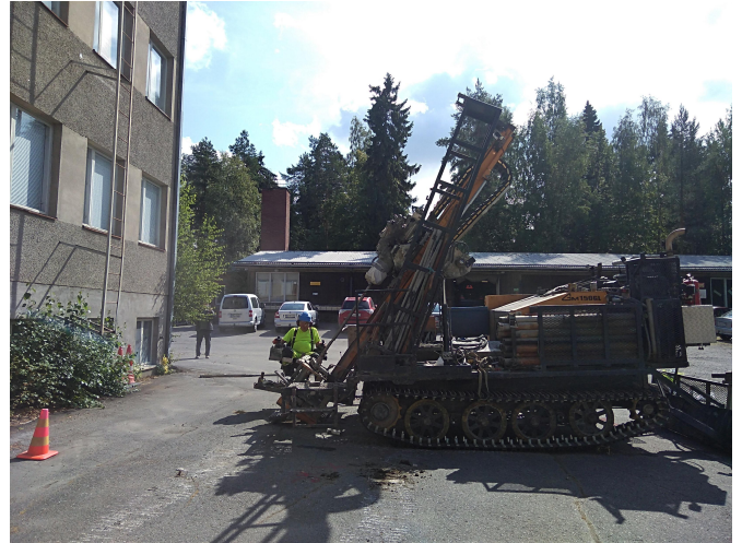
Kuvat 7-8. Kuvissa tutkimuspiste TP 32, joka oli vinokairauspiste. Ensin kairattiin 57 ° kulmalla 3,5 m syvyyteen asti ja sitten 45 ° kulmalla syvyyteen 4,0-5,5 metriä.
