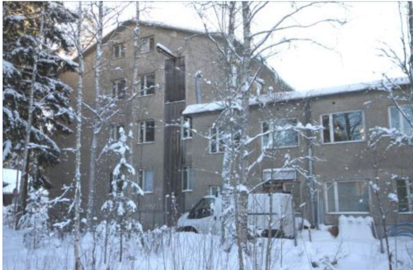
Pienteollisuustalon pohjoisjulkisivu. Kuvassa vasemmalla näkyy rakennuksen alkuperäinen osa ja päädyssä kolmannessa kerroksessa oleva lastausovi.
