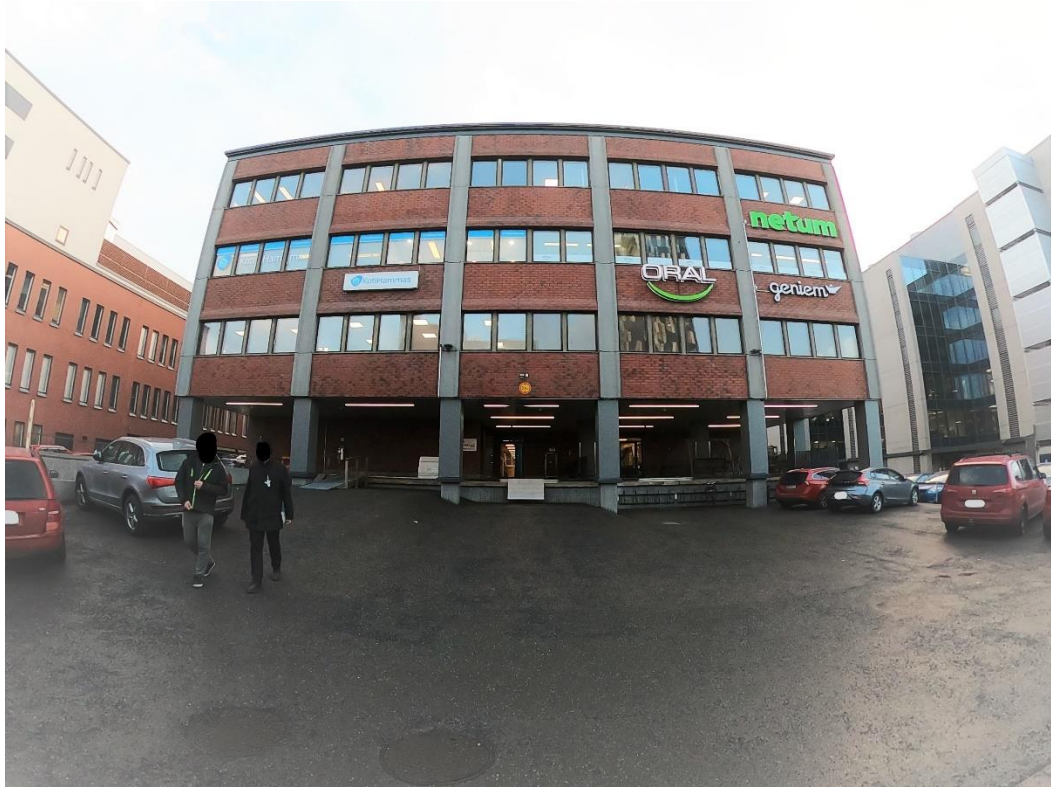
Kuva 30 Rakennus kuvattuna Åkerlundinkadulta 360 kameralla. Kuva Anniina Grönholm 2021 ARCO Architecture Company Oy
