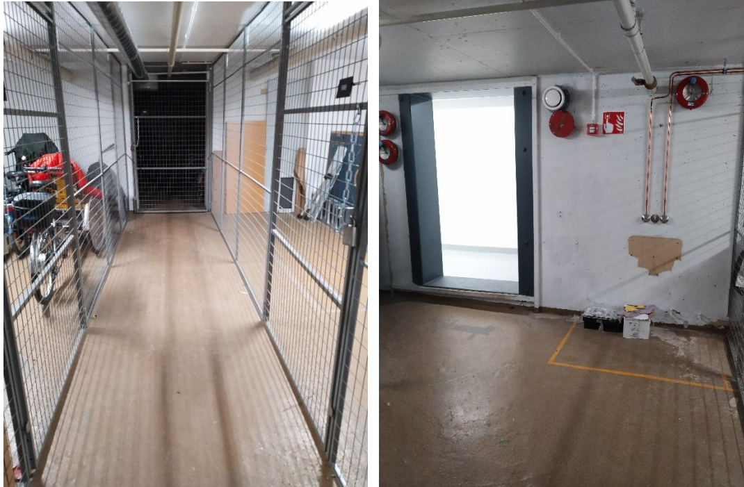
Kuva 61 Häkkivarasto kellarikerroksessa, alkuperäinen lattiapinnoite. Kuva Anniina Grönholm 2021 ARCO Architecture Company Oy Kuva 62 Häkkivarasto kellarikerroksessa, alkuperäinen lattiapinnoite, väestönsuoja. Kuva Anniina Grönholm 2021 ARCO Architecture Company Oy
