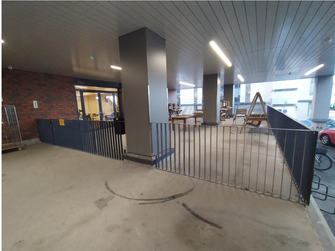
Kuva 38 Metallikaiteella rajattu vuokralaisen tila Åkerlundinkadun lastausalueella. Kuva Anniina Grönholm 2021 ARCO Architecture Company Oy
