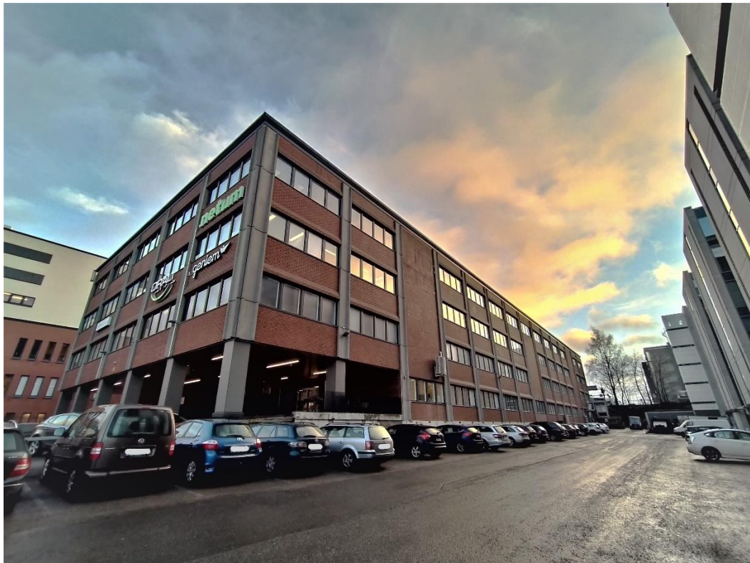
Kuva 29 Rakennus kuvattuna Åkerlundinkadulta. Kuva Anniina Grönholm 2021 ARCO Architecture Company Oy.
