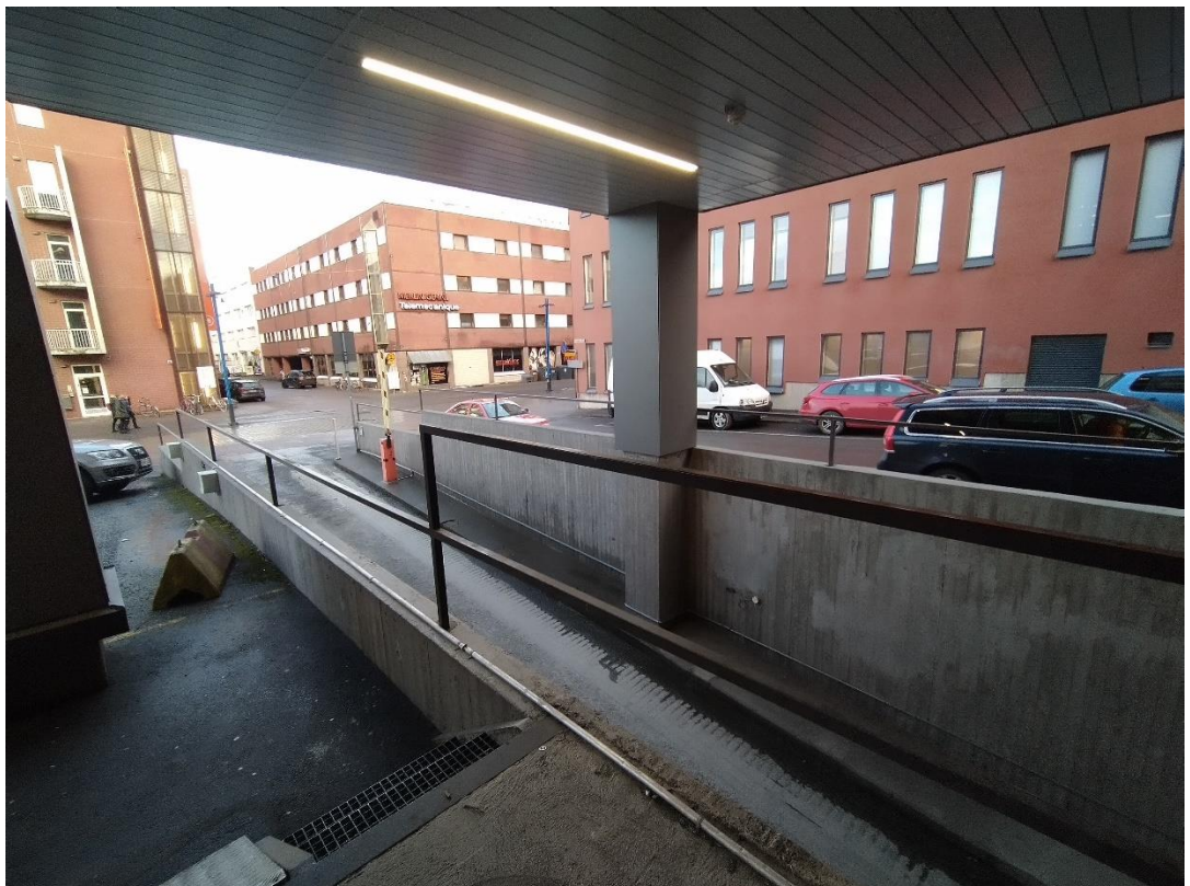
Kuva 37 Ajoluiska pysäköintihalliin Åkerlundinkadulta. Kuva Anniina Grönholm 2021 ARCO Architecture Company Oy
