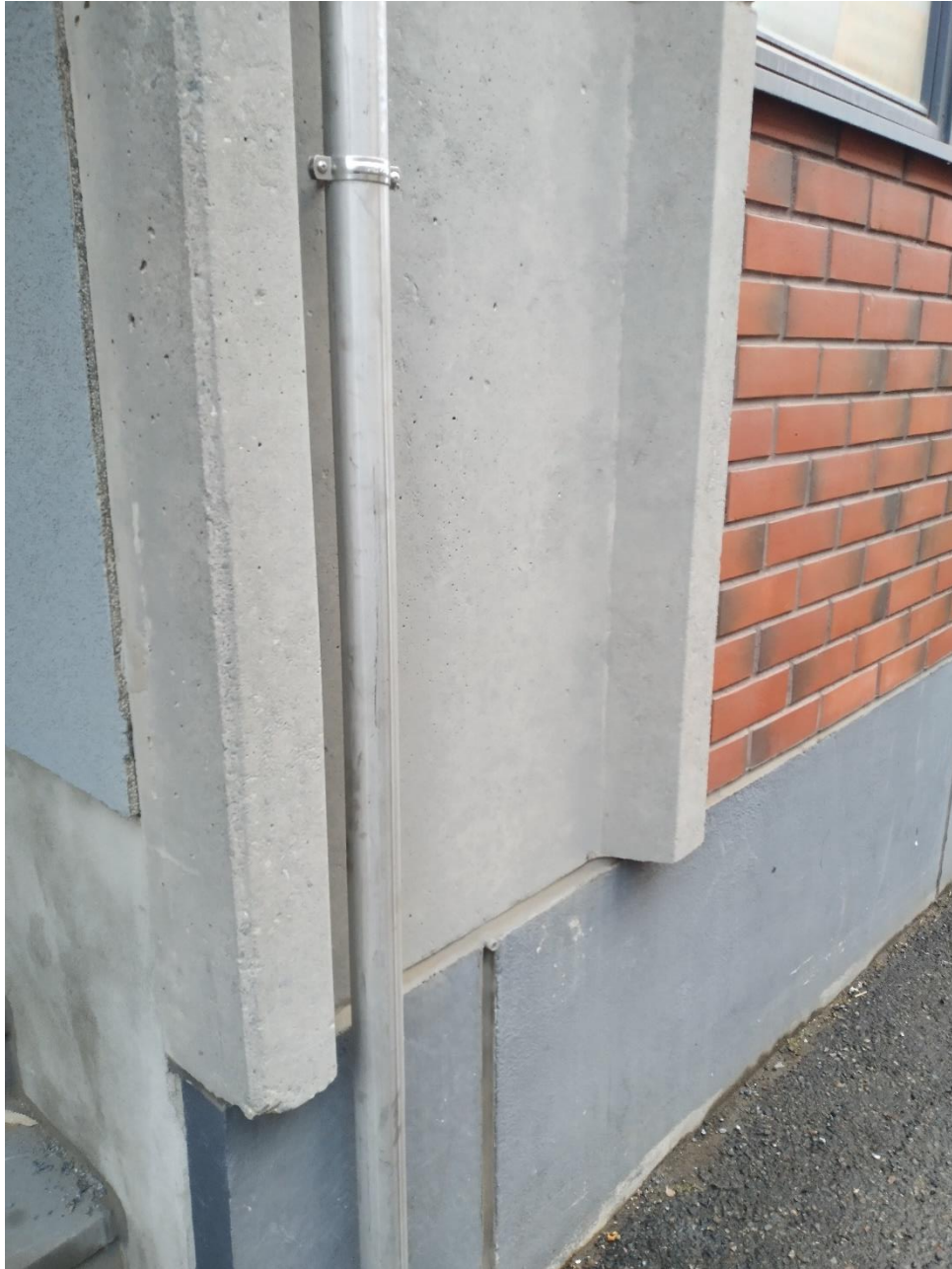
Kuva 43 Julkisivun kovera pilari, tiilipintaa ja maalattu sokkeli. Kuva Anniina Grönholm 2021 ARCO Architecture Company Oy
