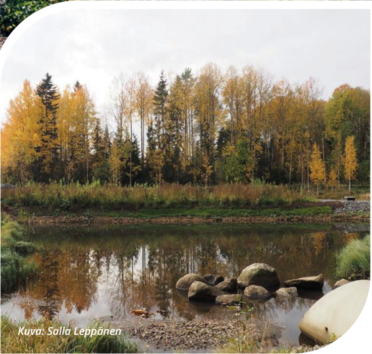
Kuva 21 Etuhaanpuistoon on rakennettu hulevesialtaat ja suotopenger Hervannan hulevesien puhdistamiseen ja viivyttämiseen. Suotopenkereessä on käytetty suodatinmateriaalina muun muassa kevytsoraa, joka poistaa hulevedestä epäpuhtauksia. Lisäksi altaissa on vesikasvimattoa, joka sitoo ravinteita hulevedestä. Tutkimusten mukaan järjestelmä pidättää keskimäärin 65 prosenttia kiintoaineesta. Hulevesikohde toimii samalla elinympäristönä muun muassa vesilinnuille, karpälle ja vesimyyrälle.
