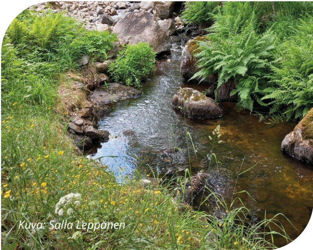
Kuva 48 Pärrinkoskelle rakennettu kalatie.
