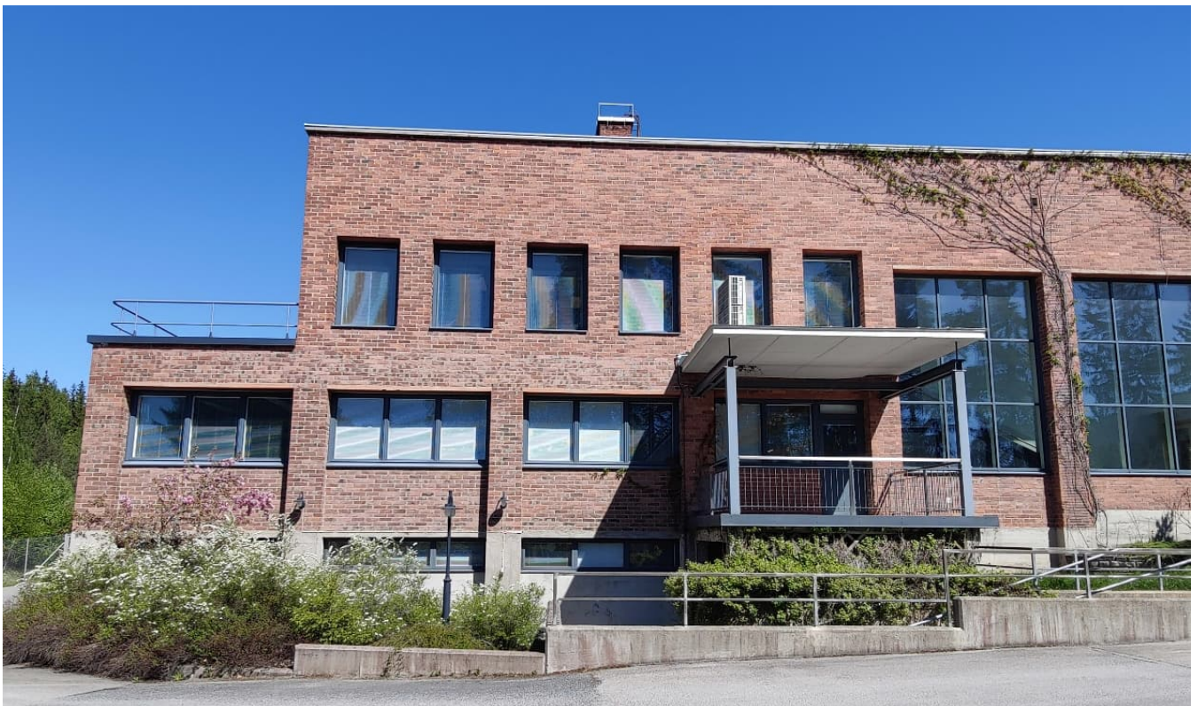
Kuva 33: Konttoriosan 2. kerroksen vuonna 1969 rakennettu laajennus erottuu suorakaitteen muotoisista ikkunoista ja hieman erisävyisestä muurauksesta.
