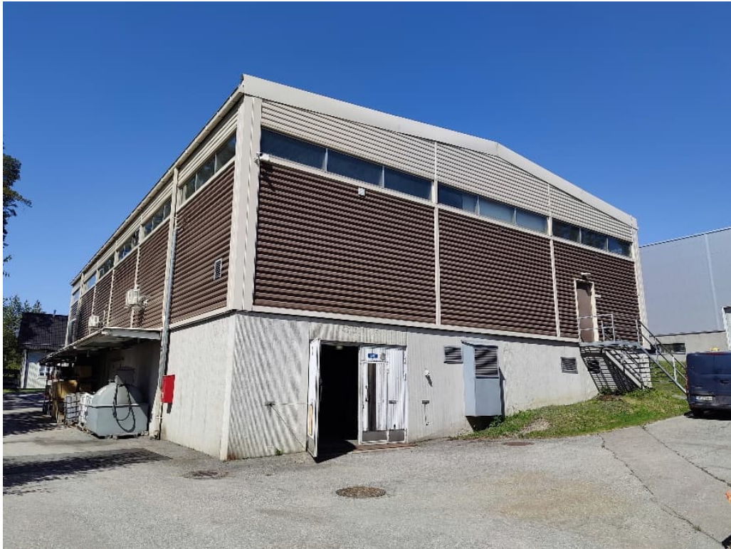
Kuva 57: Teräshalli lounaiskulmalta katsottuna
