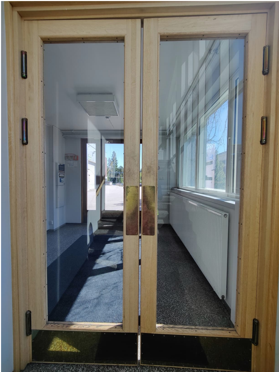
Kuva 42 Porrashuoneen väliovet konttoriosasta katsottuna. Ovet ovat todennäköisesti alkuperäiset.
