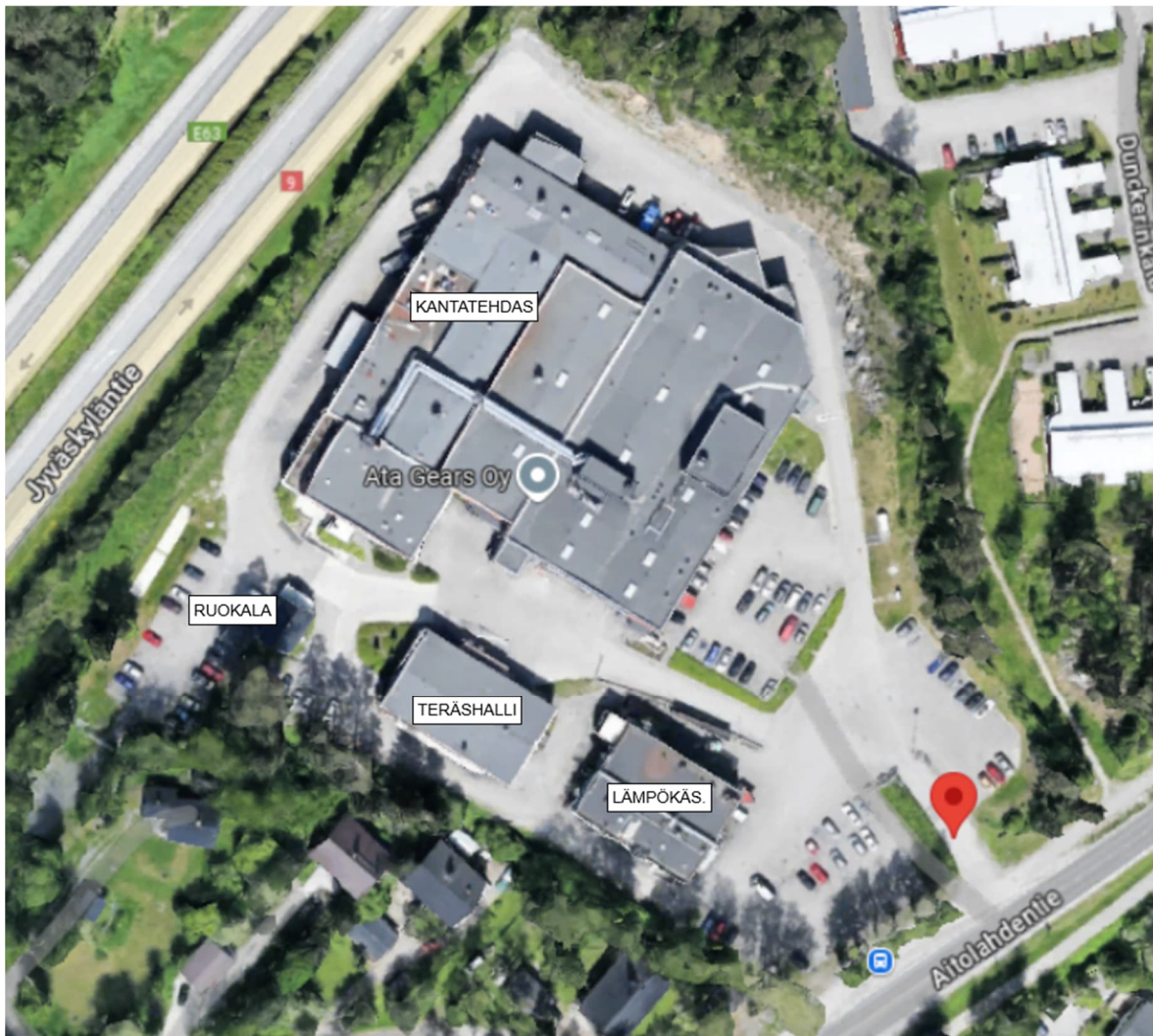
Kuva 5. Tehdasalue nykytilassaan ja tehdasalueen rakennukset. Kuva: Googlemaps. Lisätty rakennusten nimet.
