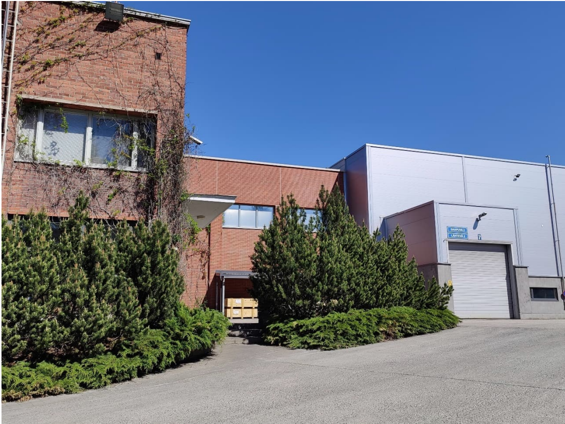
Kuva 53: Kantatehtaaseen liittyvä 1997 rakennettu laajennus muodostaa tiili-laattapintaisen nivelosan kantatehtaan ja uuden paroc-rakenteisen vuonna 2004 rakennetun laajennuksen väliin. Julkisivussa on mukailtu vanhaa julkisivua ikkunajaon ja pilasterien avulla, mutta elementtisaumat ja tiilen tasalaatuisuus paljastavat myöhemmän rakennusajankohdan.
