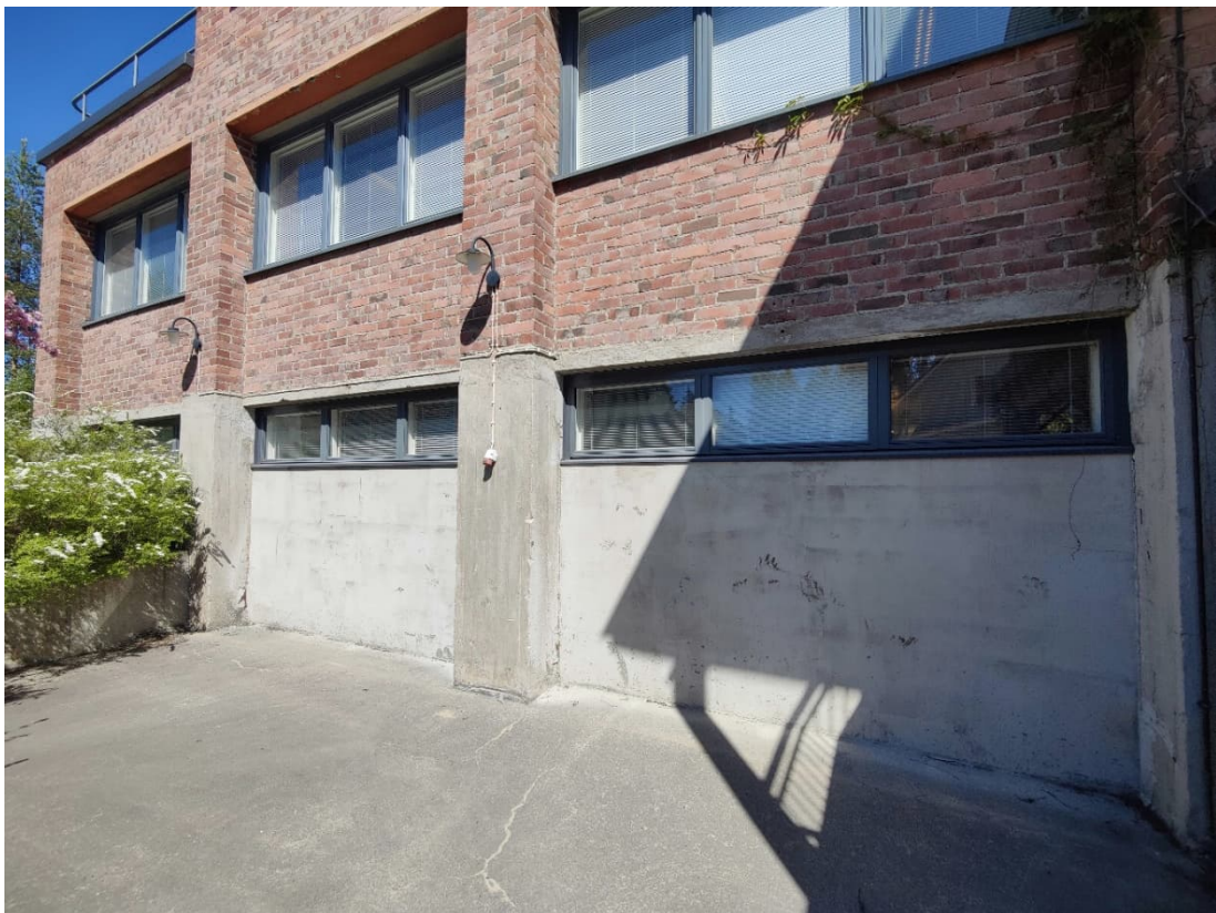
Kuva 36 Alkuperäiset autotallien ovet on ummistettu konttoriosan 1. kerroksessa eteläsivulla. Ovet muutettiin ensin ikkunoiksi, ja ikkunoita pienennettiin ja betoniosat uusittiin lupakuvien mukaan 2003.
