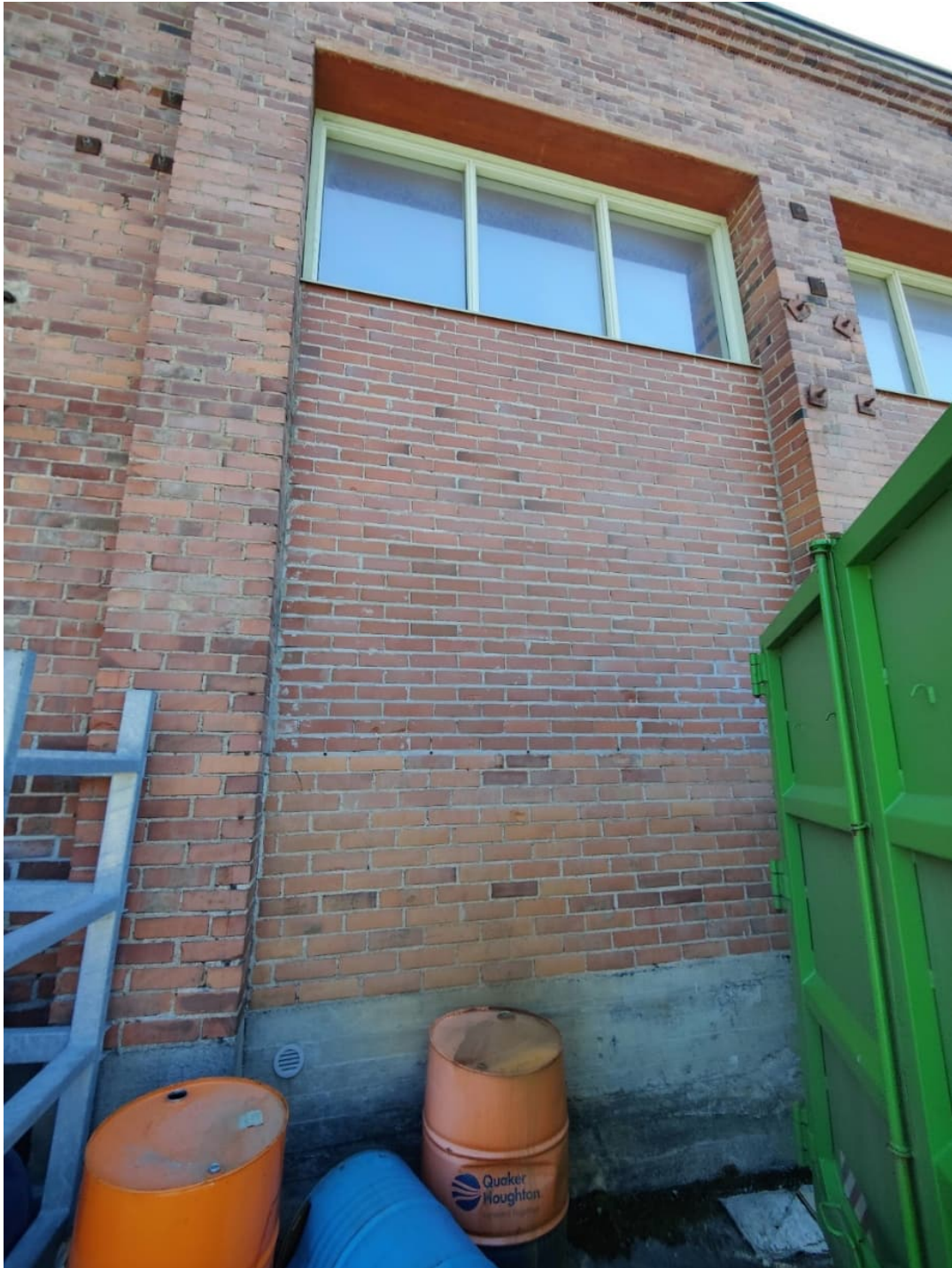
Kuva 51: Kantatehtaan vuonna 1997 tehty ikkunoiden pienennys on havaittavissa vaaleampana ja tasalaatuisempana muurauksena moottoritien puoleisella sivulla.
