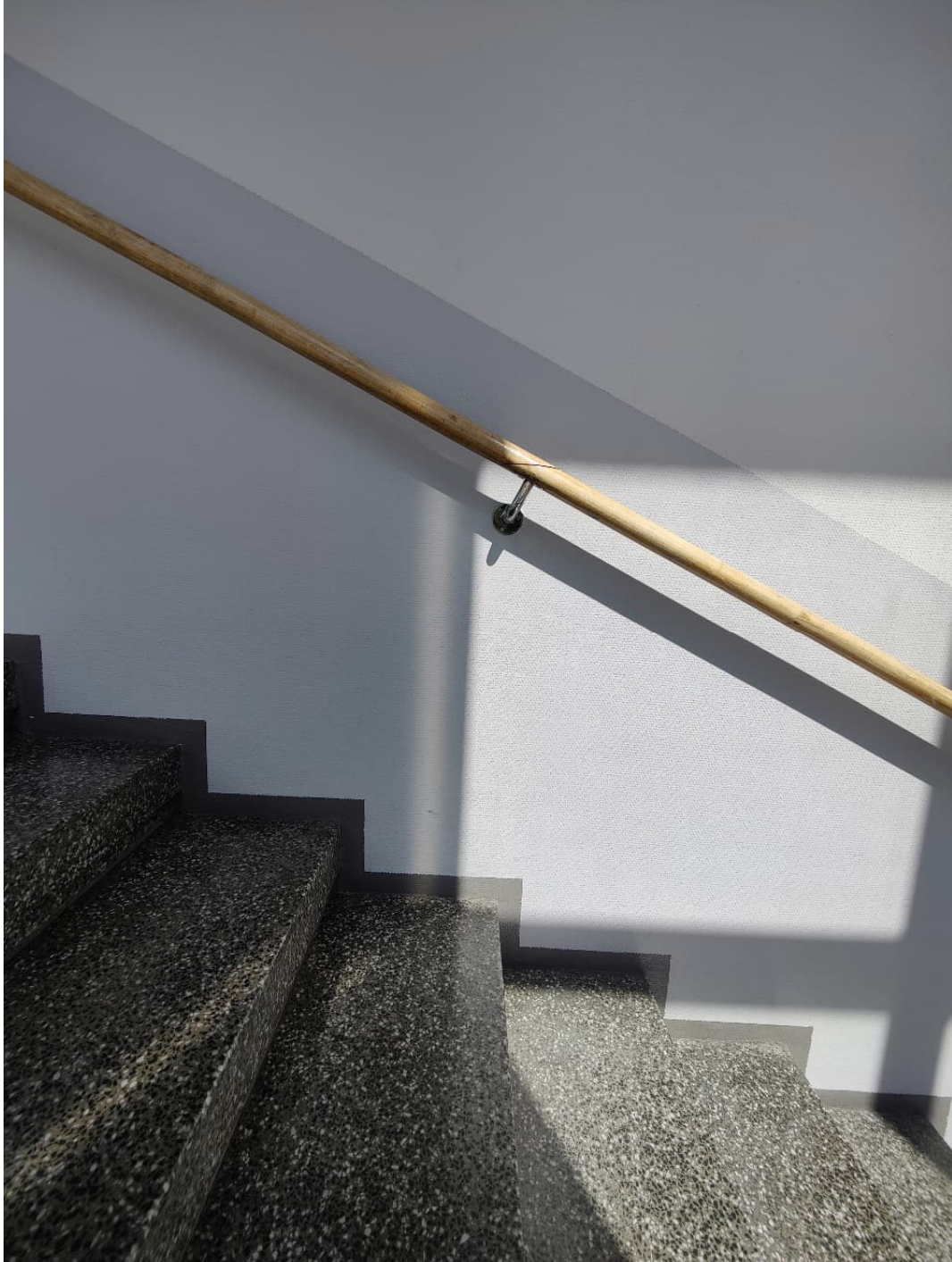
Kuva 41: Porrashuoneen puukaide ja seinän maalaus. Porrashuoneen pinnat ovat hyvässä kunnossa ja tiloja on uusittu alkuperäistä tyyliä kunnioittaen.
