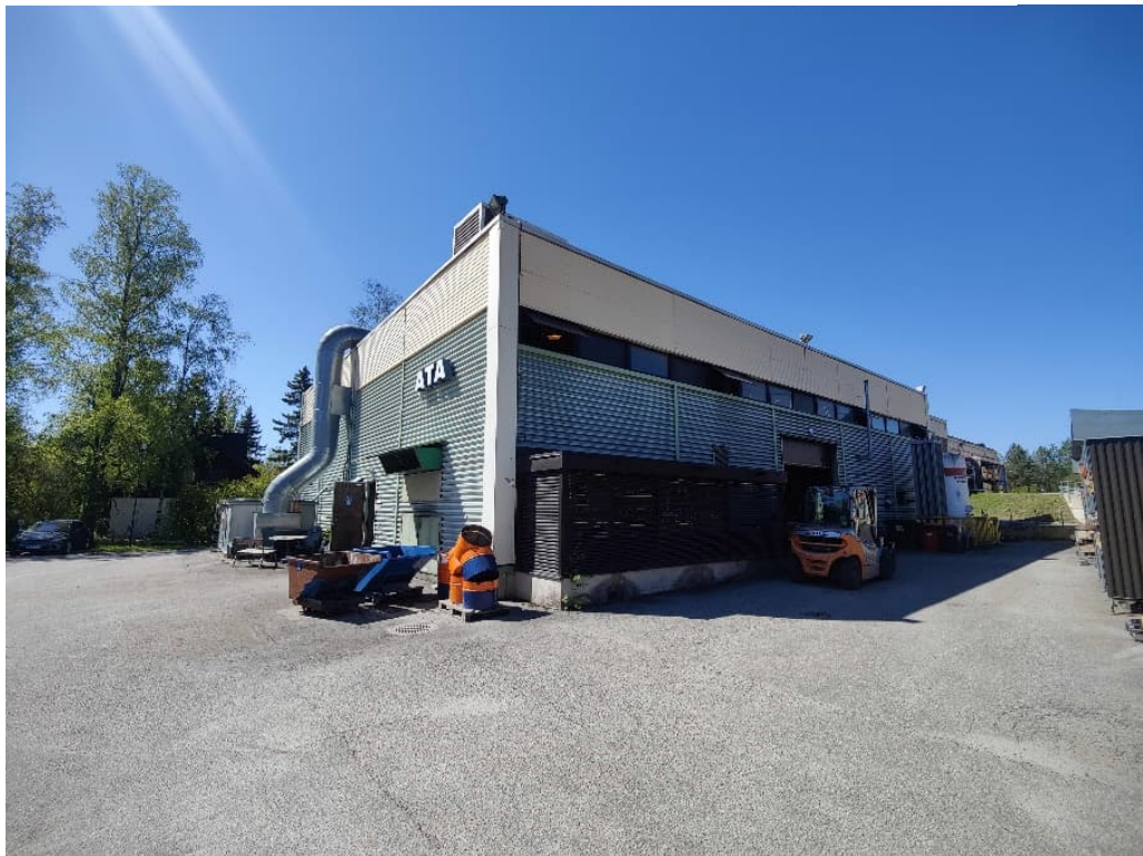
Kuva 23: Lämpökäsittelyrakennus rakennuksen kaakkoiskulmalta kuvattuna.
