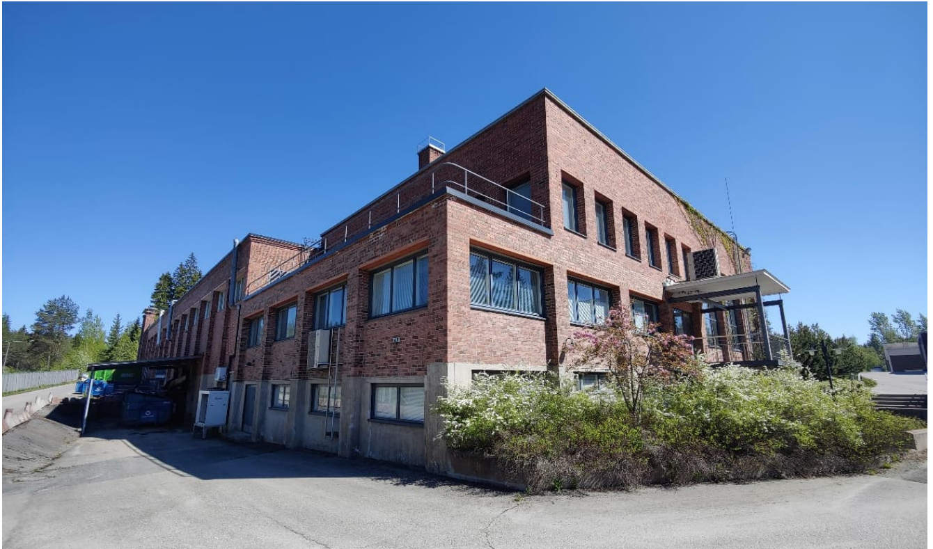
Kuva 32: Konttorirakennus lounaskulmalta. Vasemmalla näkyy 1973 rakennettu tiilimuurattu laajennusosa.
