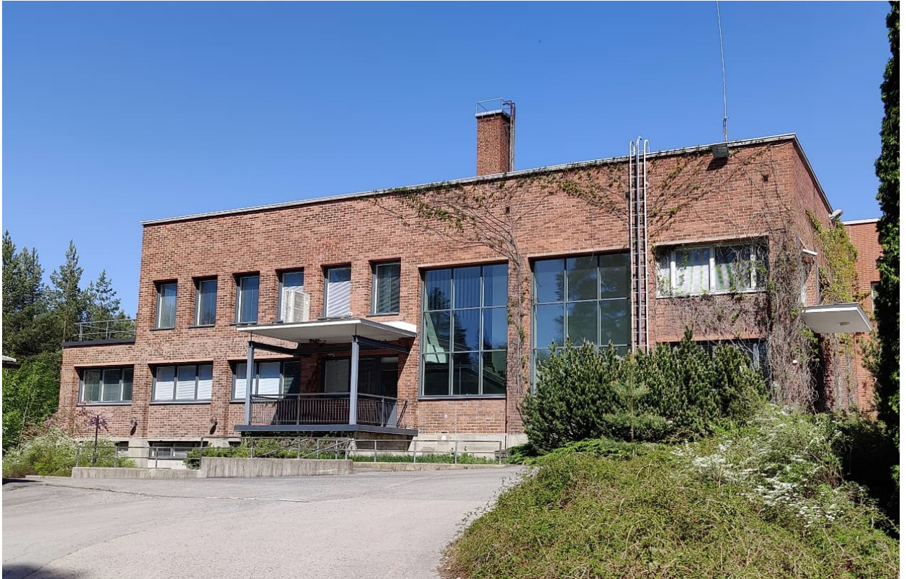
Kuva 34: Porrashuoneen lasiseinä on uusittu metallirunkoiseksi järjestelmälasiseinäksi, ja alkuperäistä ruutujakoa on yksinkertaistettu jättämällä välipuitteet pois. Puitteiden väri on uusimisen yhteydessä muutettu valkoisesta harmaaksi.
