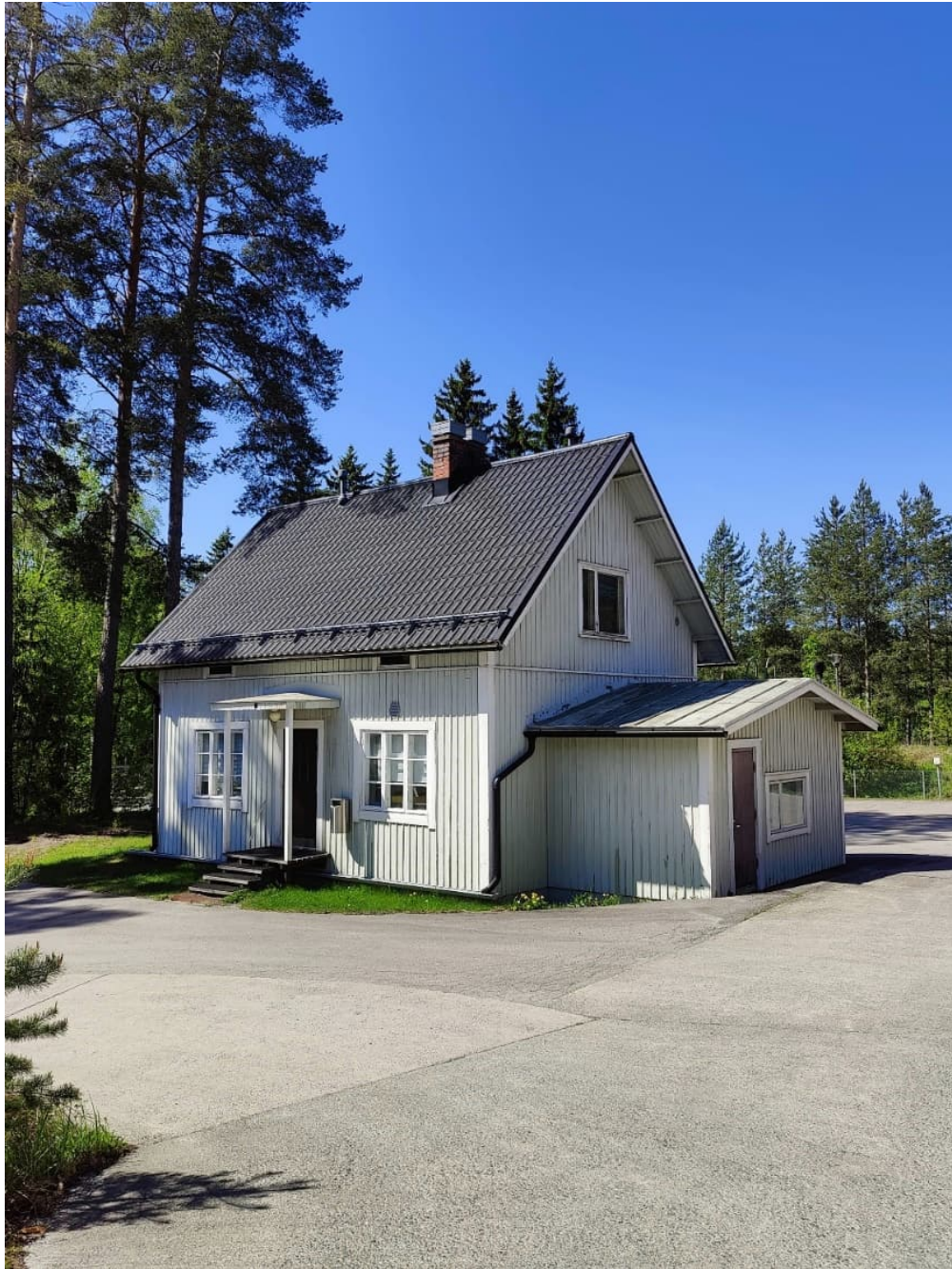
Kuva 59 Ruokalarakennus on säilynyt ulkomuodoltaan pitkälti muuttumattomana. Uusittu peltikate erottuu lumiesteineen matalamman osan vanhemmasta saumapeltikatteesta.
