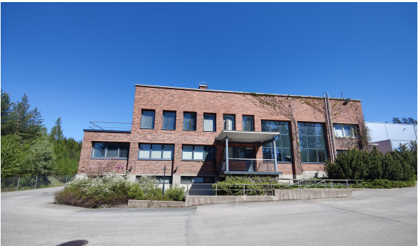
Näkymä 2, Konttoriosa, kuvausajankohta toukokuu 2024
