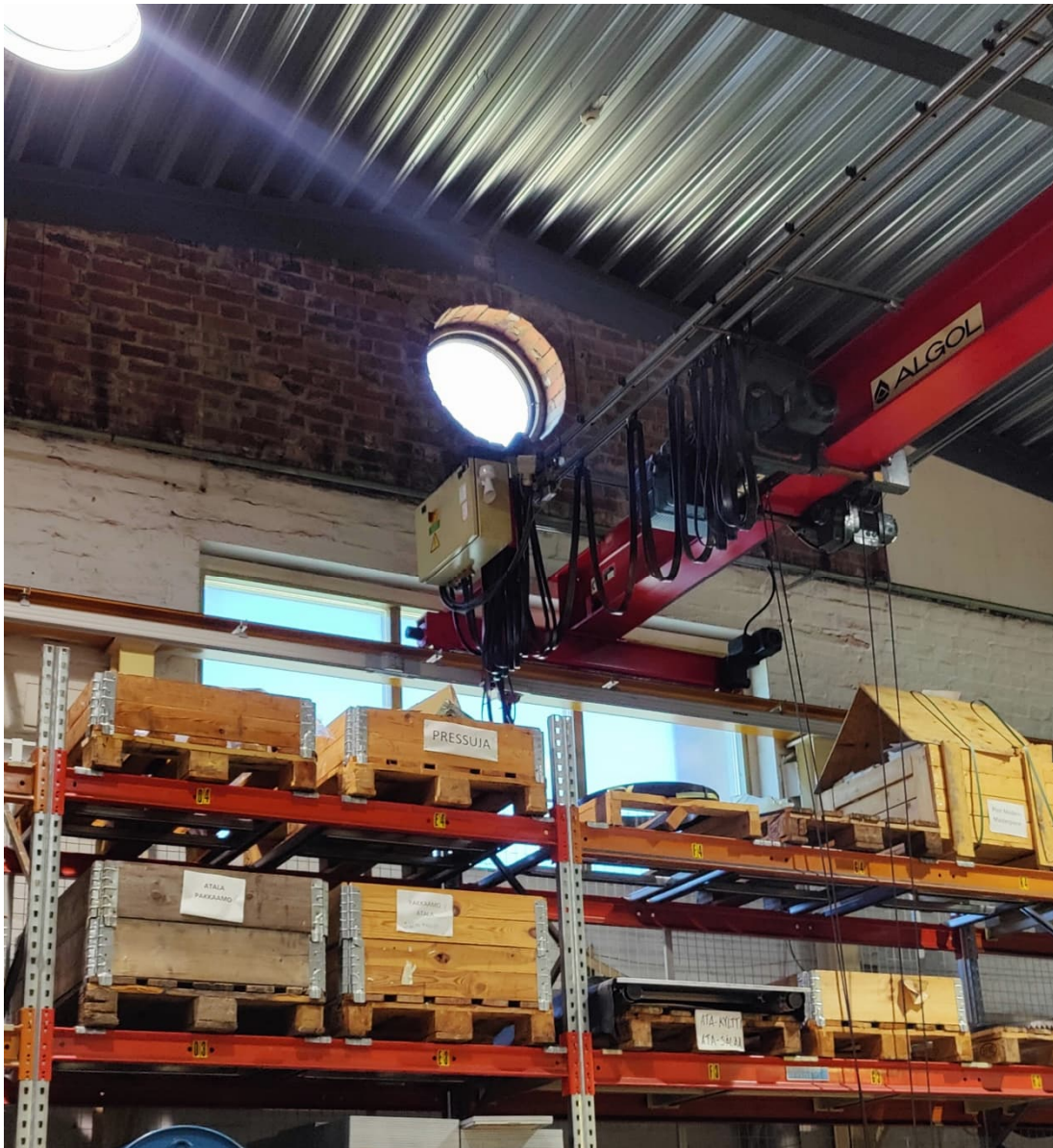
Kuva 49: Vuonna 1960 rakennetun laajennuksen päätyjulkisivun pyöreä ikkuna on nähtävissä myös tehtaan sisäpuolelta. Yläpohjarakenne on sittemmin muutettu puurakenteisesta teräsrakenteiseksi.
