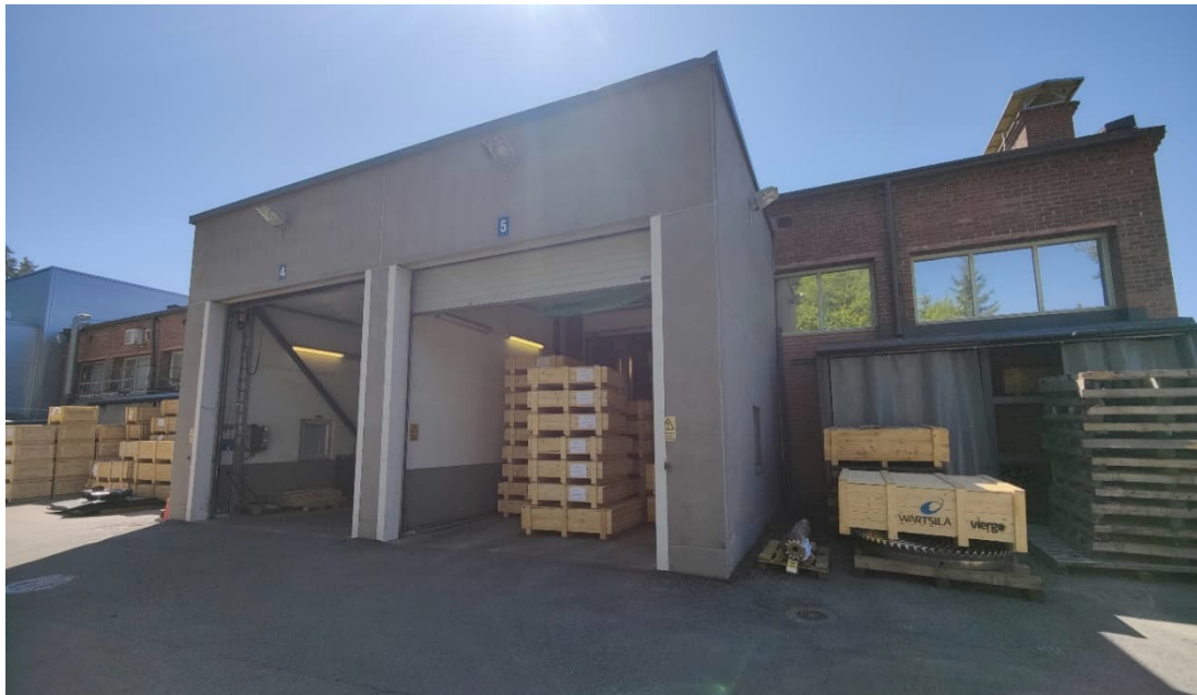
Kuva 37 Rakennuksen luoteissivun julkisivua. Vanha tiilijulkisivu on jäänyt osittain uuden betonielementtirakenteisen lastausrakenteen ja katosrakenteiden taakse.
