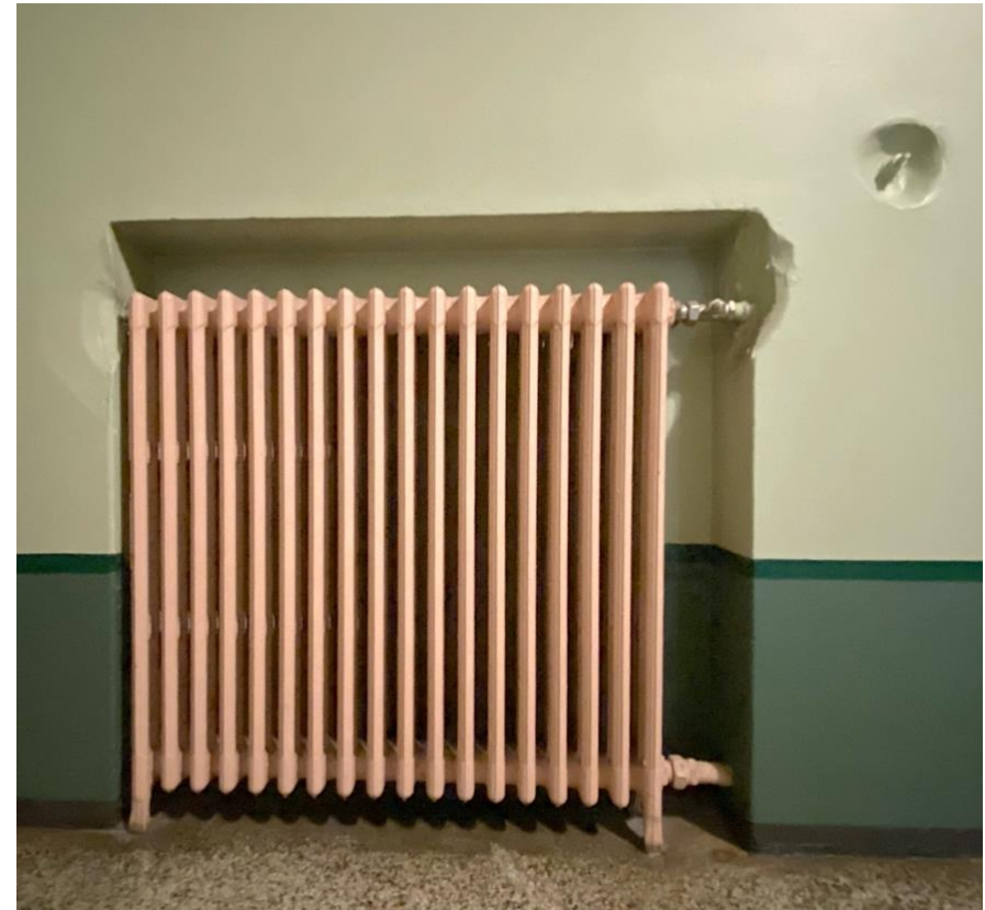
Kuvat 62.-63. Vanhaa myymälän lattialaatoitusta ja lämmitystekniikkaa liiketilassa ja porrashuoneessa.
