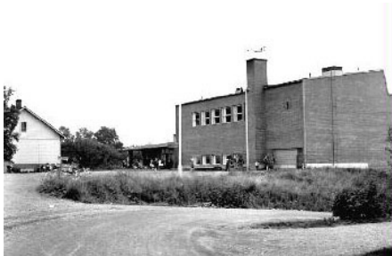
Vastavalmistunut tiilikoulu v. 1955
