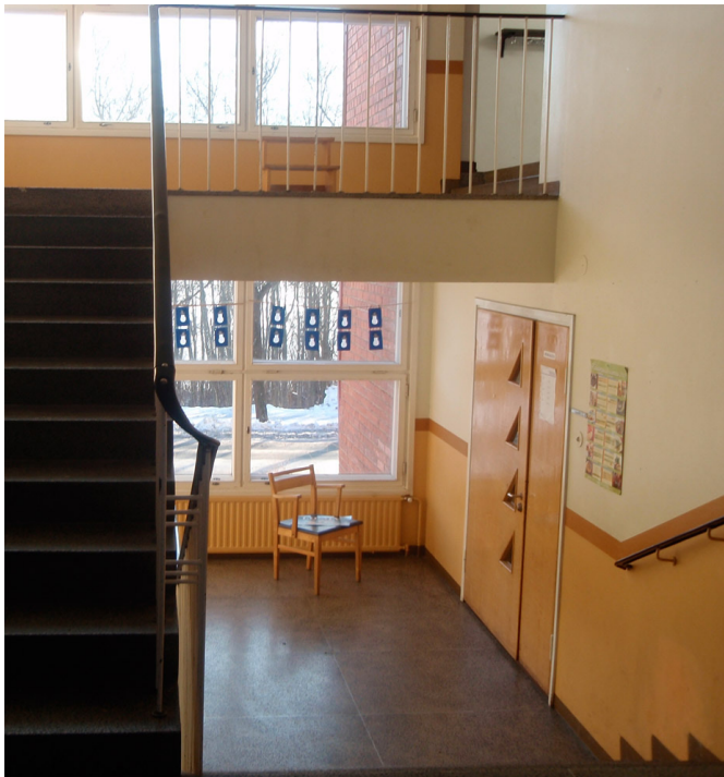
Tiilikoulun sisääntuloaula. Portaat ja porrastaseet ovat mosaiikkibetonia.
