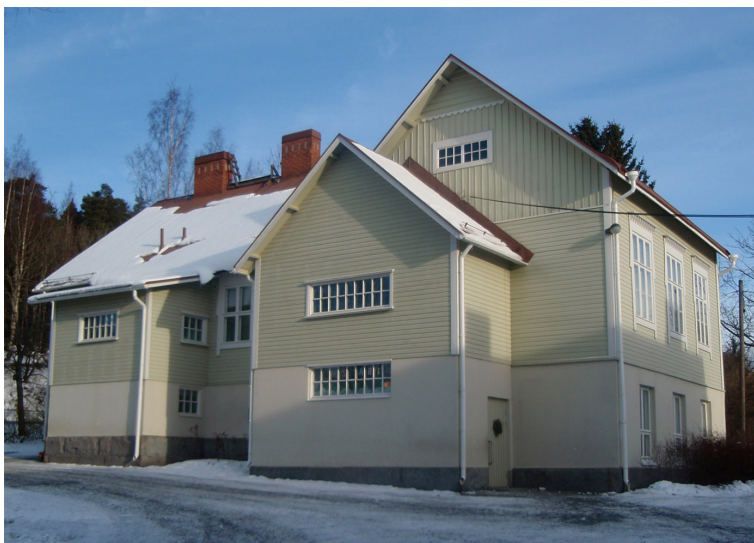
Puurakennus 2 keväällä 2009. Sisäänkäynti kuistit on muutettu, rakennukset julkisivut on maalattu 2000-luvun alkuvuosina.
