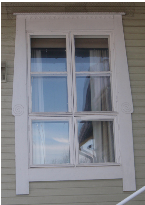
Ikkunat on uusittu 1950-60 luvulla, vuorilaudat ovat alkuperäiset.
