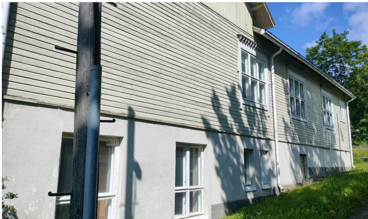
Kuva 12. Koulurakennuksista ei löydetty merkkejä lepakoista. Rakenteet ovat tiiviit.
