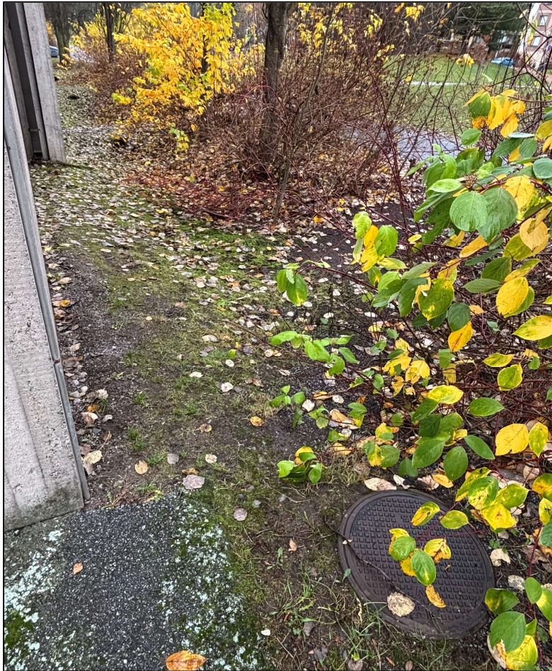
Kuva 5. Olemassa olevan rakennuksen pohjoispuoli, tarkastuskaivo.
