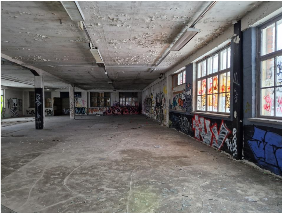
Kuva 7. Ylimmän kerroksen hallitilaa. Suuret ikkunat eivät antaisi lepakoille kesäaikaan viihtyisää hämärää oleskelutilaa. Myös lepakoille sopivia rakoja seinissä tai katossa oli hyvin vähän.
