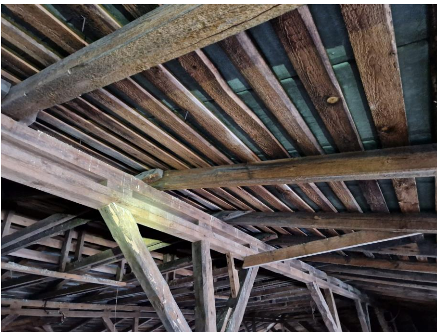
Kuva 10. Ullakon kattorakenteet soveltuvat huonosti lepakoiden lepäilyyn. Puisten parrujen väliin lepakko voisi mahtua, mutta suoraan parrujen päälle sijoitettu peltikatto kuumenee kesäisin todennäköisesti huomattavasti, muodostaen lepakoiden epämiellyttävän paikan levähtää.
