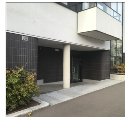
Sisäänkäyntisyvennys laattapinnoin korostettuna. Kuva: Tampereen kaupunki.
