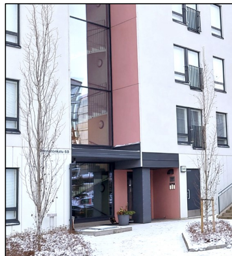
Sisäänkäynti ja porrashuone syvennyksessä Lentävänniemen keskustan eteläosassa. Kuva: Tampereen kaupunki.
