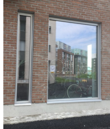
Ikkunallinen pyörävarasto katujulkisivussa. Kuva: Tampereen kaupunki.
