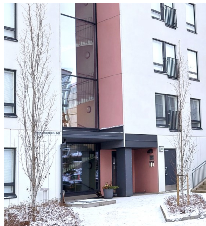
Sisäänkäynti ja porrashuone syvennyksessä. Kuva: Tampereen kaupunki.
