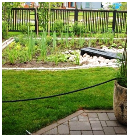
Hulevesien käsittelyalue sadepuutarhassa. Kuva: Tampereen kaupunki.
