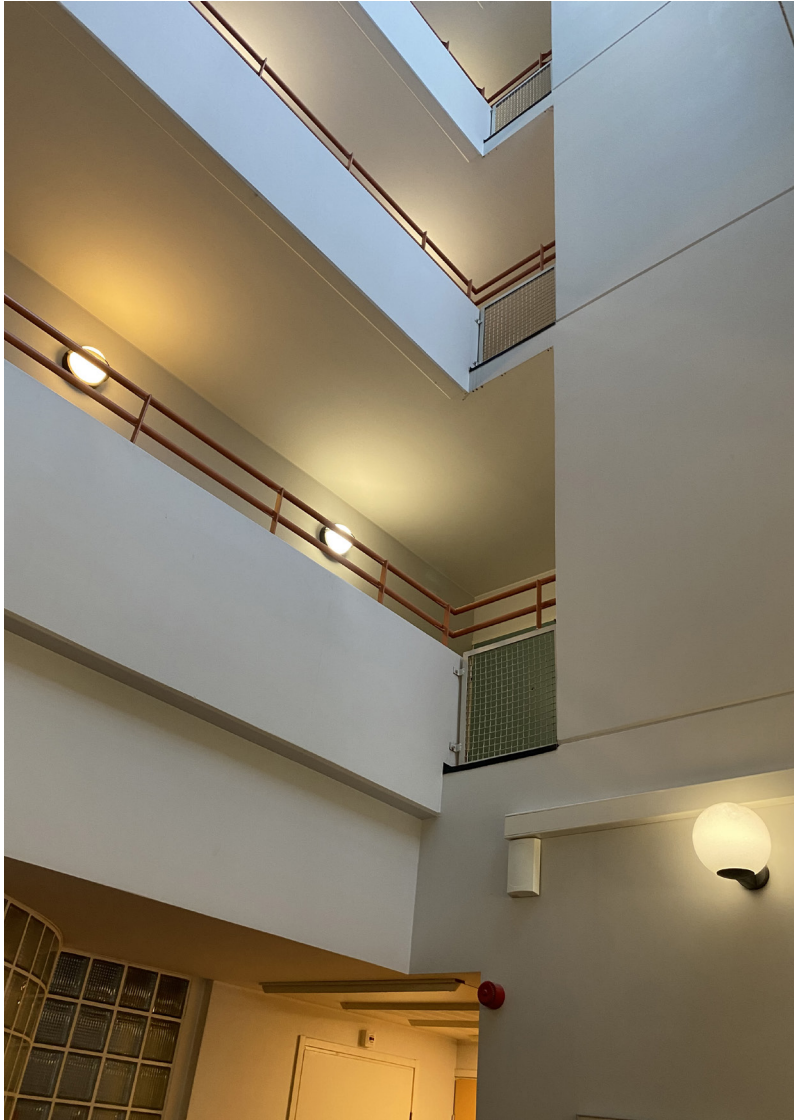
↑ Kuva 45. Näkymä aulasta. Aula yhdistyy valoaukon kautta asuntokäytäviin ja sieltä kattoikkunaan. Asuntokäytävillä umpikaide, jonka päällä metallinen värikäs käsi-johde. Yleisilme on modernistinen, linjakas ja valoisa.
