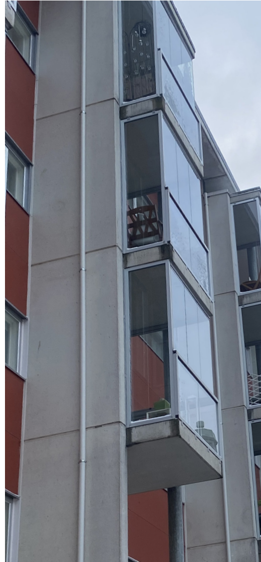
↑ Kuva 43. Vuoden 2004 täydennysrakennuksen Ilmarinakadun puoleinen parveke. Parvekkeella betonipie-li, toisella puolella teräspilarikannatus. Parvekkeella avattava lasitus.
