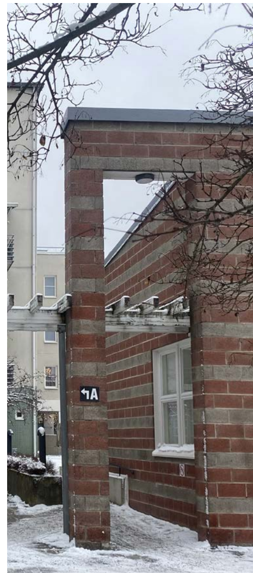
↑ Kuva 41. Päiväkodin kadunpuoleista julkisivua Aaltosenkadulle. Samantapainen ratkaisu myös Vellamonkadun puoleisella julkisivulla. Ulkoseinä jatkuu porttimaisena ja muurimaisena katua myötäillen.
