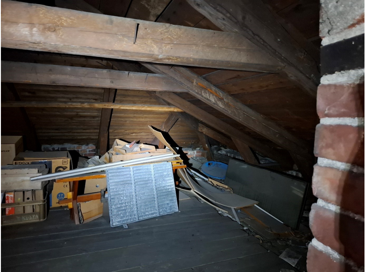
Kuva 3-1. Hotellirakennuksen varastokäytössä oleva ullakotila.
