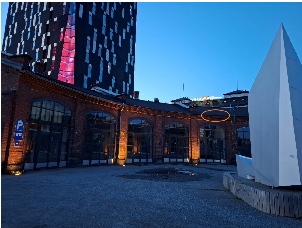
Kuva 3-4. Vanhan veturitallin rakennus, jonka katon rajassa pesii tervapääsky. Pesä ei näy ulospäin. Pesän sijainti on ympäröity oranssilla.
