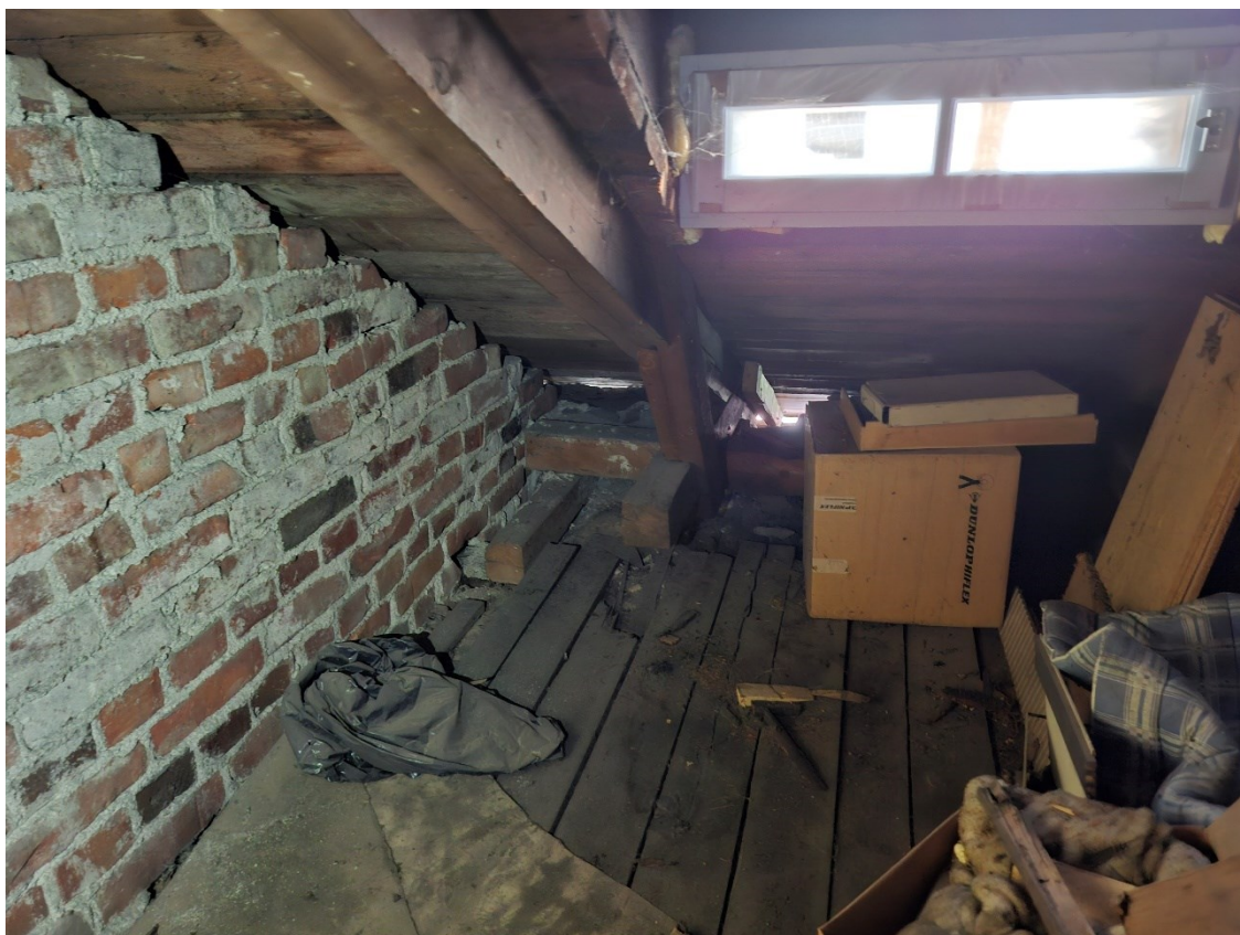
Kuva 4-1. Hotellirakennuksen ullakkotilojen tukitut ikkunat. Tiiliseinässä näkyy kuitenkin rakoja, joita lepakot voisivat mahdollisesti hyödyntää kulkuaukkoina.
