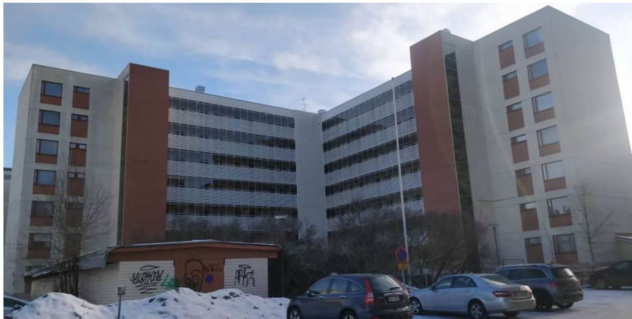
Kuva 16 Rakennus luoteesta päin kuvattuna. L-muotoisen rakennusmassan sisäkulmassa sijaitsevat luhtikäytävät ja niiden päissä kylmät porrashuoneet.
