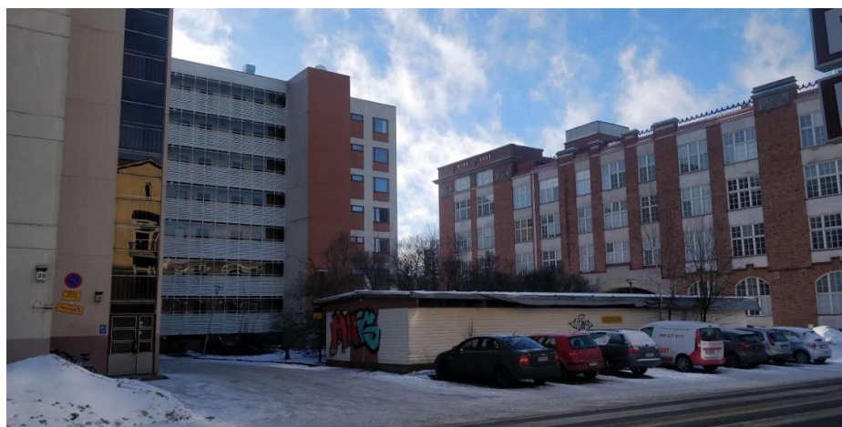
Kuva 20. Kuva koillisesta päin. Tontin pohjoislaidalla oleva talousrakennus ja sen takana autopaikat, joista peruutetaan suoraan kadulle.
