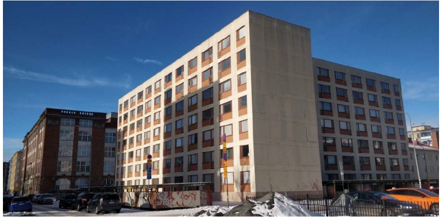
Kuva 15 Ote asemakaavamuutoksen Rakennetun kulttuuriympäristön selvityksestä. Taka-alalla Aaltosen kenkätehdas ja etualalla Pitsnoukka. Oikeassa reunassa pilkistää Pinkola.
