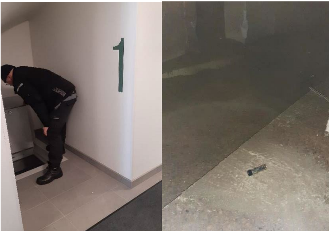
Kuvat 12a+b. Passiivikeräimen vienti kerrostalon tuulettuvaan alapohjaan huoltoluukun kautta.
