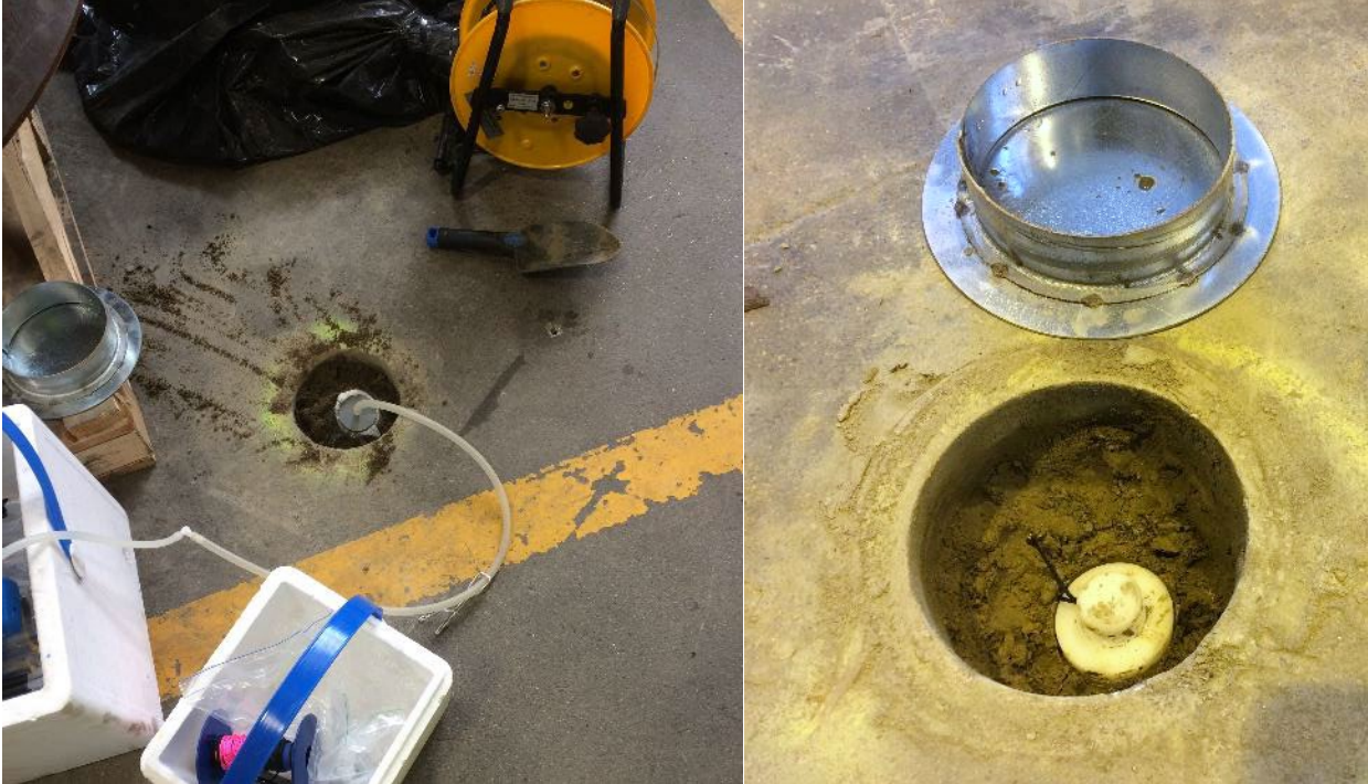
Kuvat 3a+b. Näytteenottoa teollisuusrakennuksen lattian läpi poratusta huokosilmaputkesta. Mukana peltinen suojakansi.
