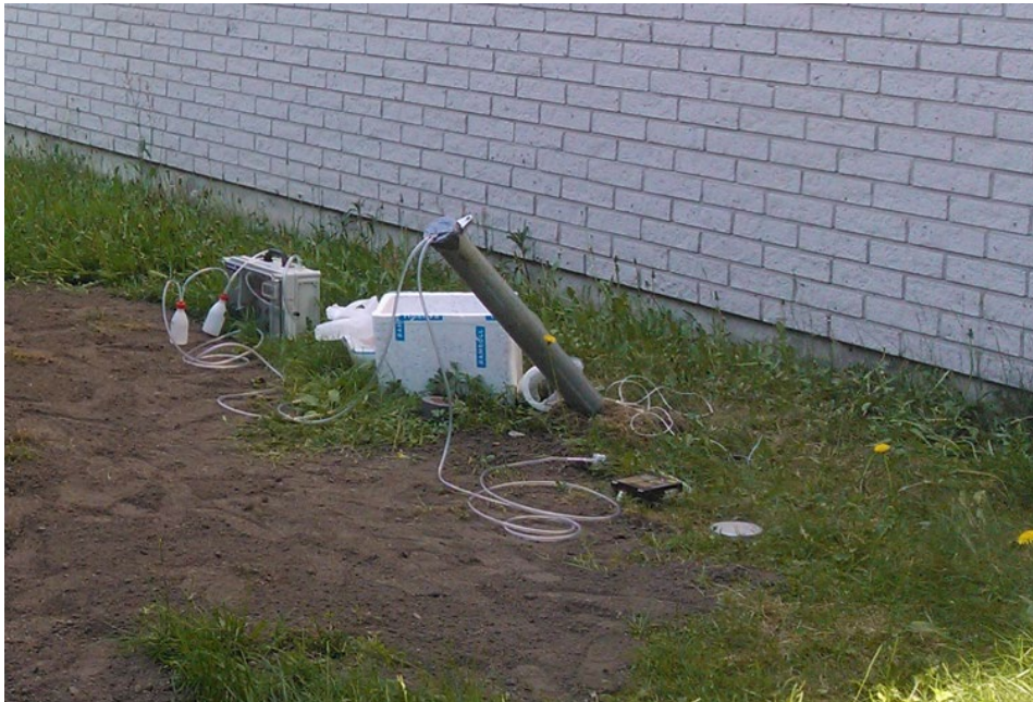
Kuva 5. Vinoa huokosilmaputki asennettuna rakennuksen alapuolelle.
