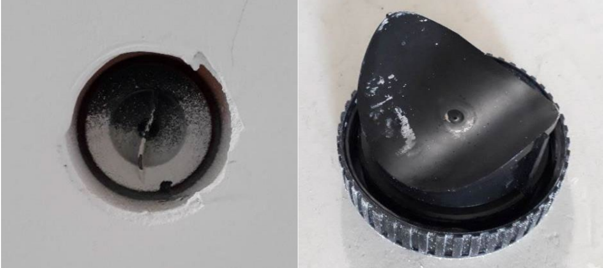
Kuvat 8a+b. Seinärakenteen sisällä sijaitsevaan radonputkistoon asennettava näytteenottoyhteen kansi.
