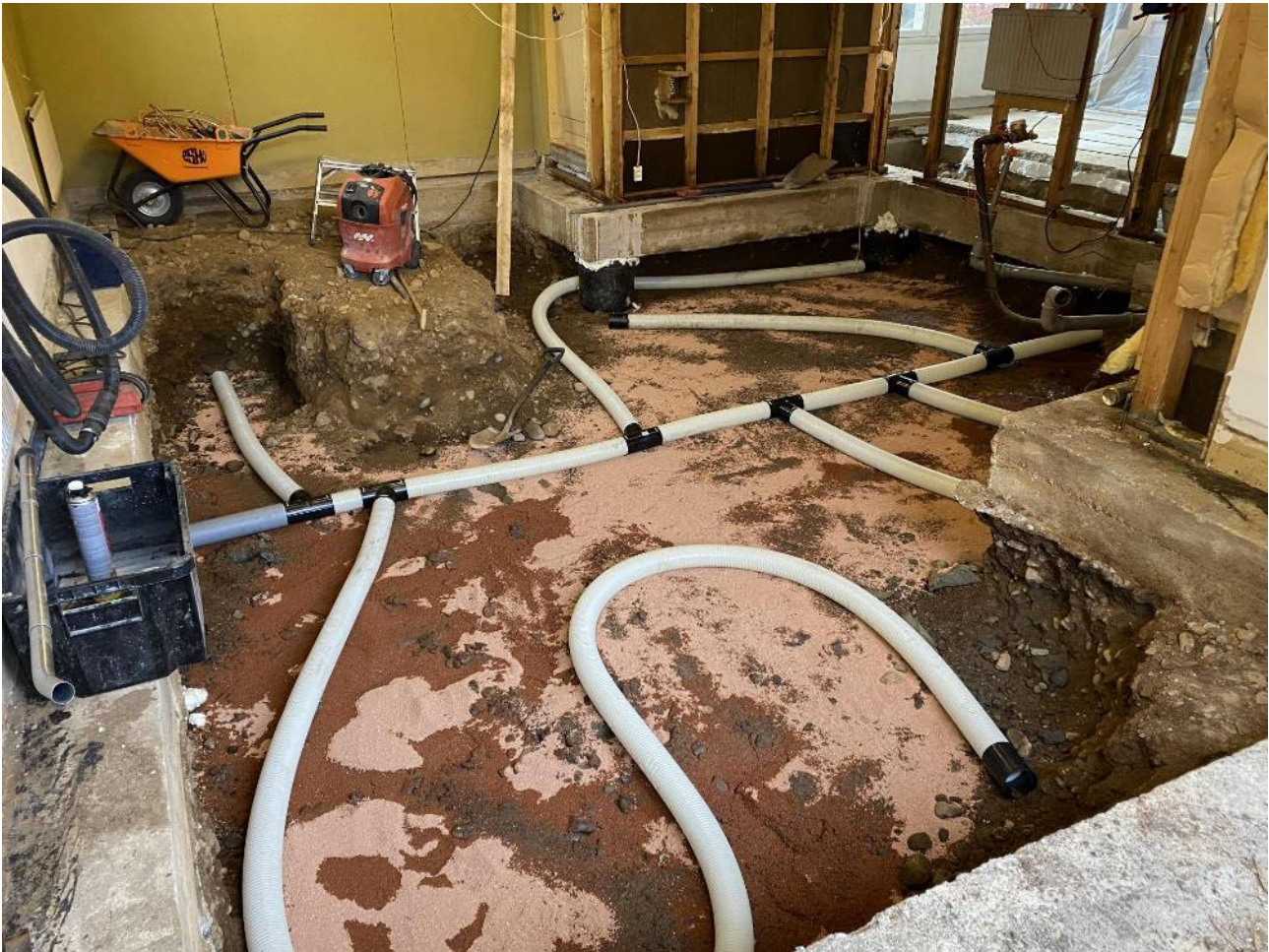
Kuva 6. Öljyvahinkokohteessa pilaantuneiden massojen poiston jälkeen kunnostusalueelle asennettu tuuletusputkisto.
