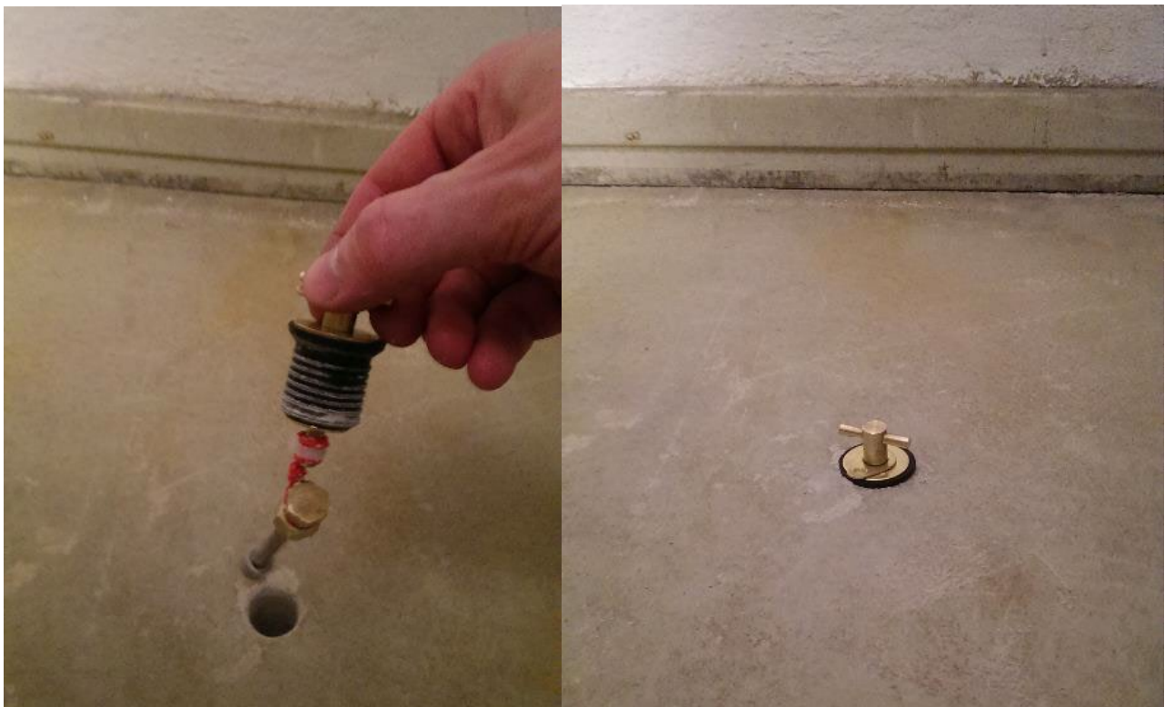
Kuvat 10a+b. Näytteenottoa varten tehty reikä kerrostalon kellarikerroksessa.
