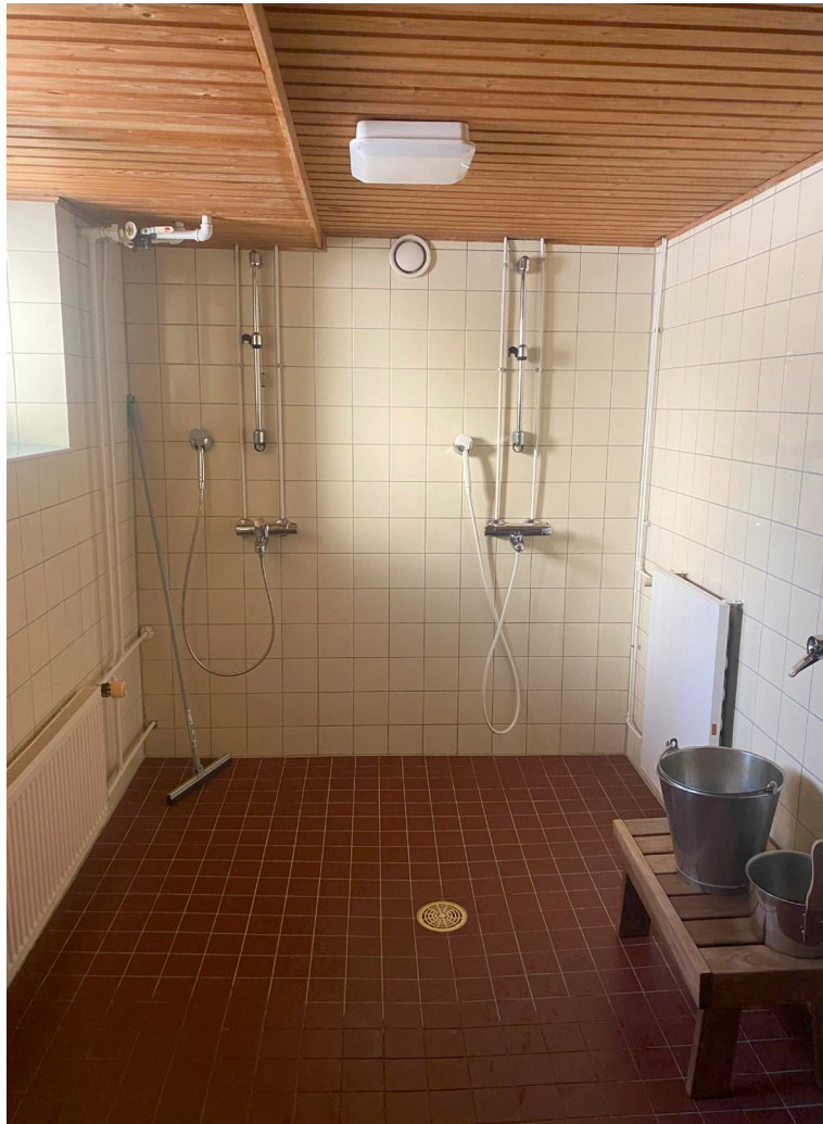
↑ Kellarikerroksen saunaosaston pesuhuone, korjaus 1990-luvulta. Korjaus 1950-luvun tyyliä kunnioittava.
