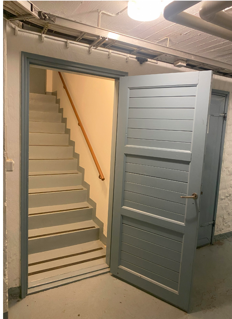
↑ Kellarikerroksen käytävien yleisilmettä ja värimaailmaa. Pinnat ja kunto silmämääräisesti 1950-luvun rakennuksen kellareille tyypillinen.
