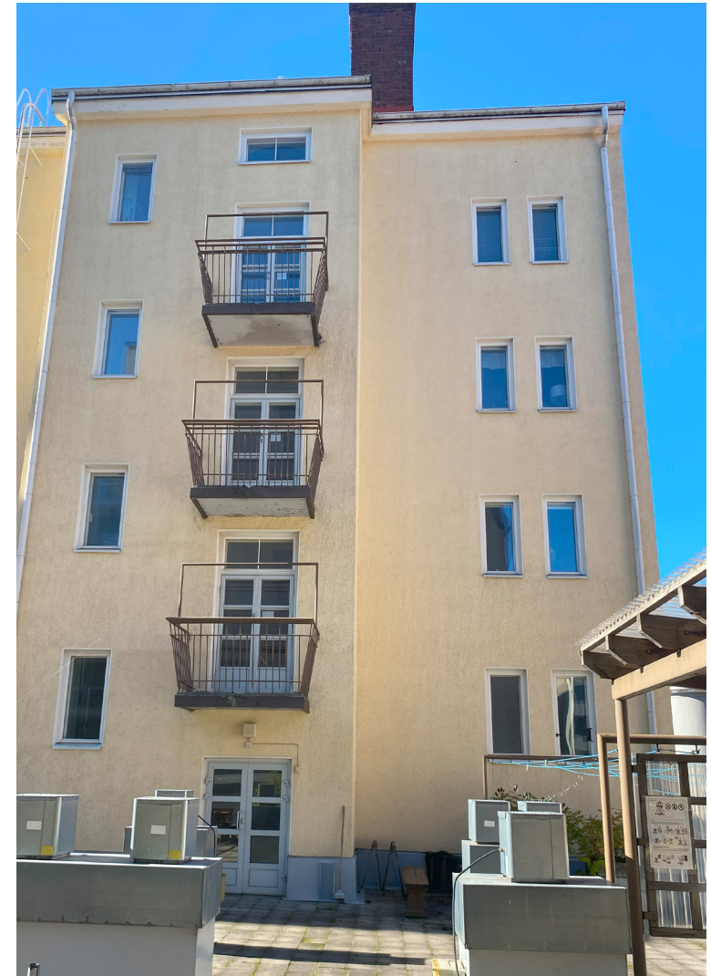
↑ Näkymä matalan rakennussiiven kattopihalta.
