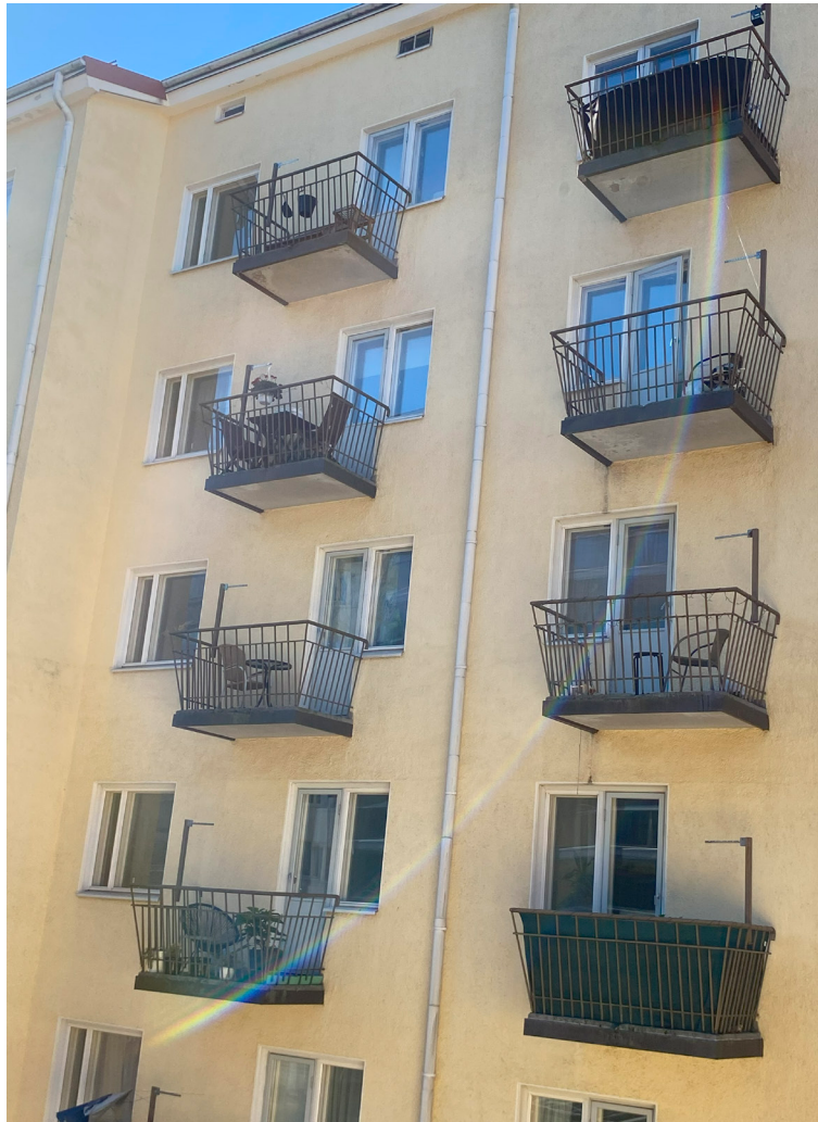
↑ Sisäpihalle avautuvia parvekkeiden kaiteita on turvallisuussyistä korotettu 1990-luvulla. Samalla on uusittu ikkunat ja parvekeovet.
