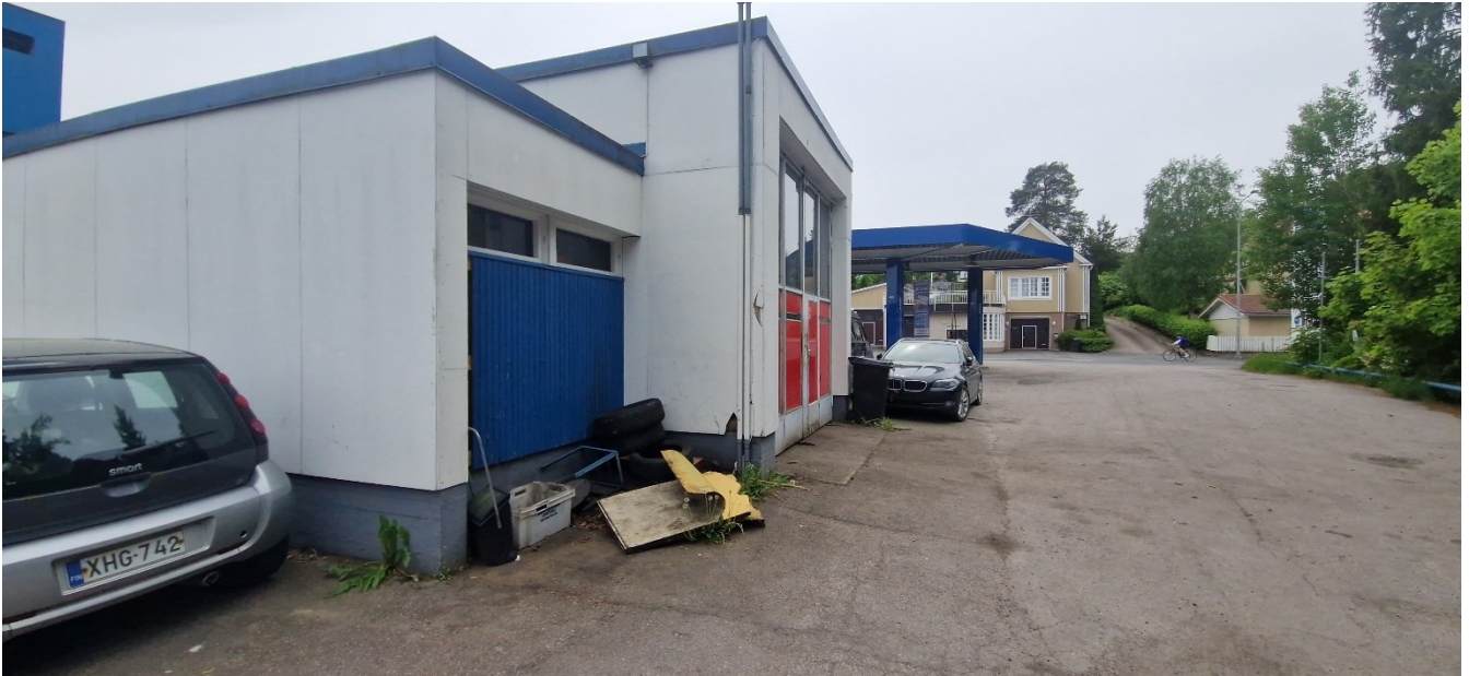
Kuva 6. Huoltamorakennus on tasakattoinen, seinät ovat levytettyjä.
